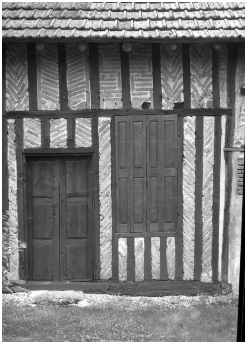
Logis annexe et remise (bâtiment B), détail de la porte et de la fenêtre.
