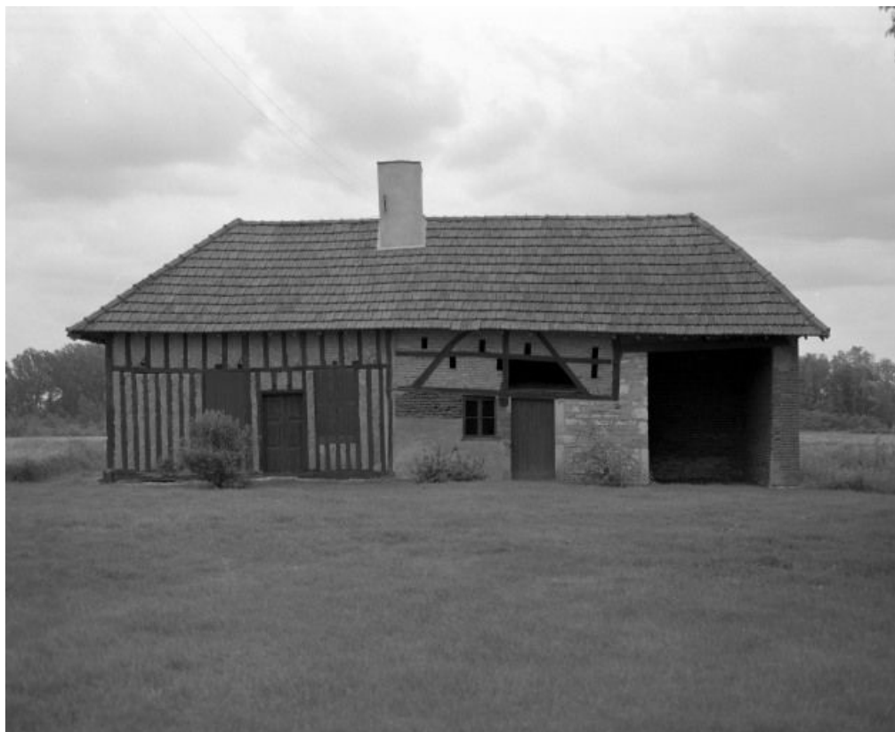
Logis annexe et remise (bâtiment B), élévation antérieure.
