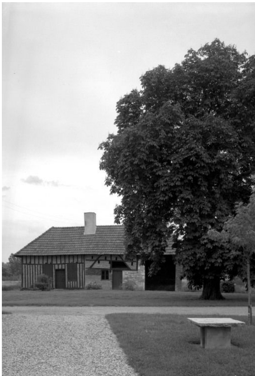
Logis annexe et remise (bâtiment B), élévation antérieure.
