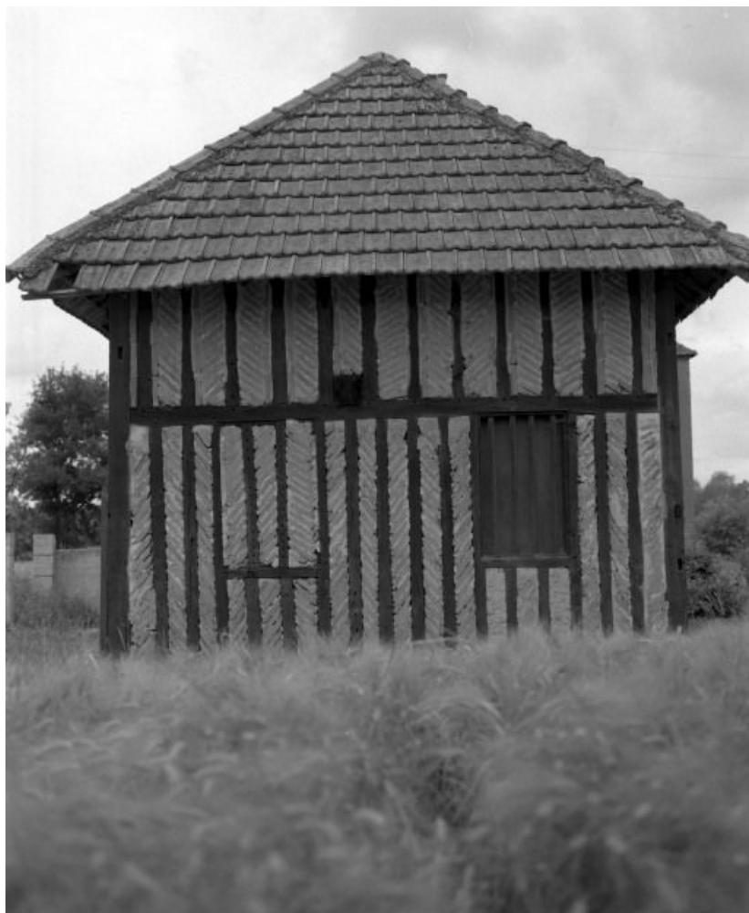
Logis annexe et remise (bâtiment B), mur de petit-pan gauche.
