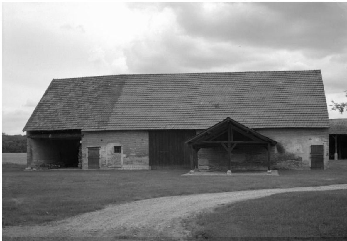
Bâtiment des dépendances (bâtiment G), élévation antérieure.
