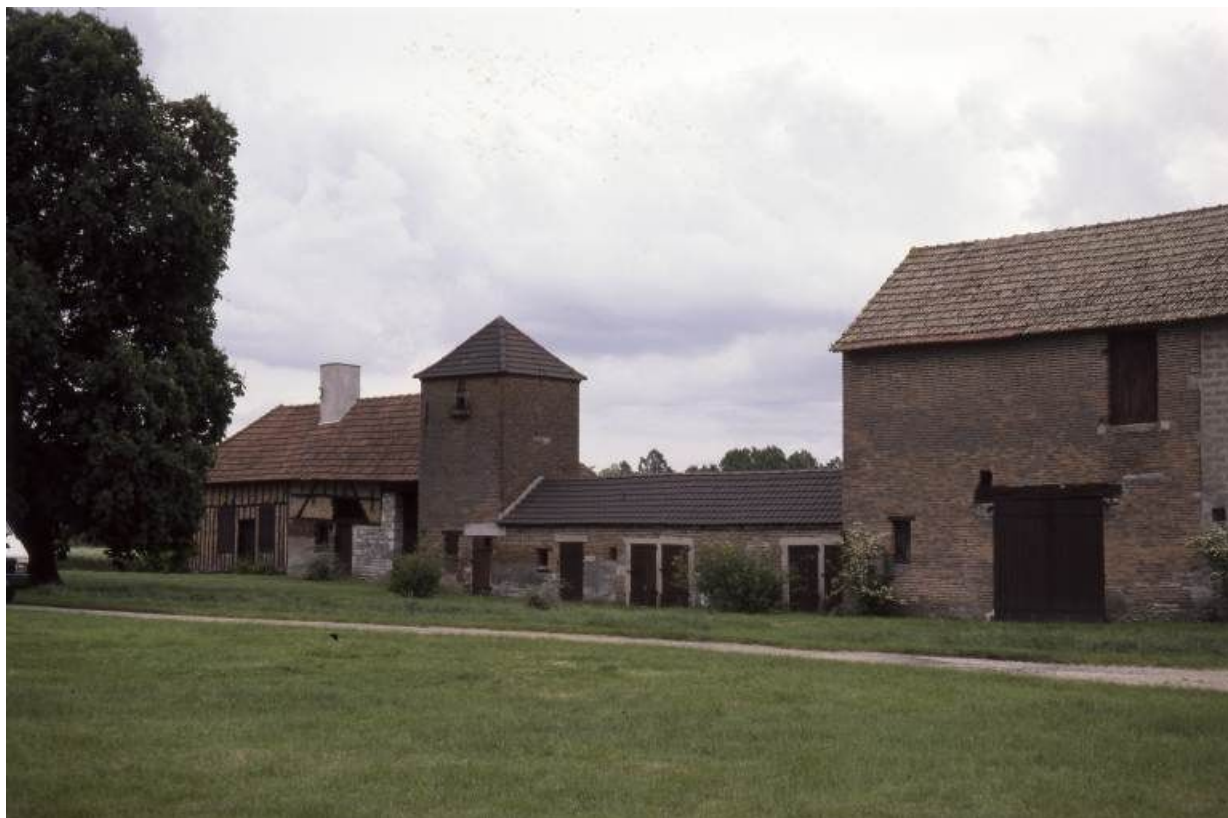
Remise, procheres, colombier (bâtiments E, D, C), élévation antérieure. 21, Bagnot, lieudit : les Granges de Bagnot
