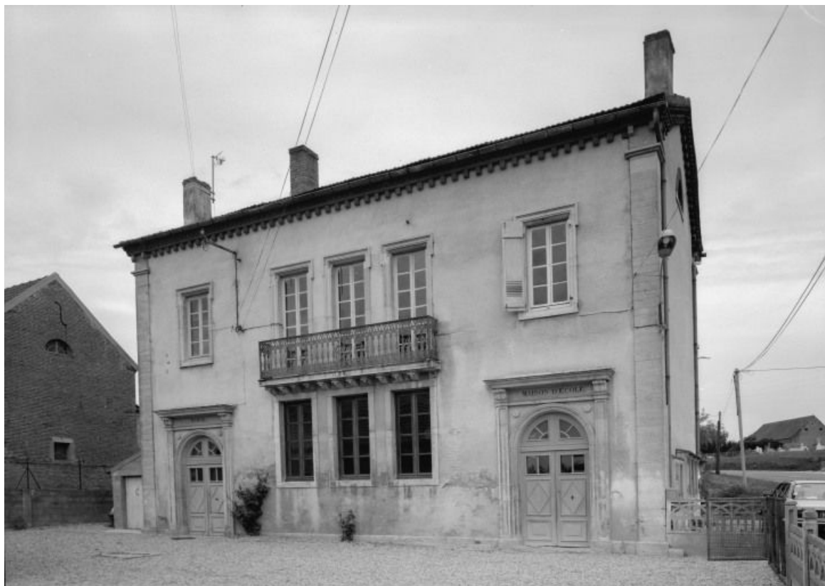
Vue d'ensemble. 21, Bagnot R.D. 20
