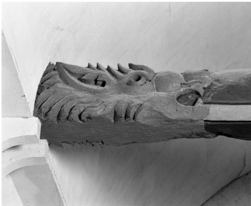
Charpente de la nef, détail du 4e entrain, avers 21, Bagnot
