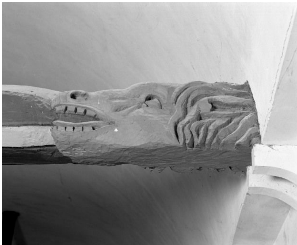
Charpente de la nef, détail du 4e entrait, revers 21, Bagnot
