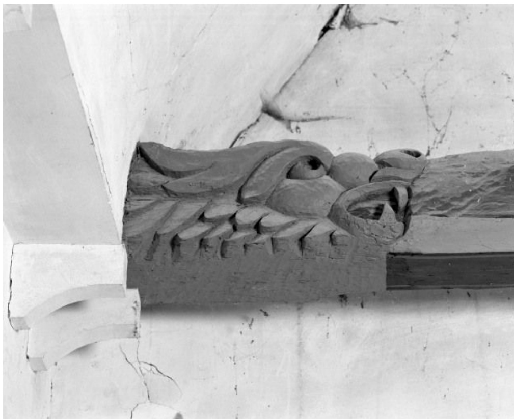
Charpente de la nef, détail du 5e entrain 21, Bagnot
