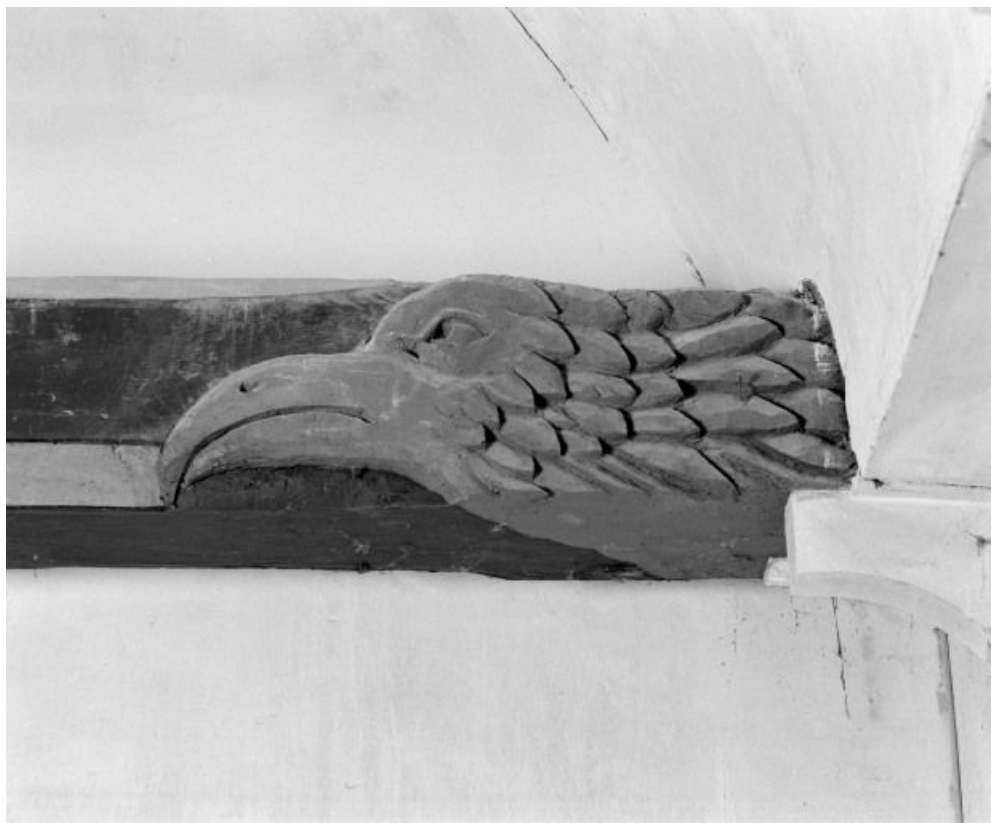
Charpente de la nef, détail du 1er entrain 21, Bagnot
