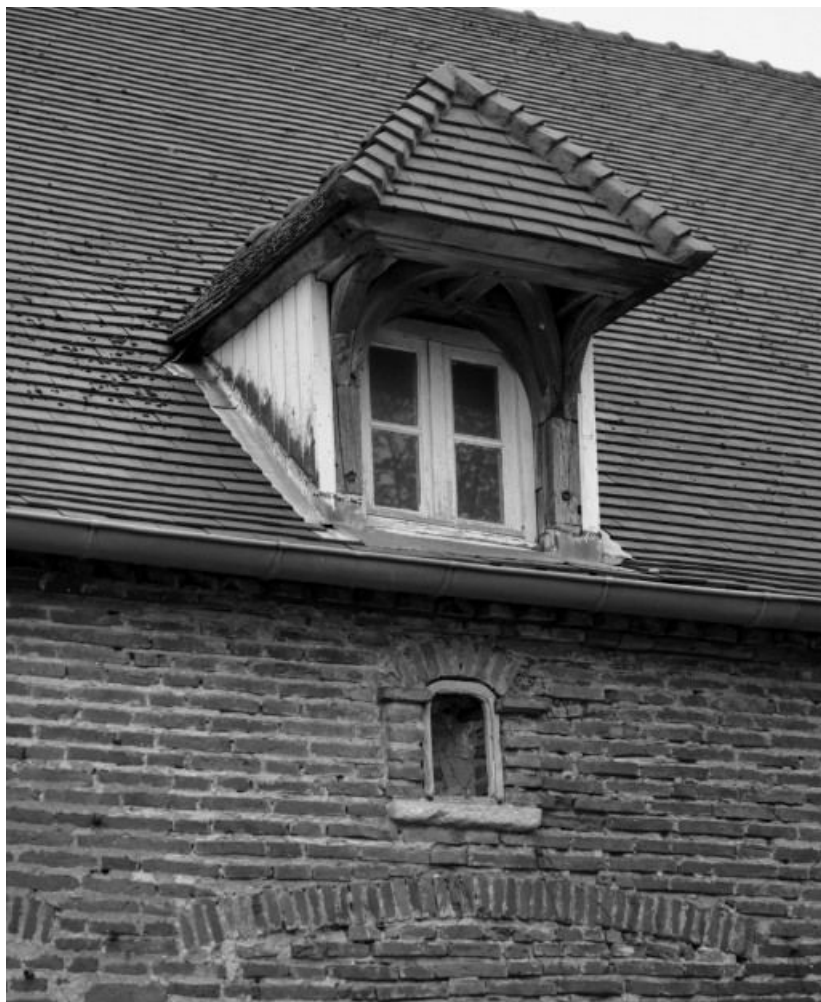
Logis, détail d'une lucarne.
