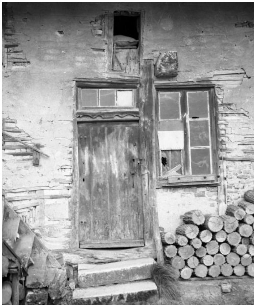
Porte du logis datée 1817 sur le linteau. 21, Auvillars-sur-Saône Creux
