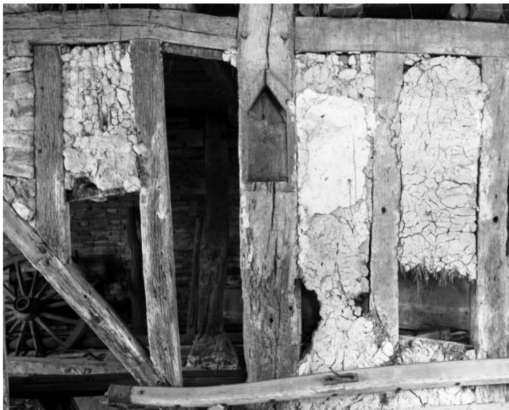
Aire de battage, mur gauche côté étable.
