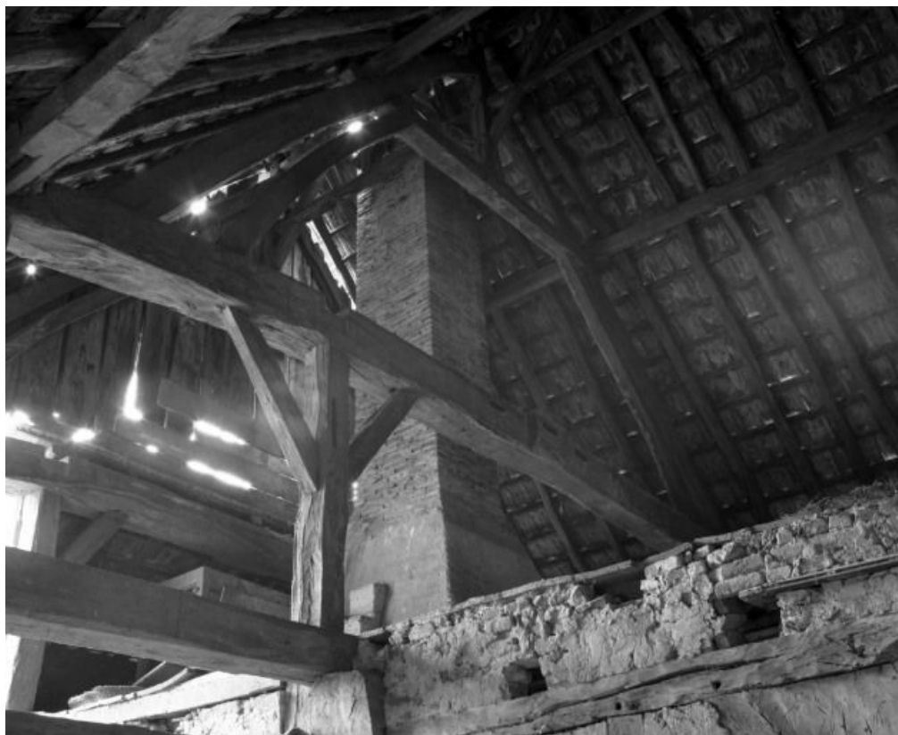
Conduit de cheminée et charpente.
