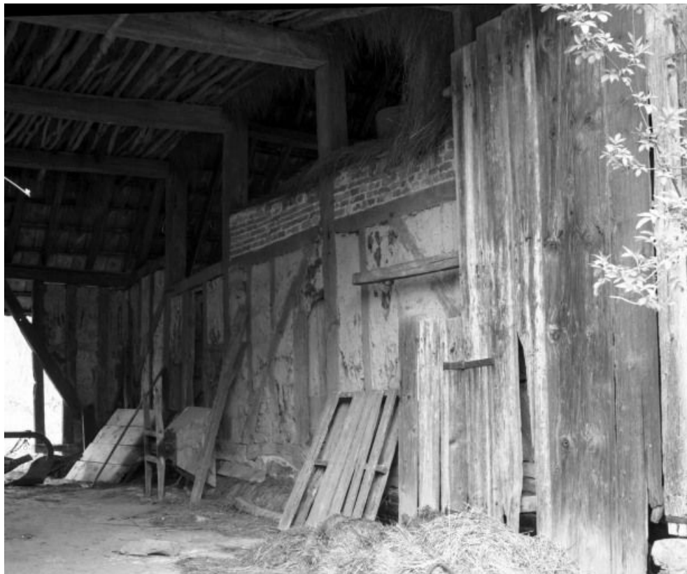
Aire de battage, mur droit.
