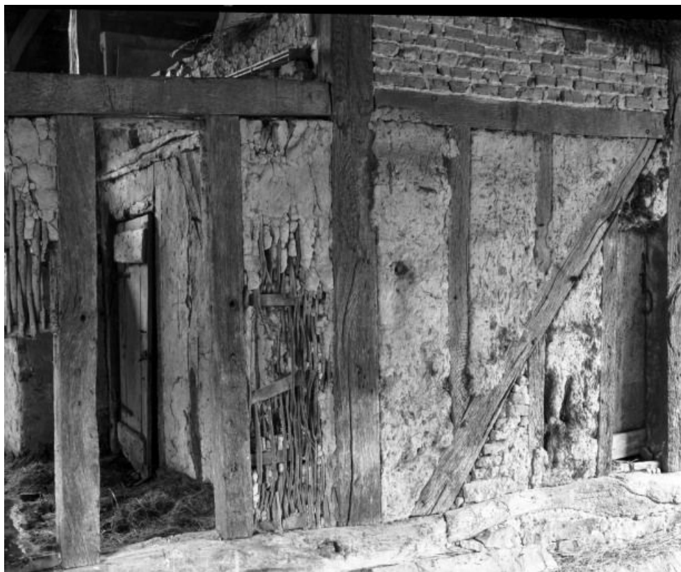
Aire de battage, détail du mur droit.
