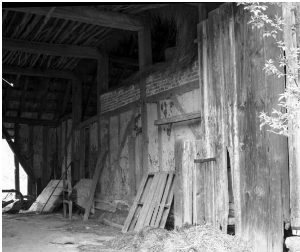
Aire de battage, mur droit.
