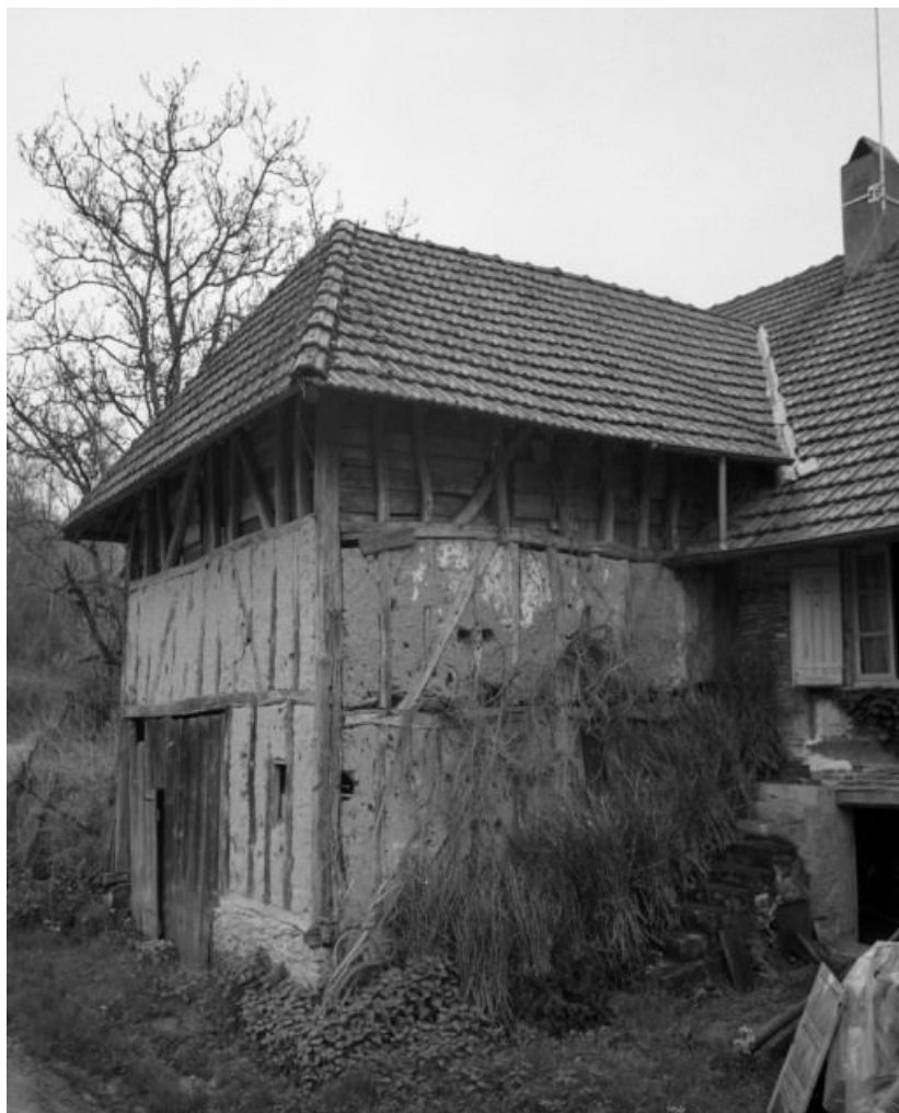
Corps perpendiculaire à la façade postérieure.
