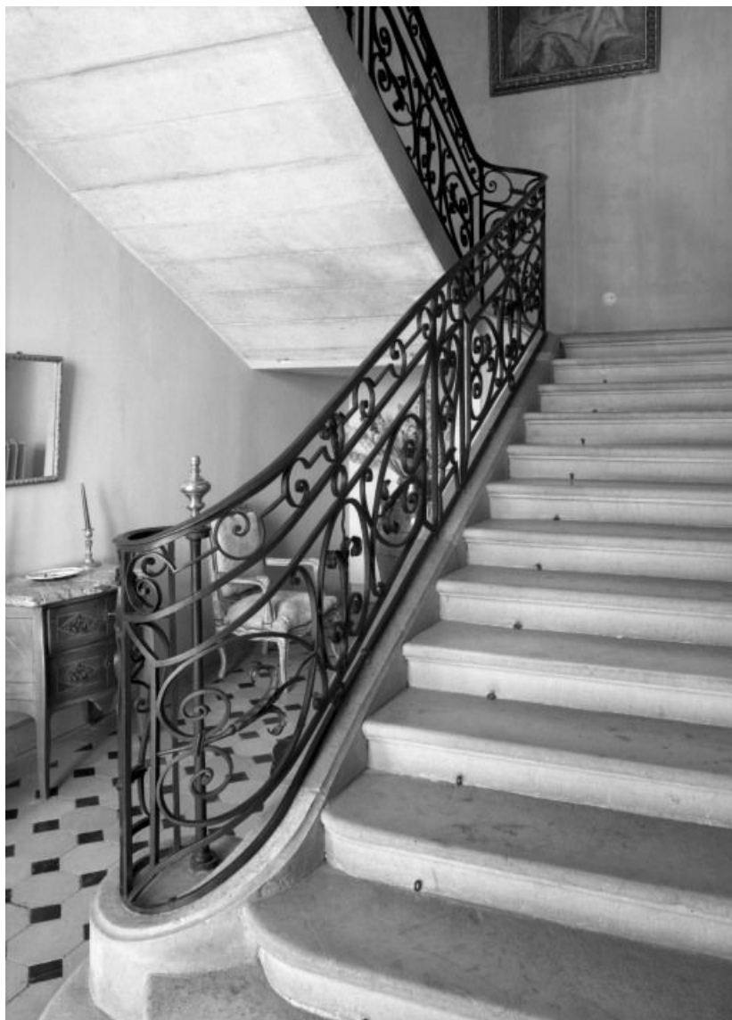
Escalier du corps principal, vue prise du rez-de-chaussée. 21, Auvillars-sur-Saône Eglise
