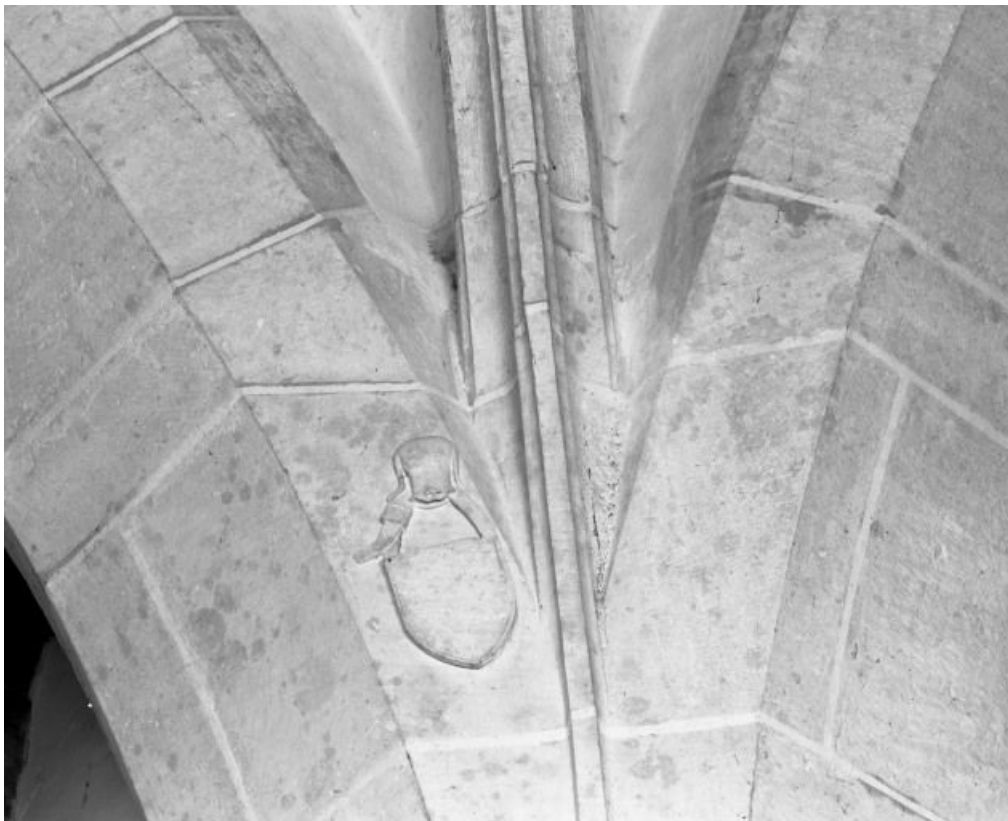
Travée sous clocher, angle postérieur gauche de la voûte 21, Auvillars-sur-Saône Eglise
