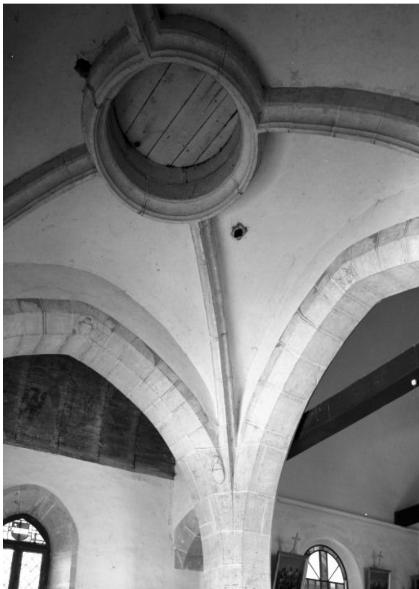
Voûte de la travée sous clocher
