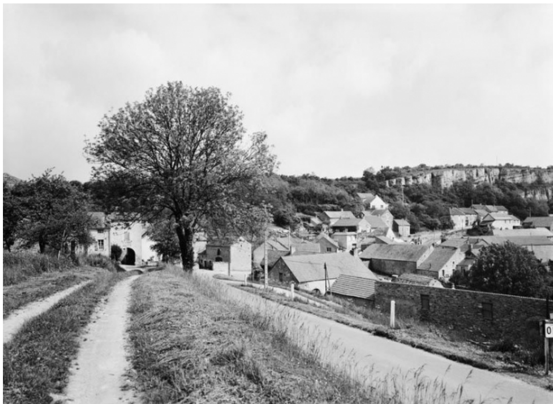
Vue d'ensemble du hameau.
