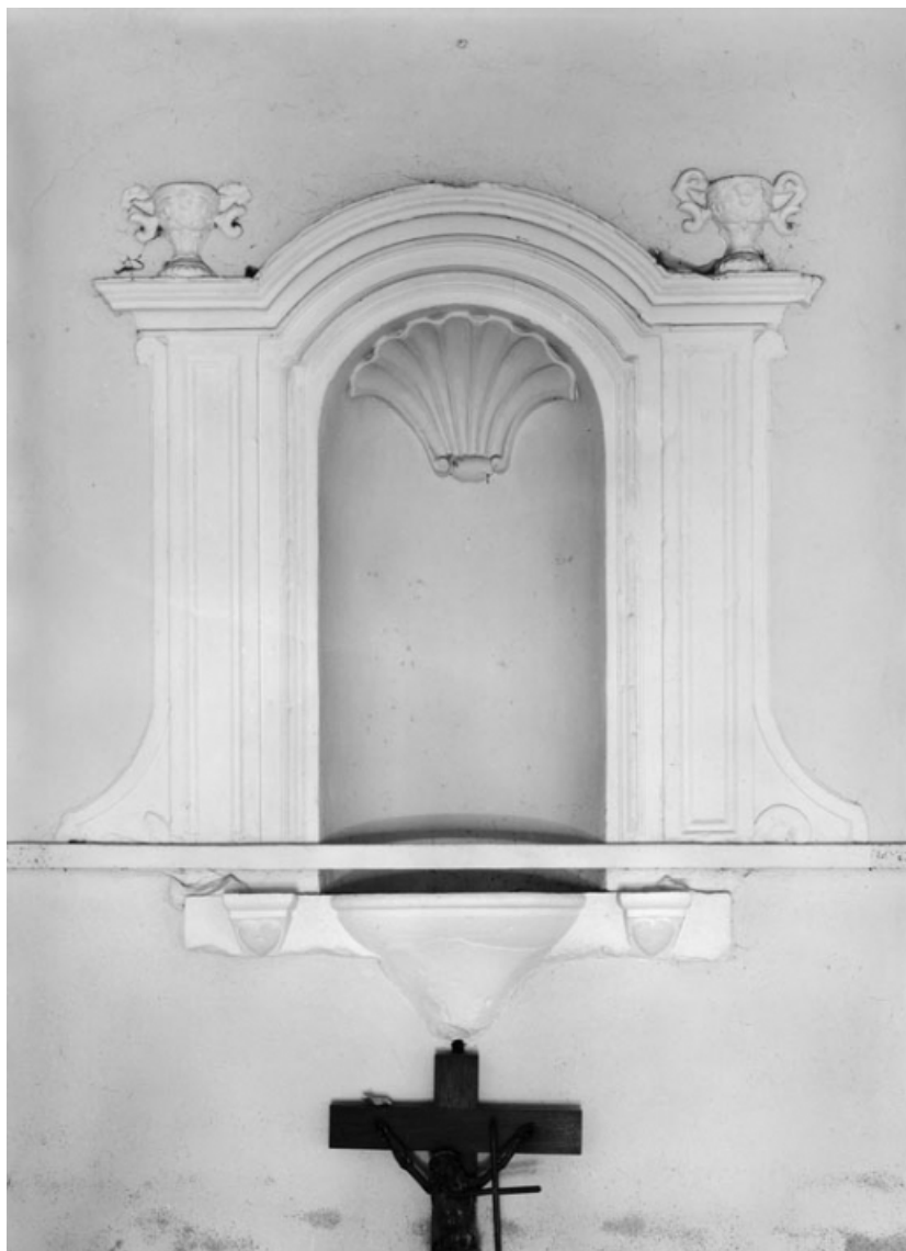
Niche du mur postérieur.
