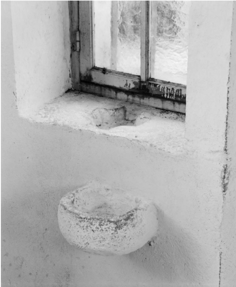
Appui de la fenêtre à gauche de la porte et bénitier.
