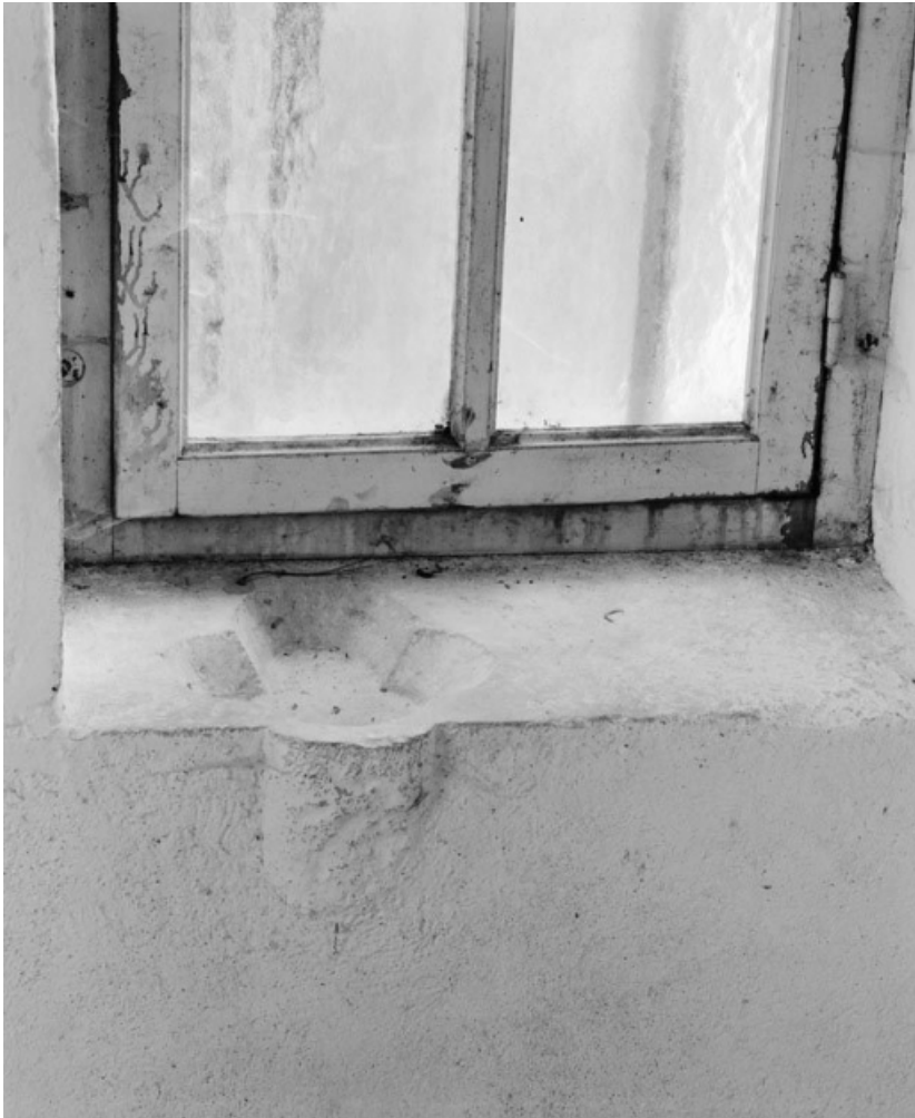
Appui de la fenêtre à droite de la porte.
