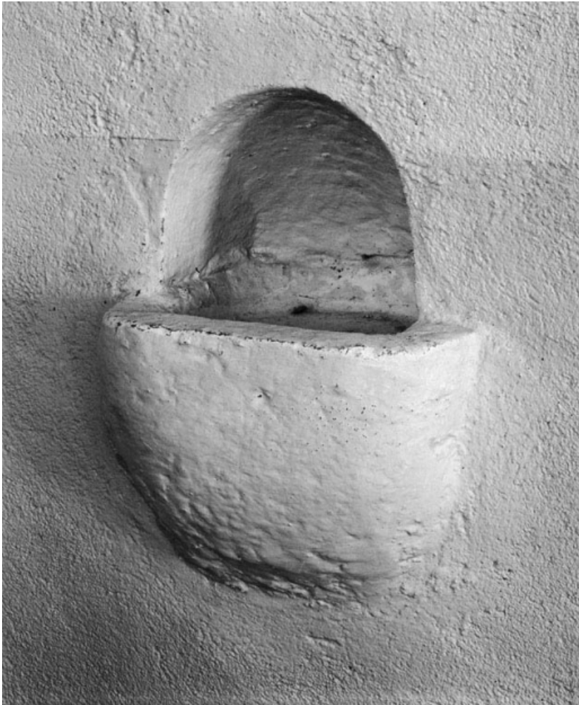
Niche du mur droit.
