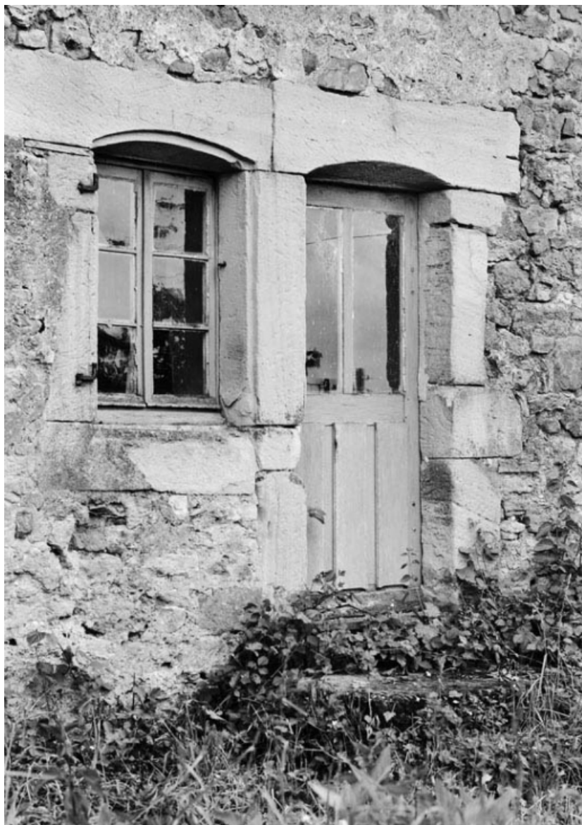
Détail de la porte et de la fenêtre du logis.
