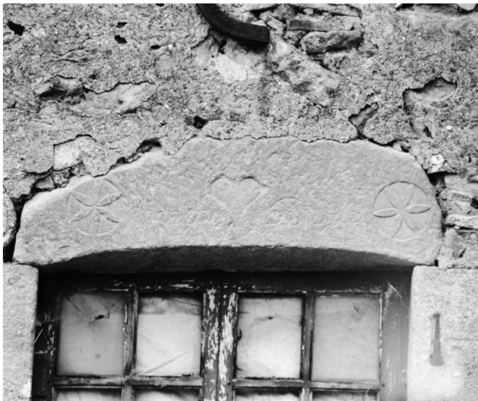
Détail du linteau de la fenêtre.
