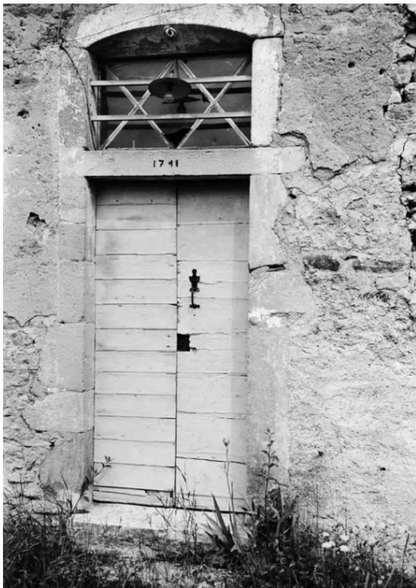
Détail de la porte.
