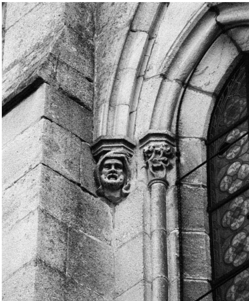
Façade antérieure : détail d'un culot.
