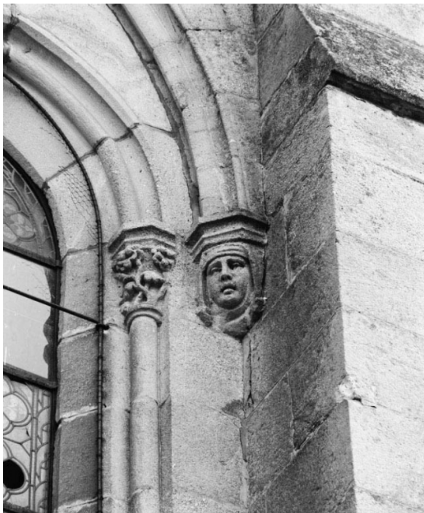
Façade antérieure : détail d'un culot.
