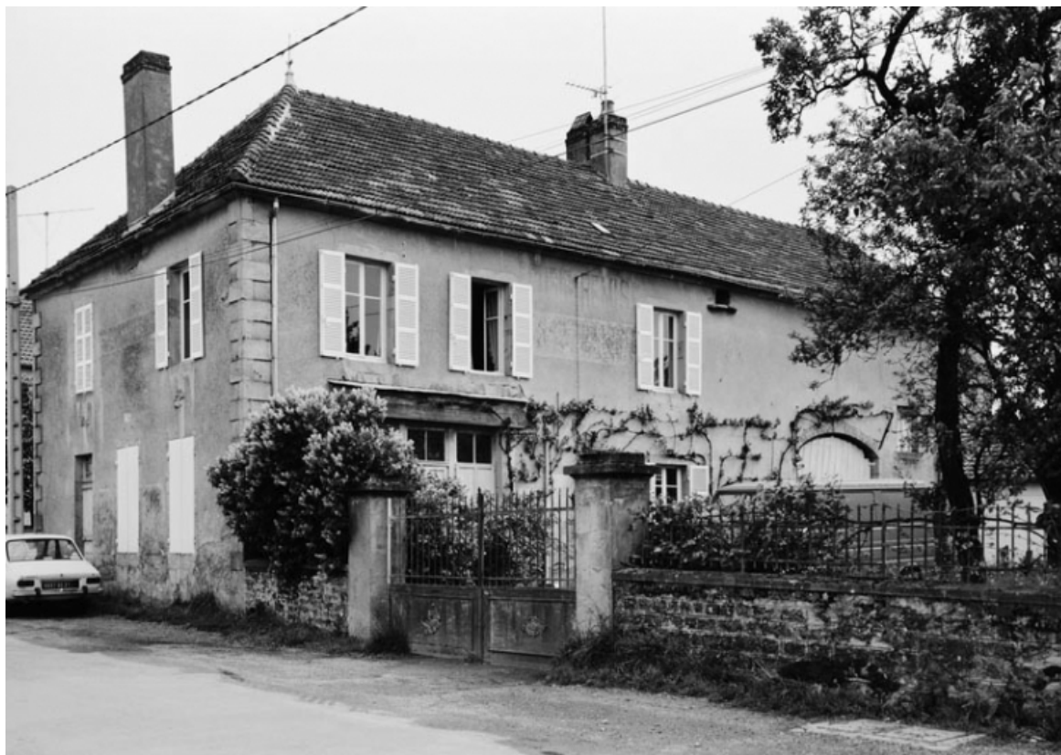
Vue d'ensemble de la maison sise parcelle 155, section B1 du cadastre de 1969. 21, Thury
