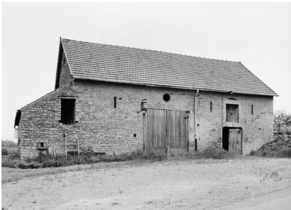
Vue d'ensemble de la ferme sise parcelle 103, section B1 du cadastre de 1969. 21, Thury
