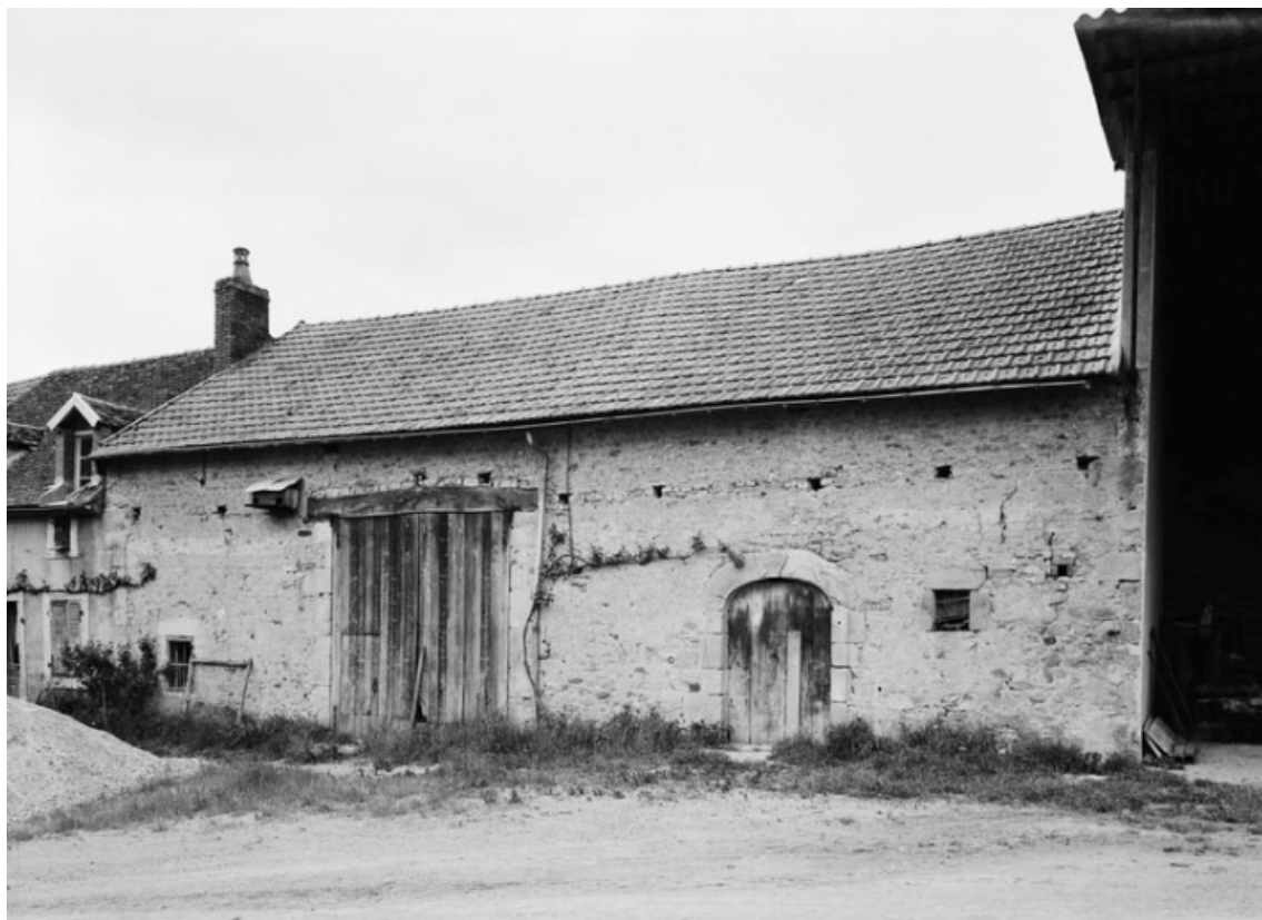
Vue d'ensemble de la ferme sise parcelle 299, section F2 du cadastre de 1969. 21, Thury
