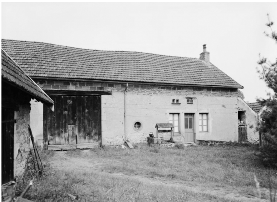
Vue d'ensemble de la ferme sise parcelle 183, section F2 du cadastre de 1969. 21, Thury
