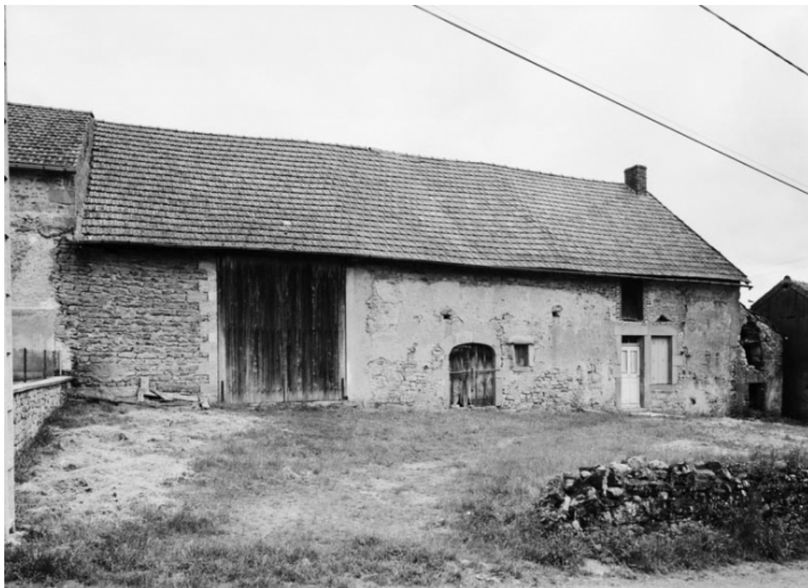
Vue d'ensemble de la ferme sise parcelle 268, section F2 du cadastre de 1969. 21, Thury
