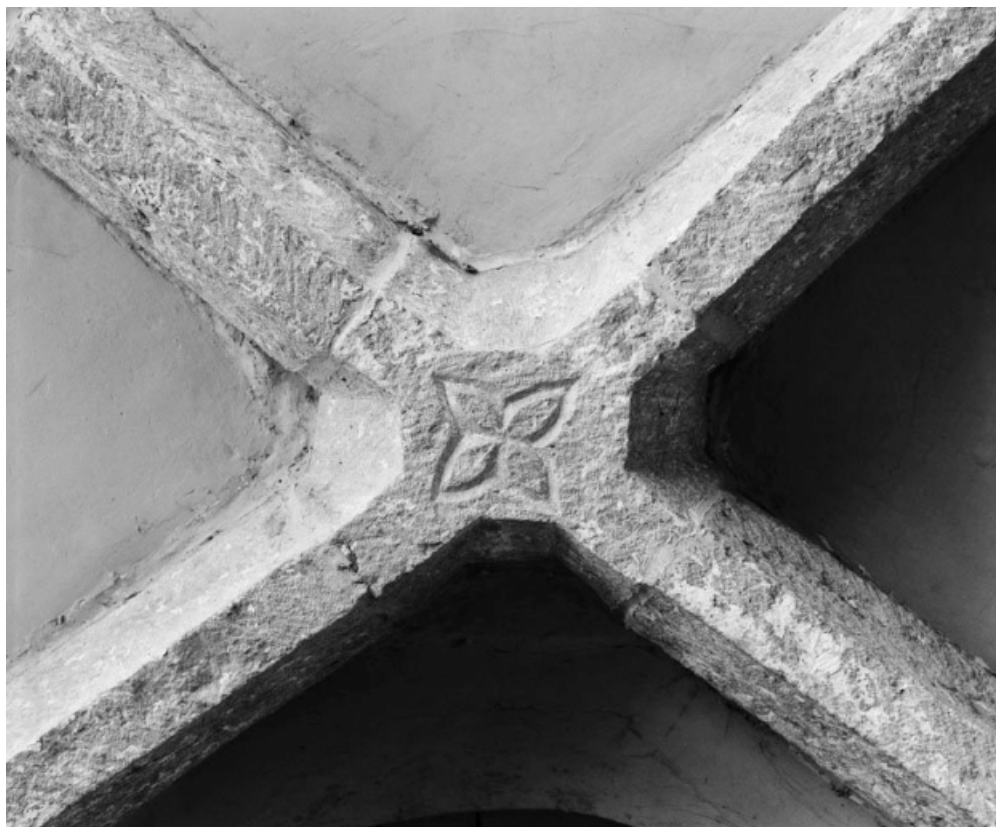
Travée sous clocher : clef de voûte. 21, Santosse
