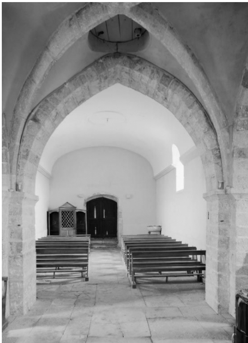
Vue d'ensemble de l'intérieur, depuis le chœur. 21, Santosse
