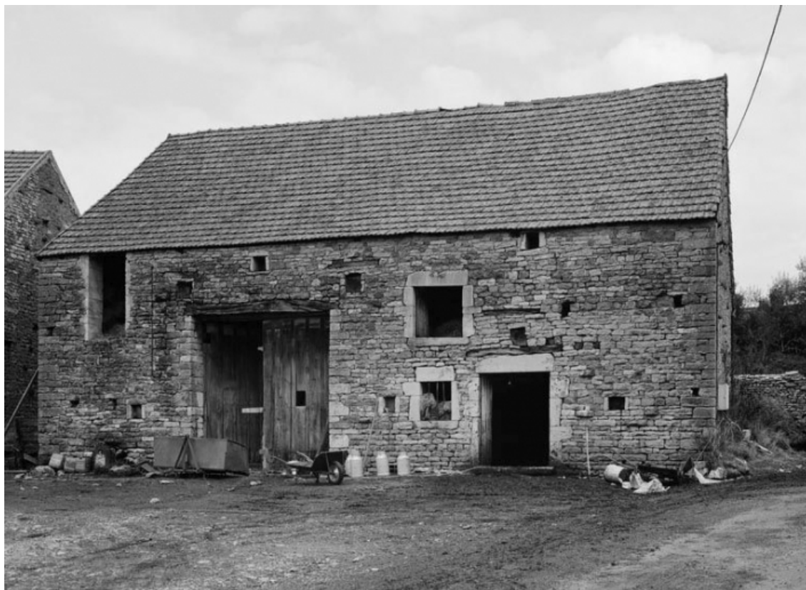
Vue d'ensemble de la ferme et ses dépendances, sise parcelle 33, section AB du cadastre de 1956. 21, Santosse
