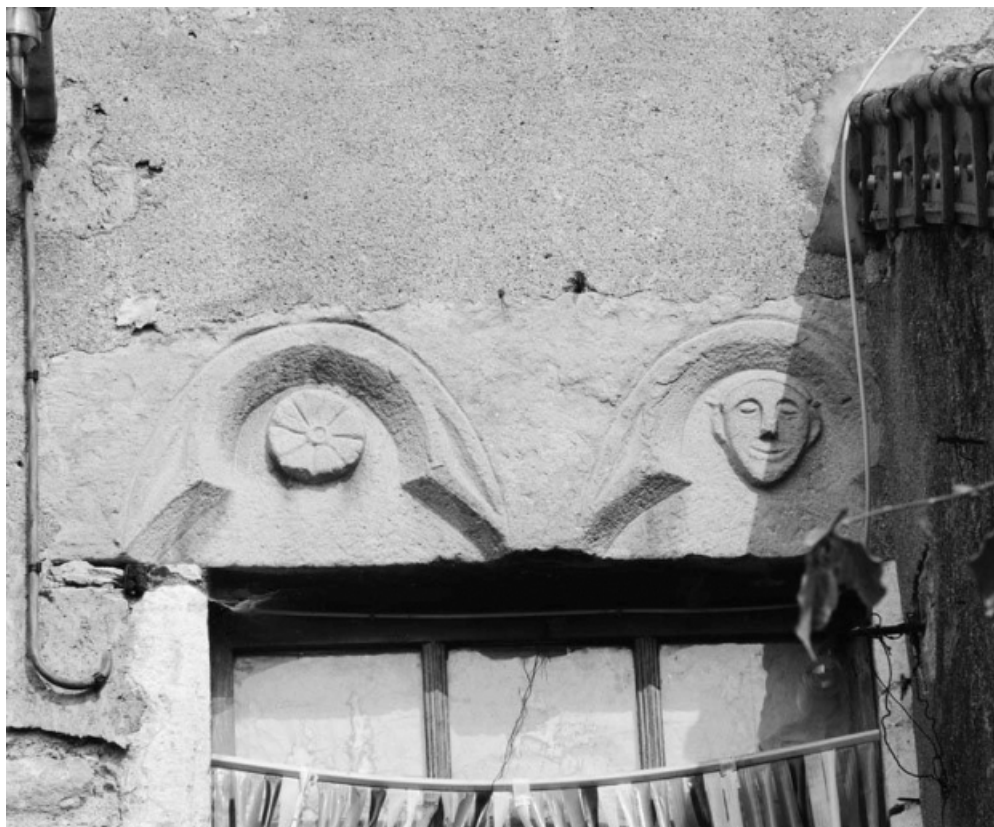
Détail du linteau sculpté en remploi.
