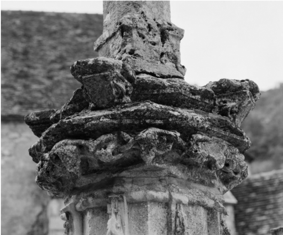
Détail de la partie supérieure du piédestal.
