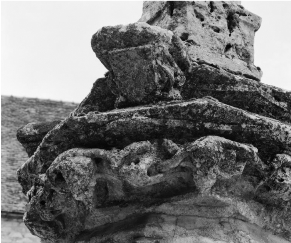
Détail de la partie supérieure du piédestal.
