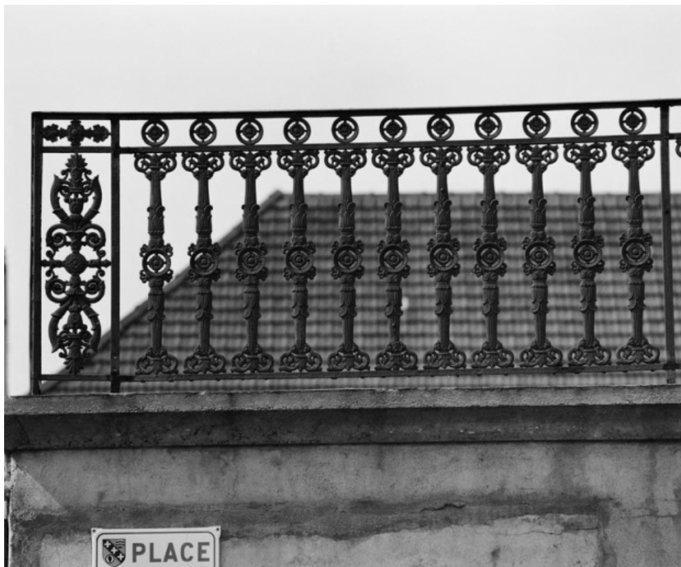
Détail du garde-corps de la terrasse.
