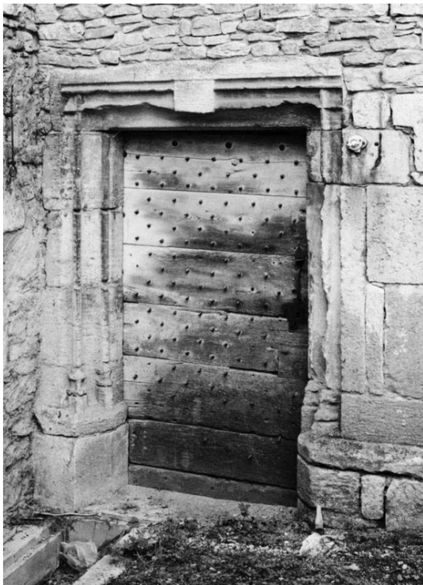
Porte de la tour d'escalier.
