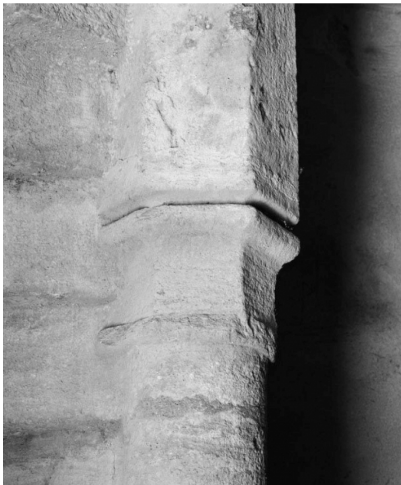
Base du noyau de l'escalier en vis.
