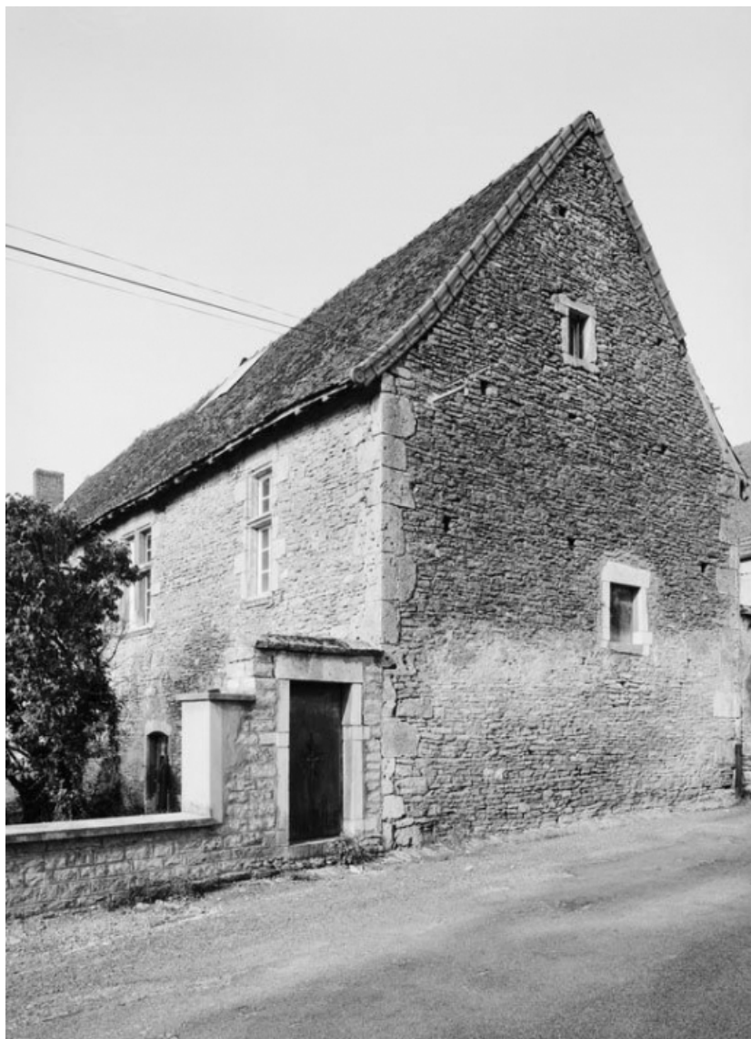
Vue du mur-pignon et de l'élévation postérieure du corps gauche. 21, Santenay Forge
