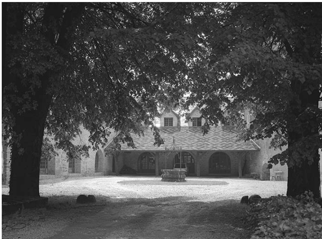
Bâtiment sud : élévation sur cour.
