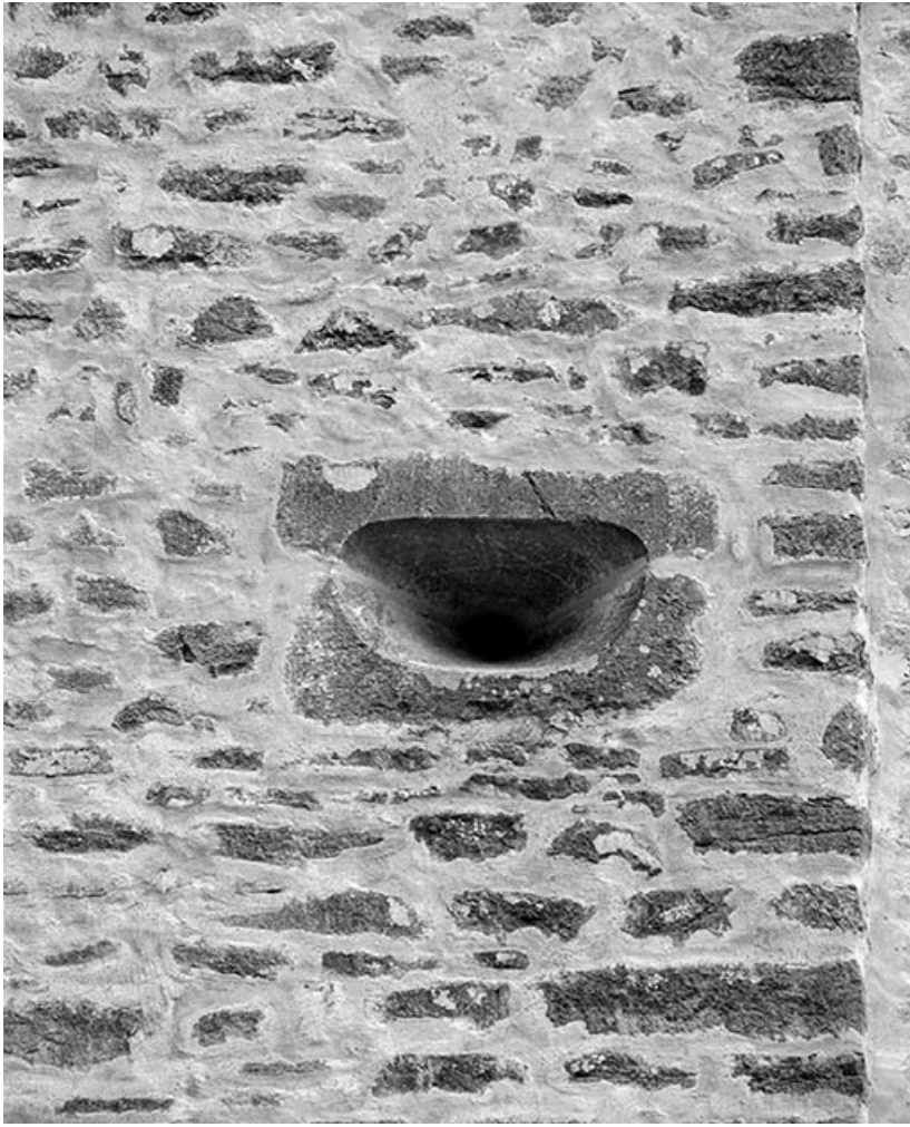
Tourelle en surplomb : détail d'une canonnère.
