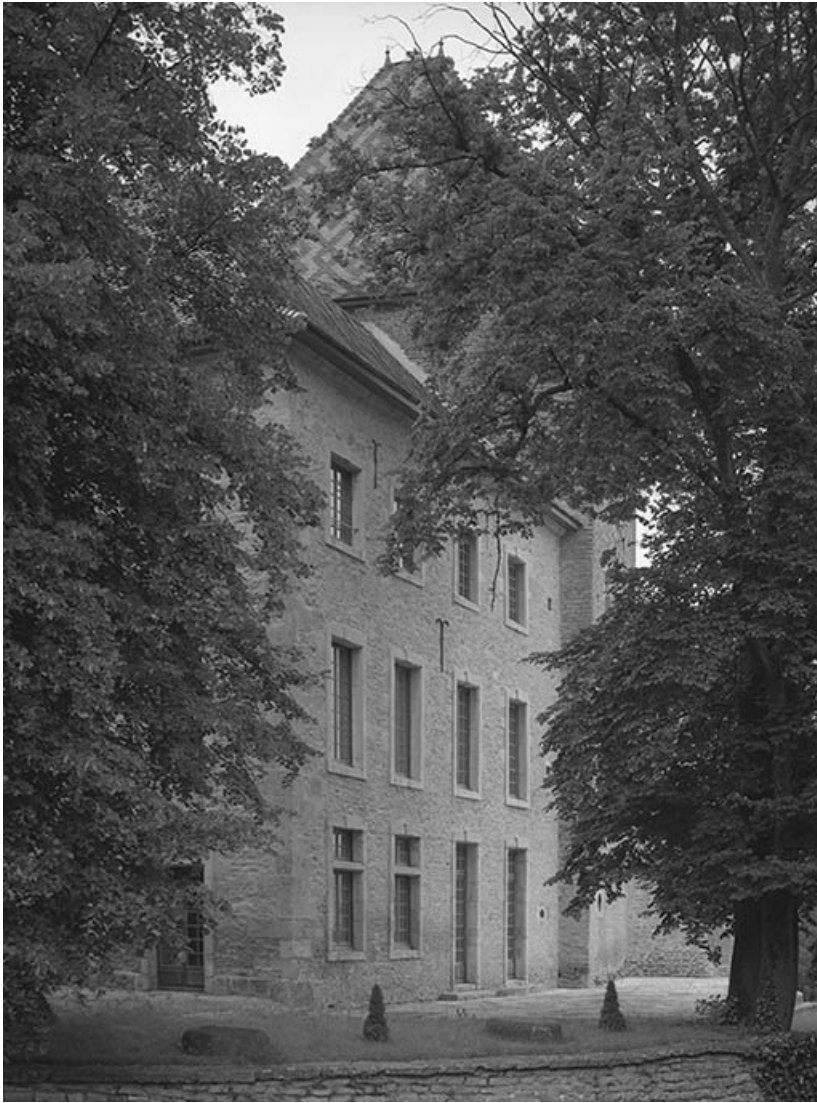
Aile droite : élévation sur fossé.
