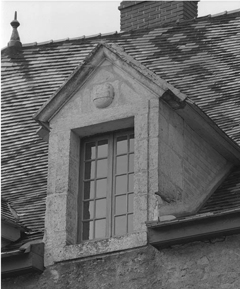
Bâtiment sud : lucarne du corps à gauche du donjon. 21, Santenay au nord-ouest du village
