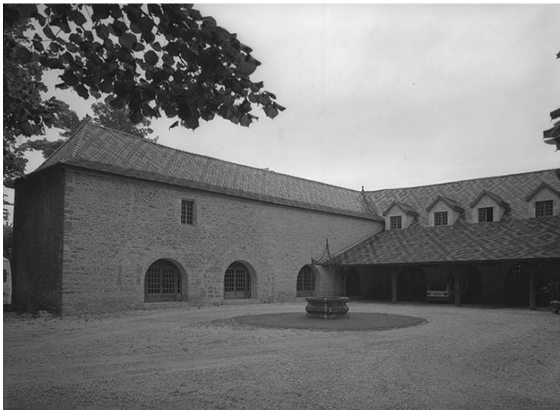
Aile gauche : élévation sur cour.
