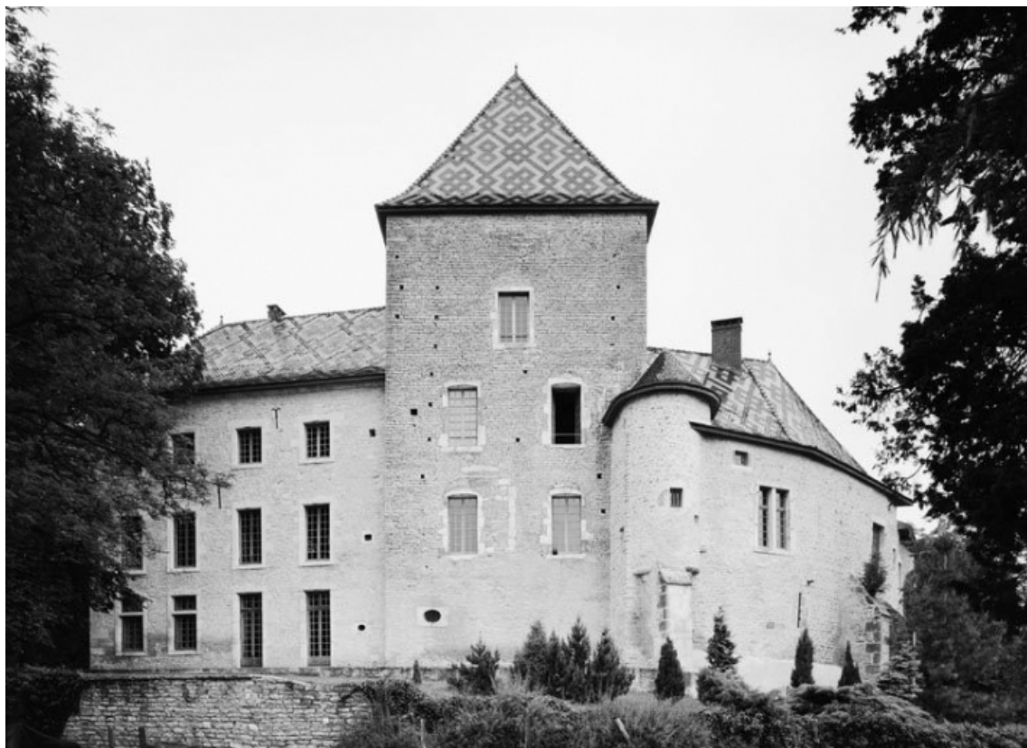
Aile droite, donjon et bâtiment sud : élévations sur fossés.
