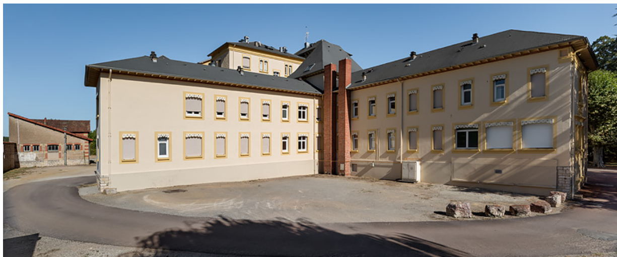
Bâtiment des bains, élévation postérieure, vue depuis l'ouest.
