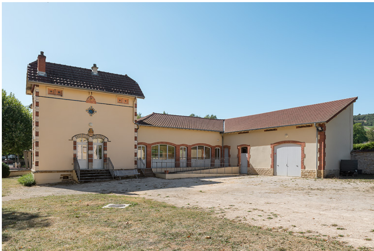
Bâtiment du forage (à gauche) avec hangar et usine d'embouteillage (à droite). 21, Santenay, 30 avenue des Sources
