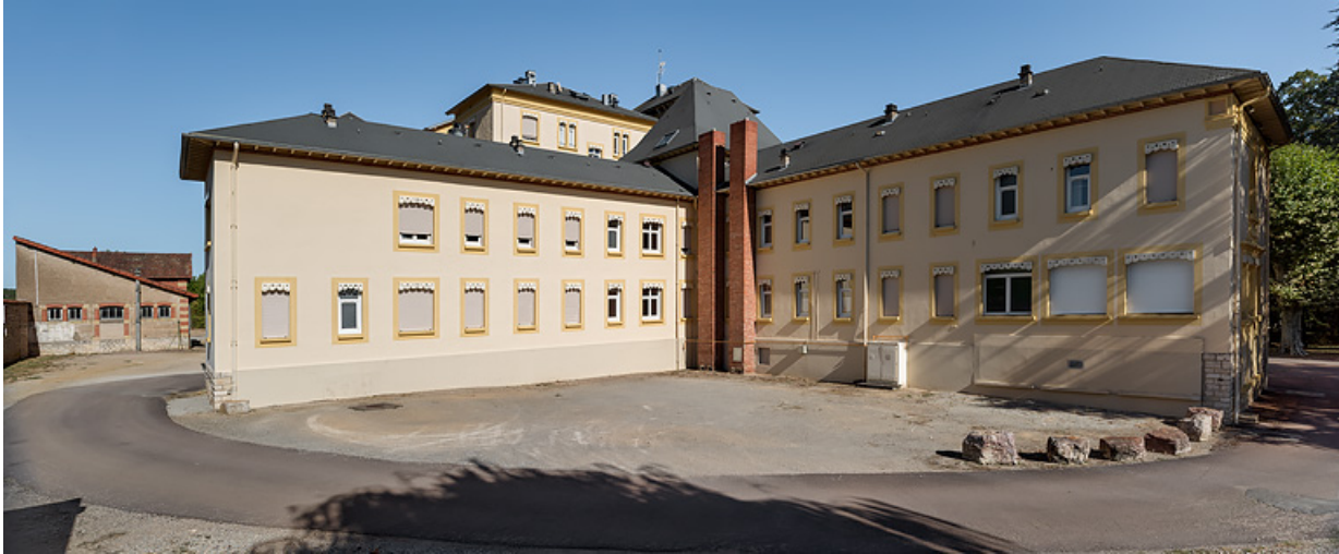
Bâtiment des bains, élévation postérieure, vue depuis l'ouest.
