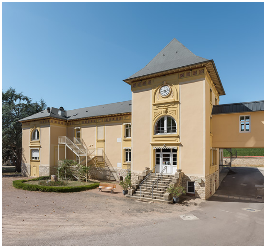
Bâtiment des bains, façade principale vue depuis le sud-est, et passerelle vers l'hôtel (à droite). 21, Santenay, 30 avenue des Sources
