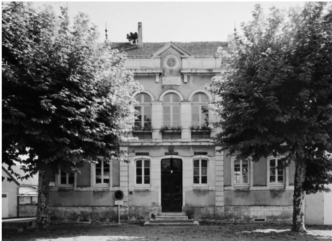
Vue d'ensemble. 21, Santenay Mairie
