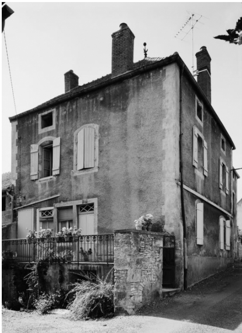
Vue d'ensemble de la maison sise parcelle 204, section D1 sur le cadastre de 1967. 21, Santenay
