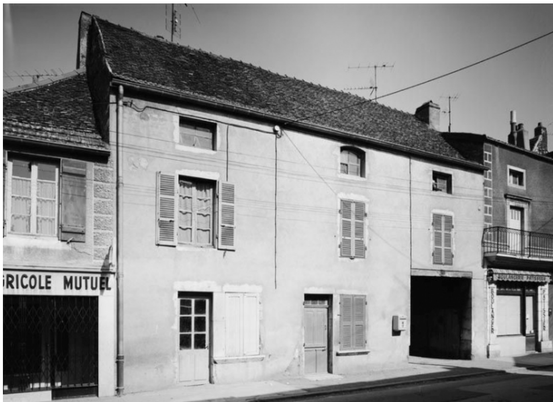
Vue d'ensemble de la maison sise parcelle 242, section D1 sur le cadastre de 1967. 21, Santenay
