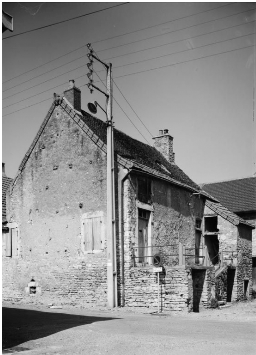
Vue générale de la maison sise parcelle 63, section D1 sur le cadastre de 1967. 21, Santenay
