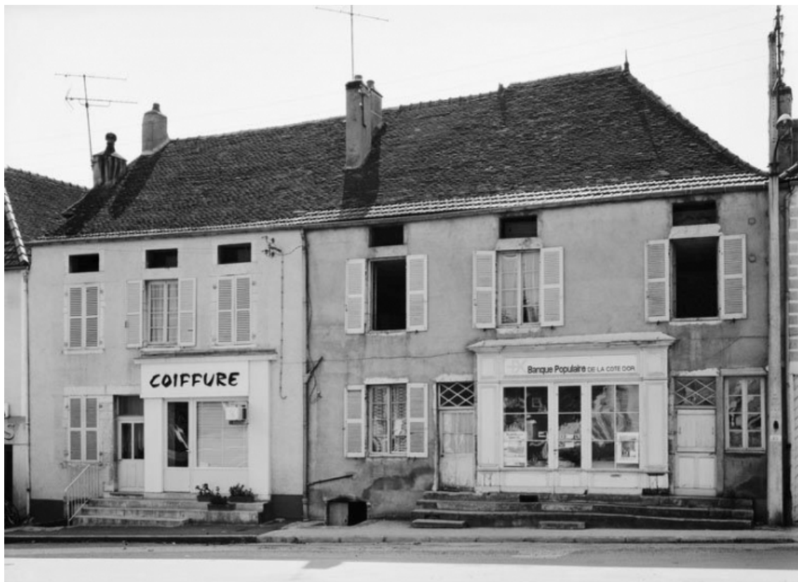
Vue d'ensemble de la maison sise parcelles 237-238, section D1 sur le cadastre de 1967. 21, Santenay
