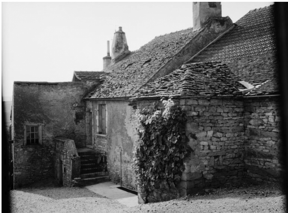
Vue générale de la maison sise parcelle 1094, section C6 sur le cadastre de 1967. 21, Santenay
