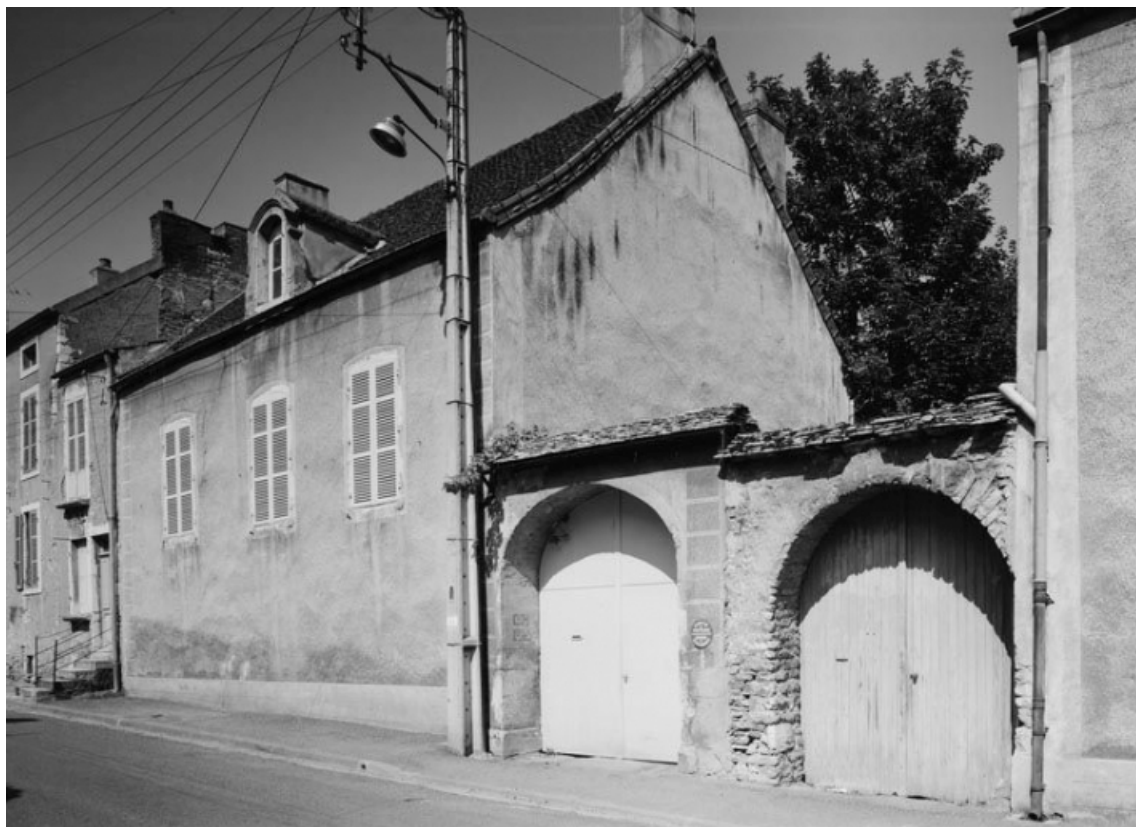
Vue générale de la maison sise parcelle 84bis, section D1 sur le cadastre de 1967. 21, Santenay
