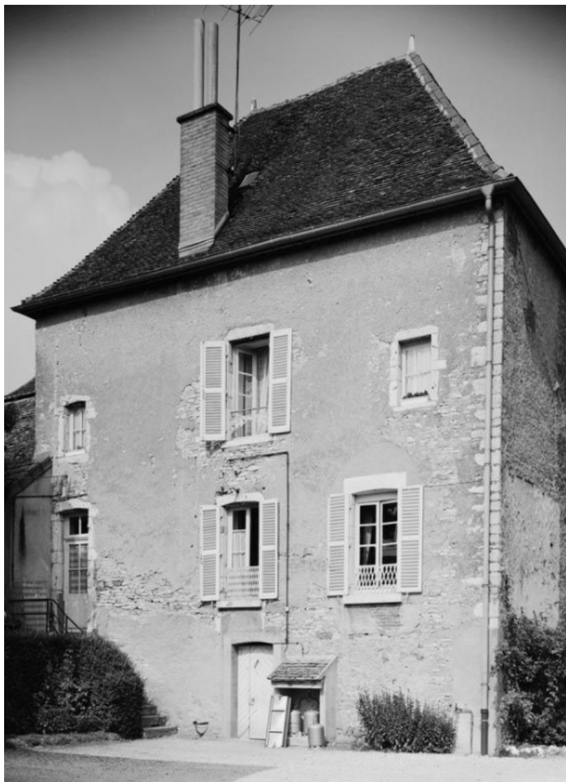
Élévation postérieure de la maison sise parcelle 123, section D1 sur le cadastre de 1967. 21, Santenay
