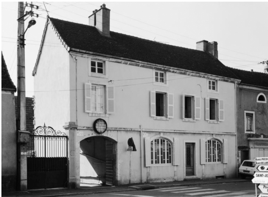
Vue d'ensemble de la maison sise parcelle 485, section B4 sur le cadastre de 1967. 21, Santenay
