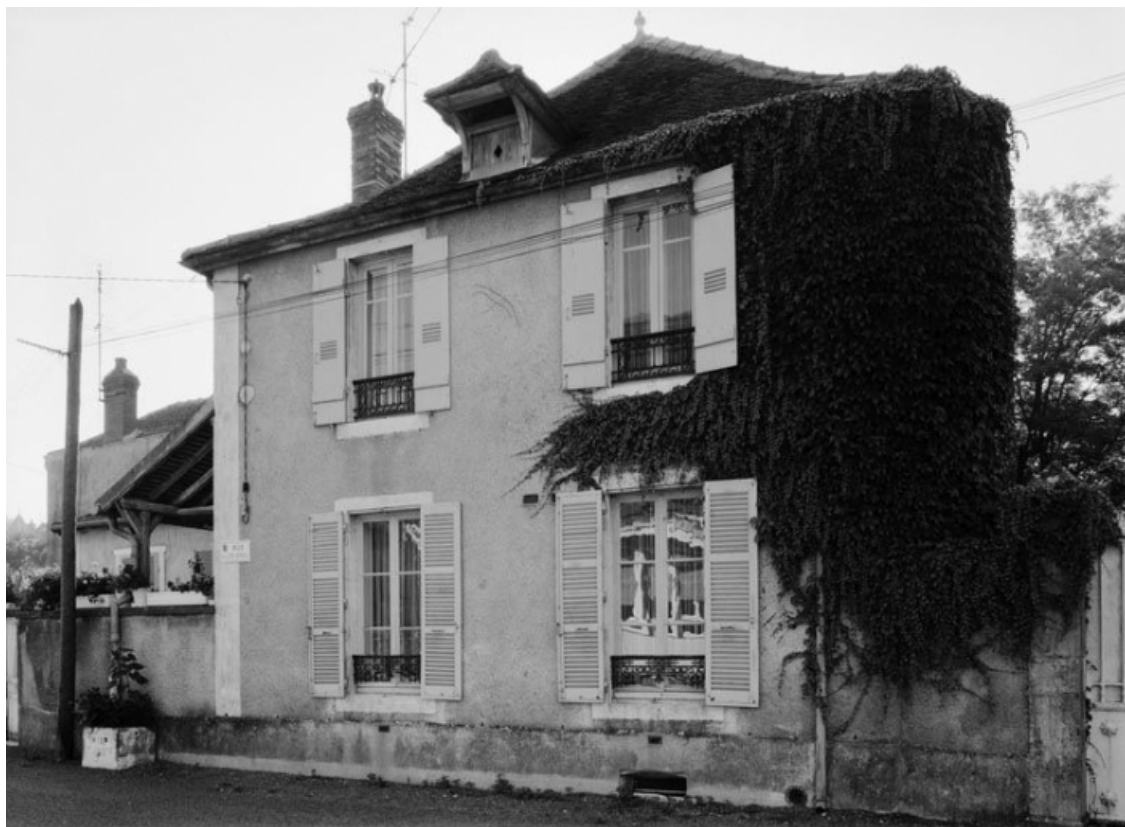
Vue d'ensemble de la maison sise parcelle 216, section D1 sur le cadastre de 1967. 21, Santenay
