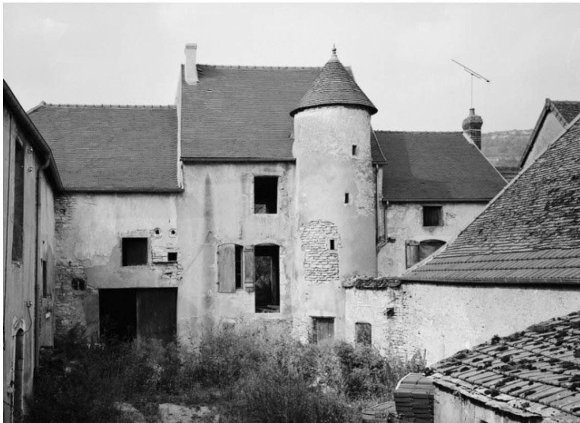
Vue d'ensemble de la maison sise parcelle 1171, section C6 sur le cadastre de 1967. 21, Santenay
