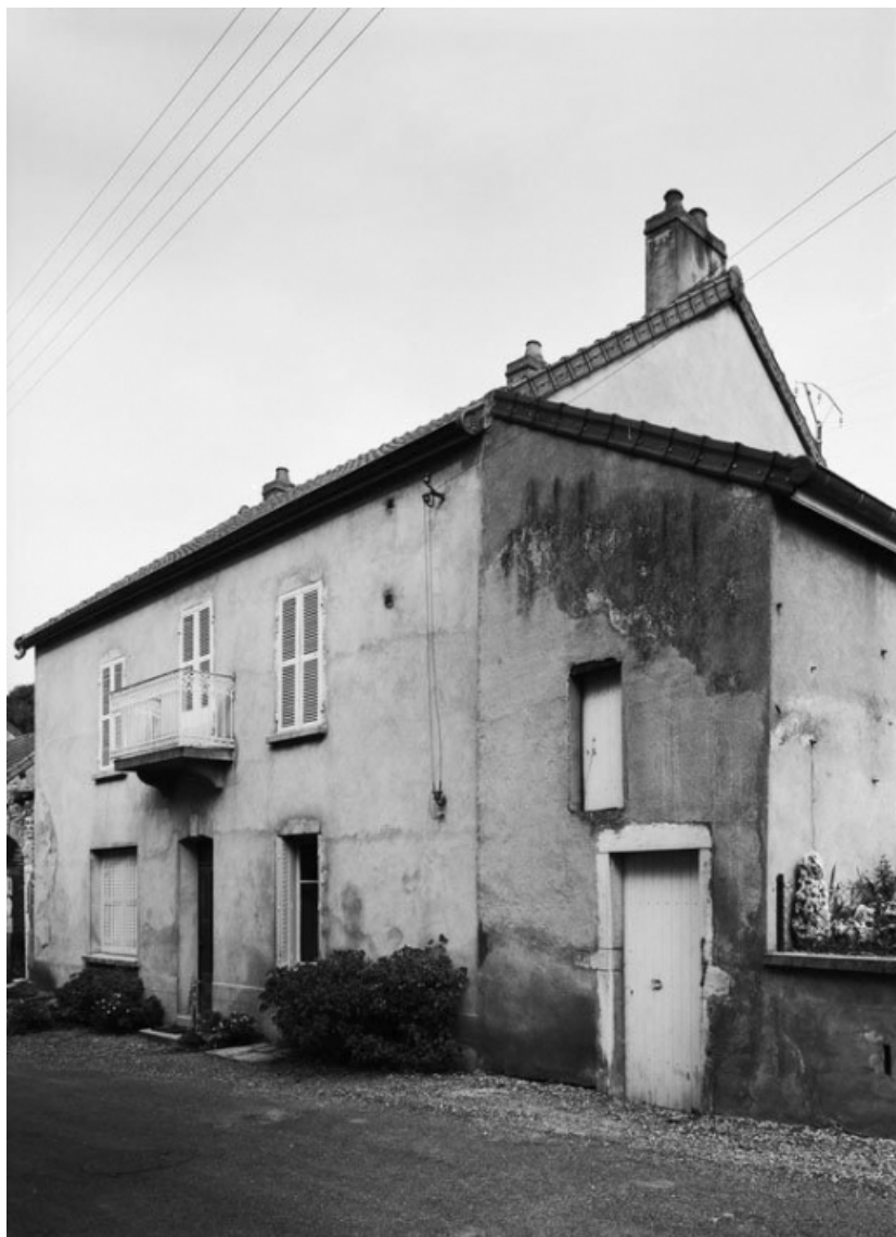
Vue générale de la maison sise parcelle 600, section A5 sur le cadastre de 1967. 21, Santenay
