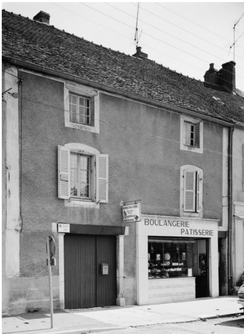
Vue générale de la maison sise parcelle 99, section D1 sur le cadastre de 1967. 21, Santenay
