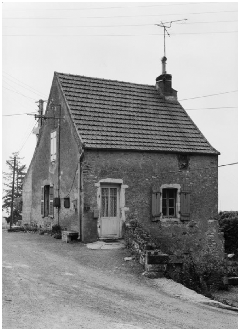
Vue générale de la maison sise parcelle 225, section C2 sur le cadastre de 1967. 21, Santenay
