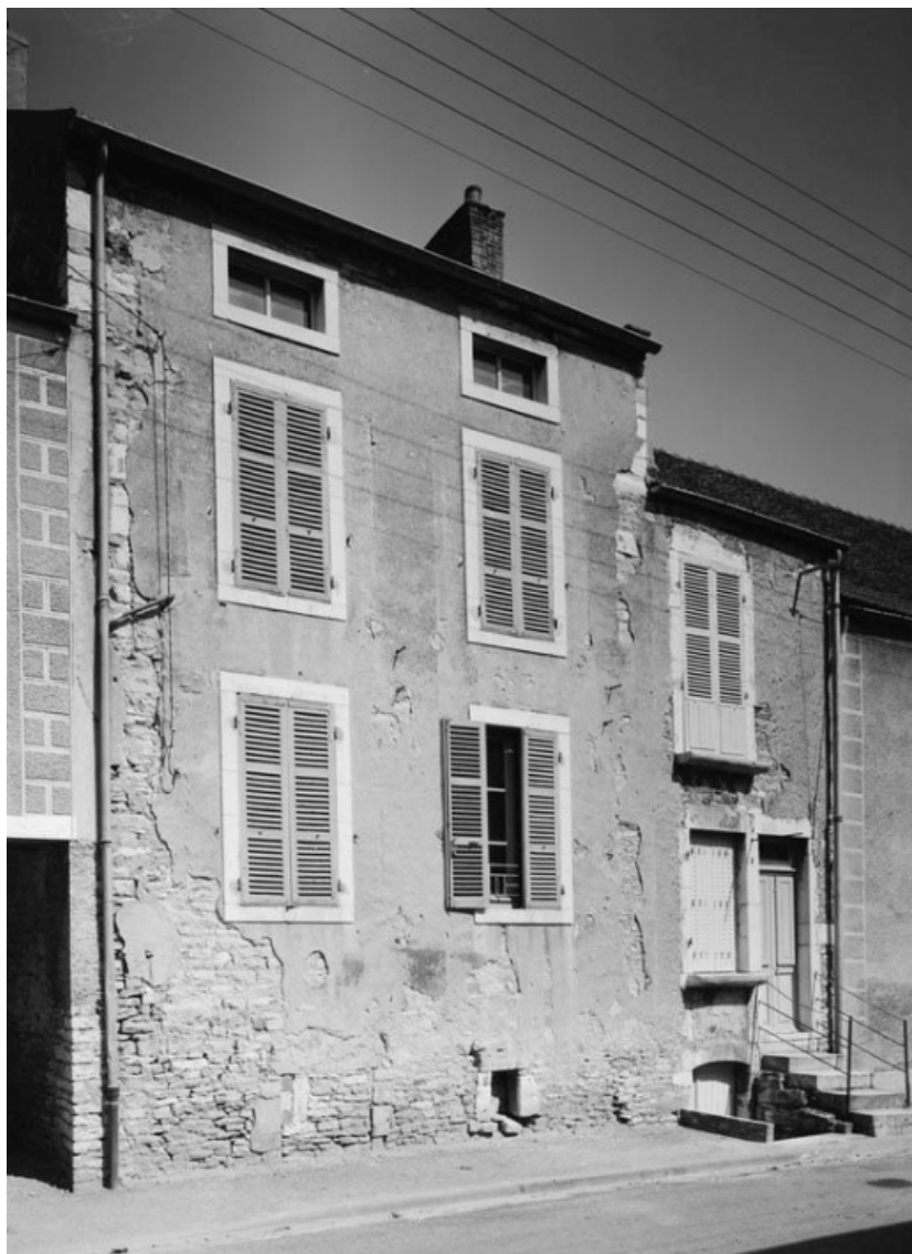
Vue générale de la maison sise parcelles 83-84, section D1 sur le cadastre de 1967. 21, Santenay
