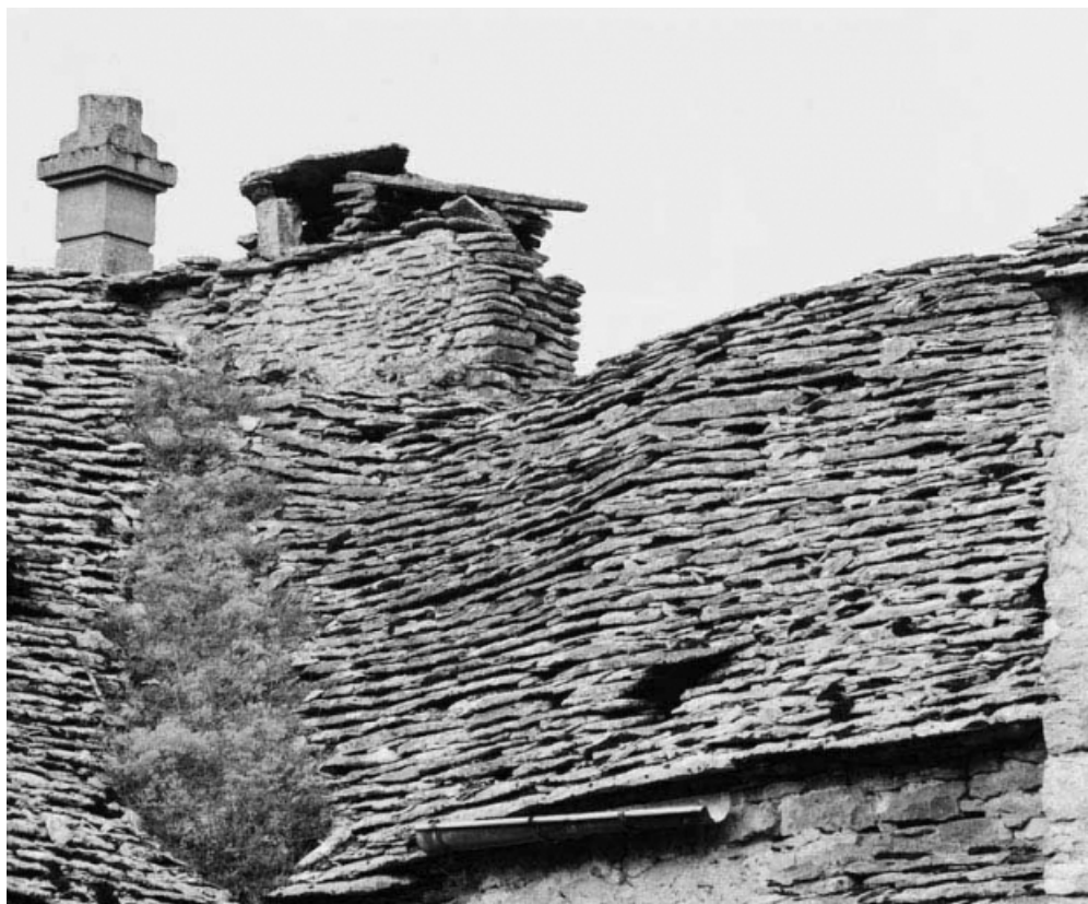
Détail de la couverture de la maison sise parcelles 1178-1180, section C6 sur le cadastre de 1967. 21, Santenay
