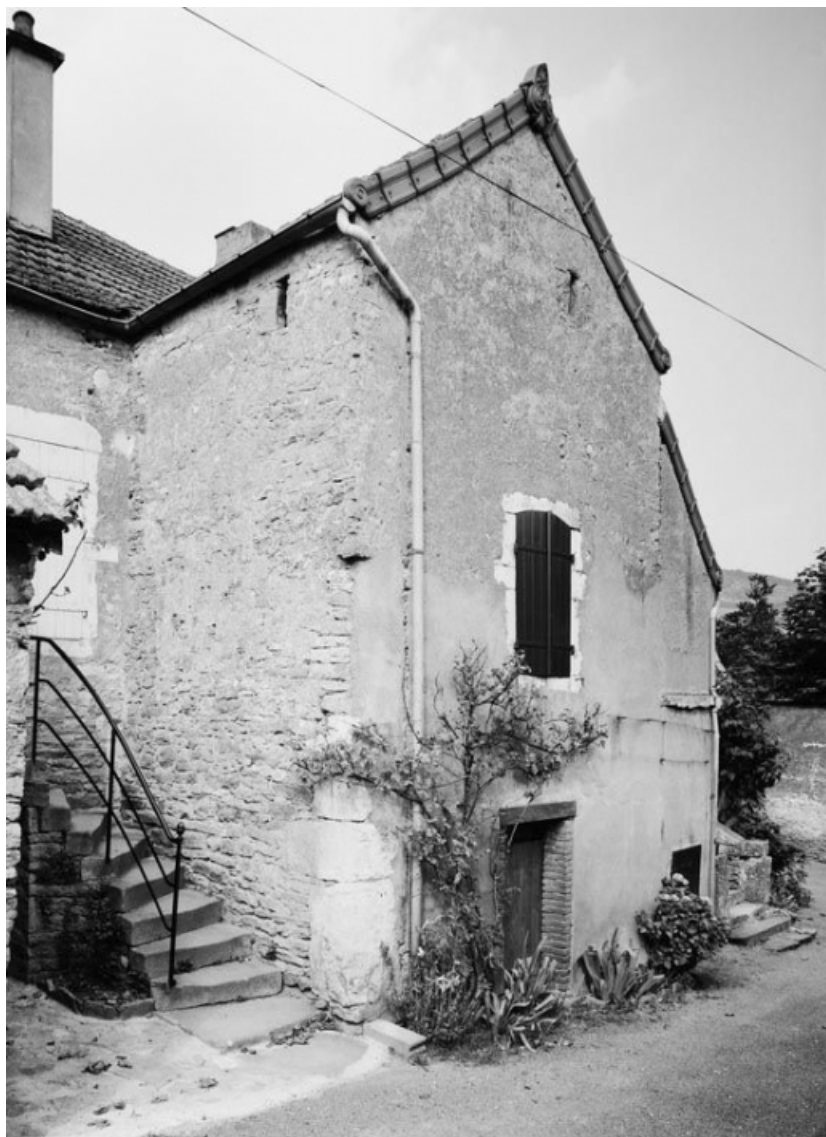
Vue d'ensemble de la maison sise parcelle 1168, section C6 sur le cadastre de 1967. 21, Santenay
