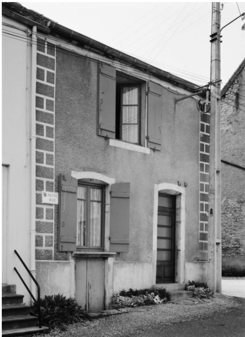
Vue d'ensemble de la maison sise parcelle 192, section D1 sur le cadastre de 1967. 21, Santenay
