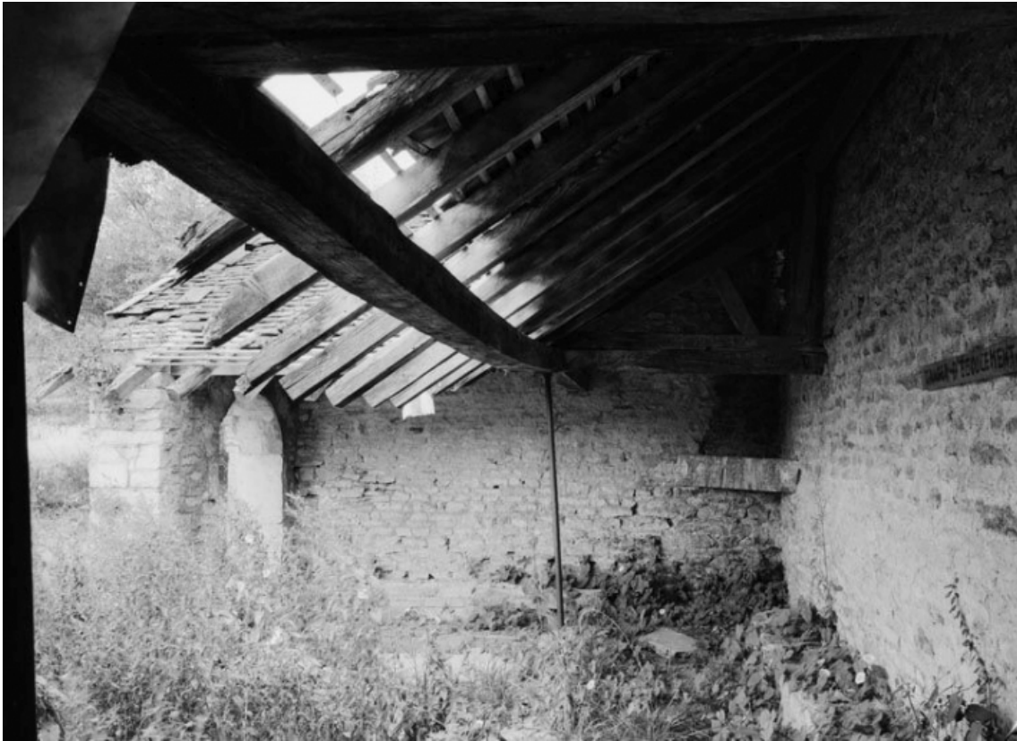
Vue de l'intérieur du lavoir.
