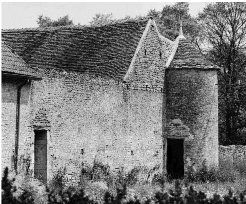
Remise : mur-pignon et tourelle droite.
