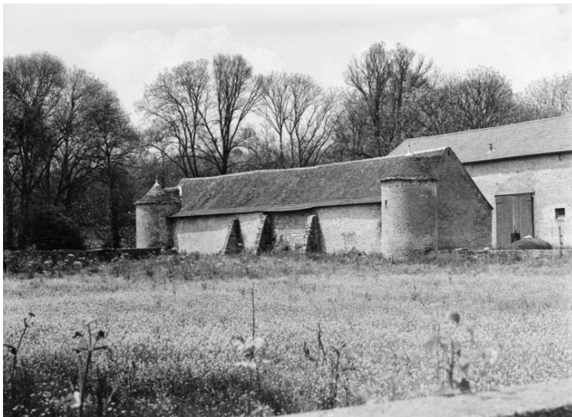
Remise : élévation postérieure.
