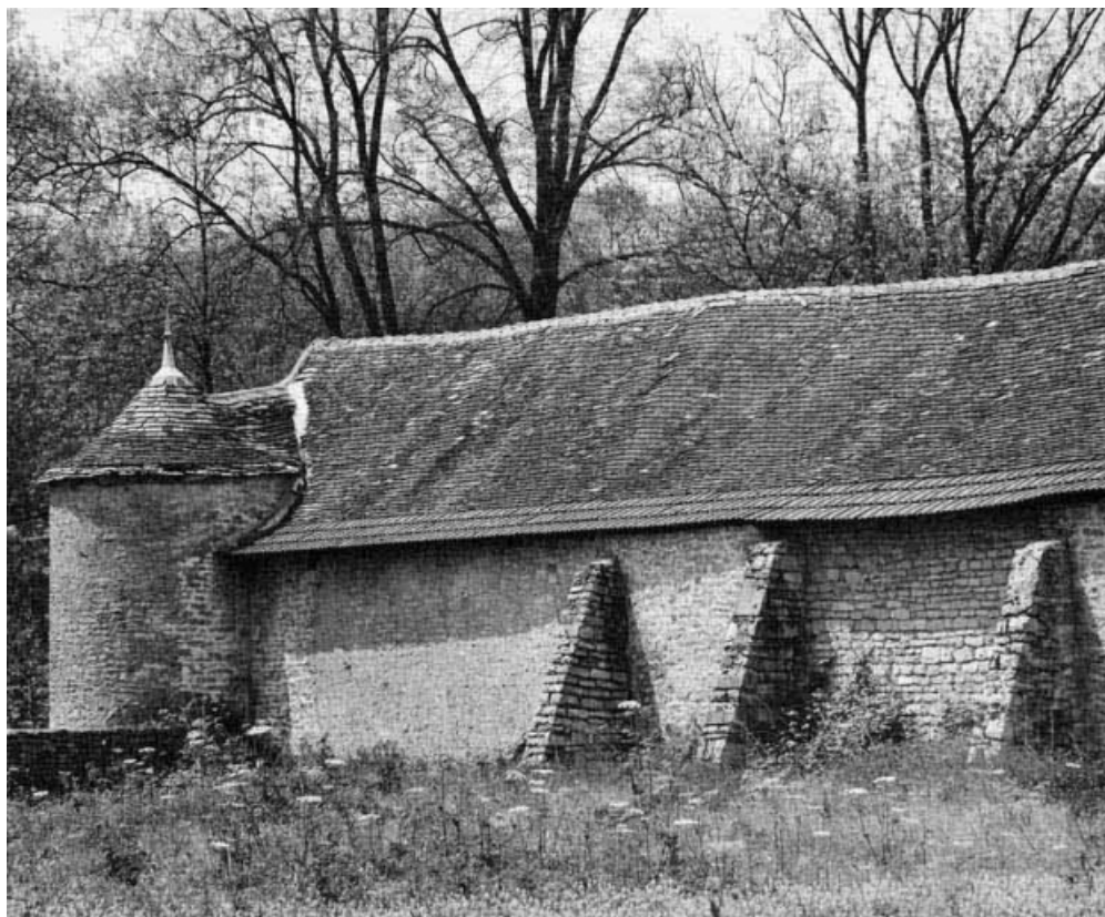
Remise : contreforts du mur postérieur et tourelle droite.
