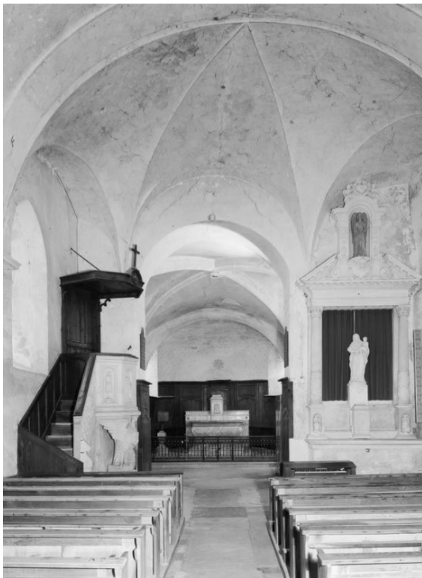
Vue du chœur et de la dernière travée de la nef. 21, Saint-Romain saint Romain le haut
