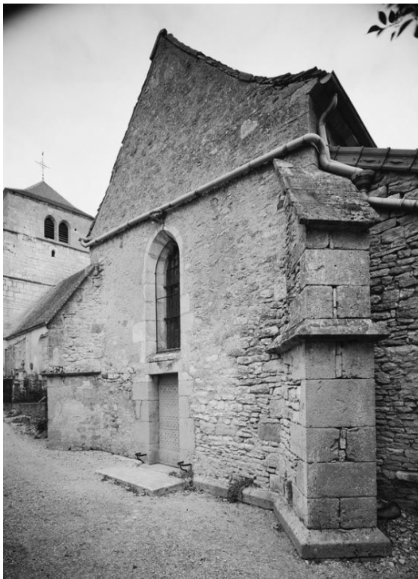
Chapelle droite, mur droit.
