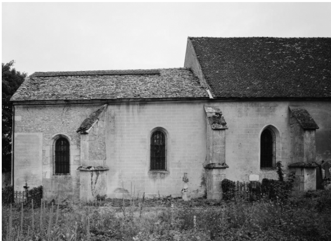
Choeur, mur gauche.
