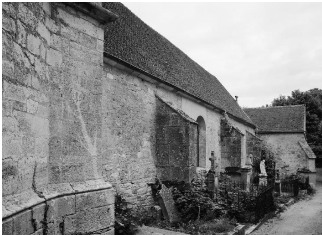
Nef, mur droit.
