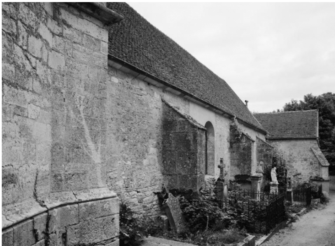
Nef, mur droit.
