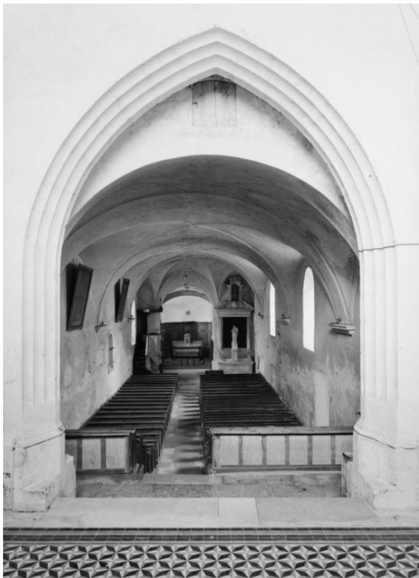
Vue d'ensemble de l'intérieur, depuis l'entrée.
