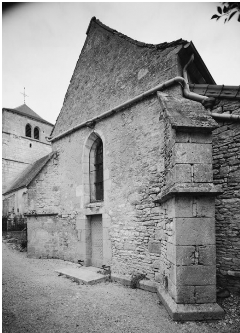
Chapelle droite, mur droit.
