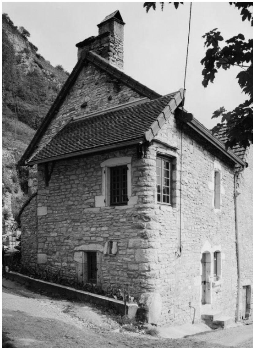
Vue générale de la maison sise parcelle 1466, section D7 du cadastre de 1940. 21, Saint-Romain
