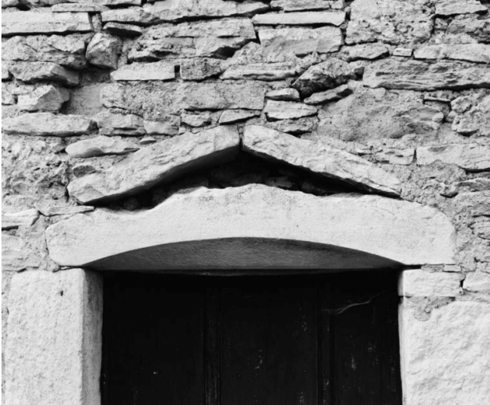
Détail du linteau sur la maison sise parcelle 1704, section D7 du cadastre de 1940. 21, Saint-Romain
