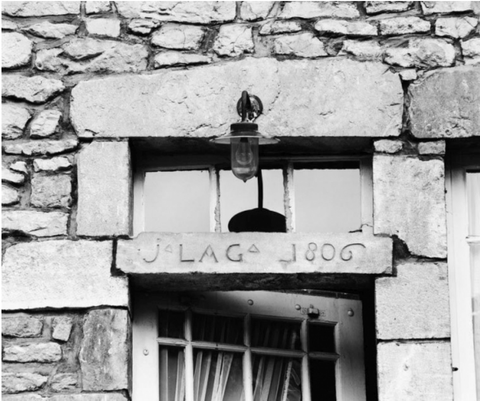
Détail de la fenêtre en dessus de porte de la maison sise parcelle 1311, section D7 du cadastre de 1940. 21, Saint-Romain
