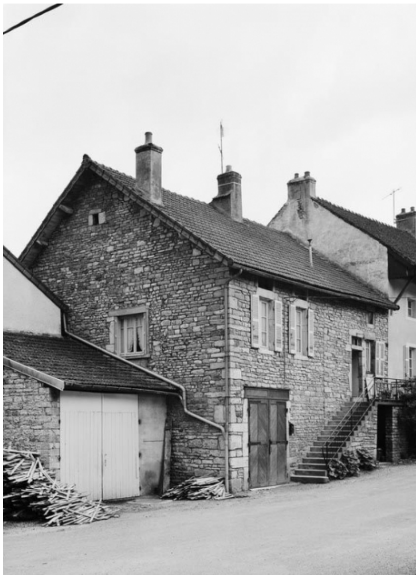
Vue d'ensemble de la maison sise parcelle 1311, section D7 du cadastre de 1940. 21, Saint-Romain
