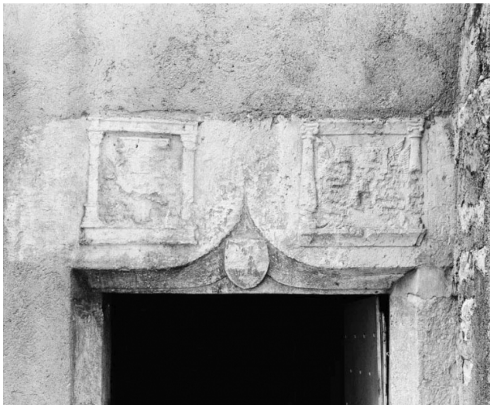
Détail du linteau de la porte de la maison sise parcelle 1378, section D7 du cadastre de 1940. 21, Saint-Romain
