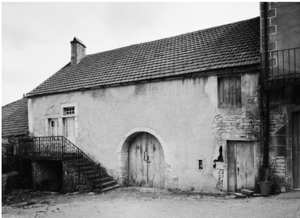
Vue d'ensemble de la maison sise parcelle 1340, section D7 du cadastre de 1940. 21, Saint-Romain
