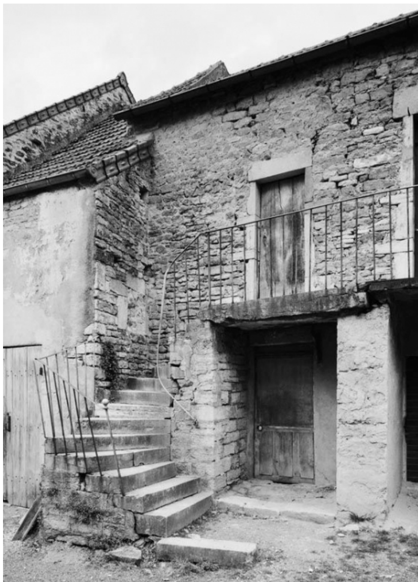
Vue d'ensemble de la maison sise parcelle 1313, section D7 du cadastre de 1940. 21, Saint-Romain
