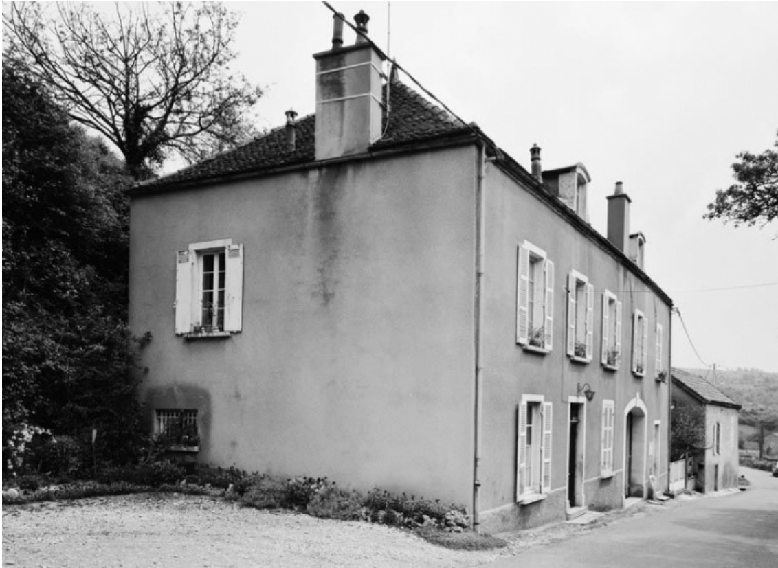
Vue générale de la maison sise parcelle 1416, section D7 du cadastre de 1940. 21, Saint-Romain
