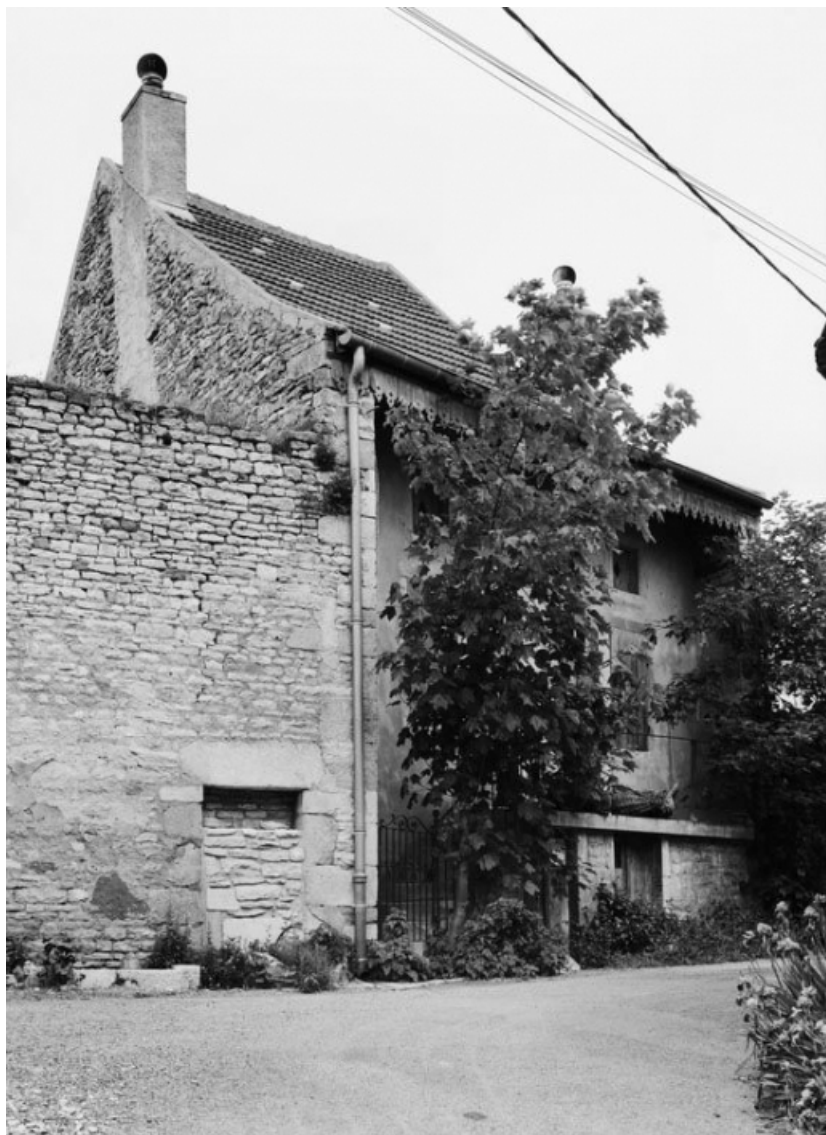
Vue d'ensemble de la maison sise parcelle 1845-46, section D7 du cadastre de 1940. 21, Saint-Romain
