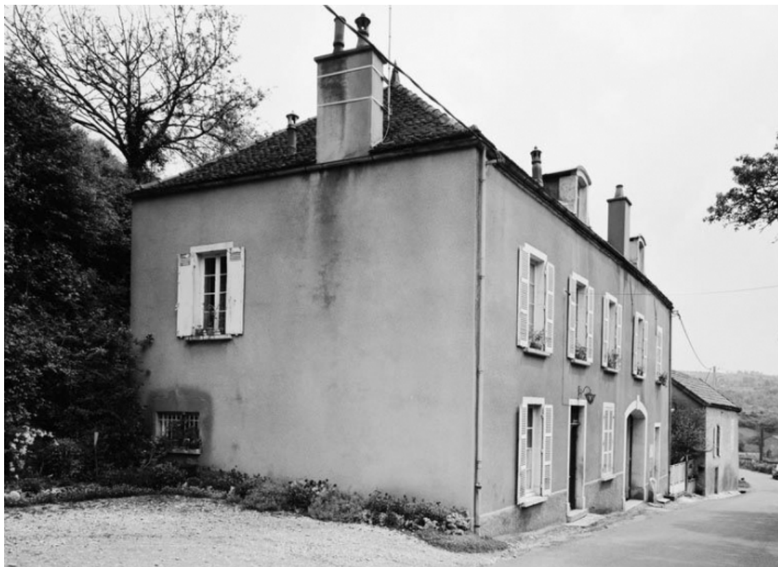
Vue générale de la maison sise parcelle 1416, section D7 du cadastre de 1940. 21, Saint-Romain
