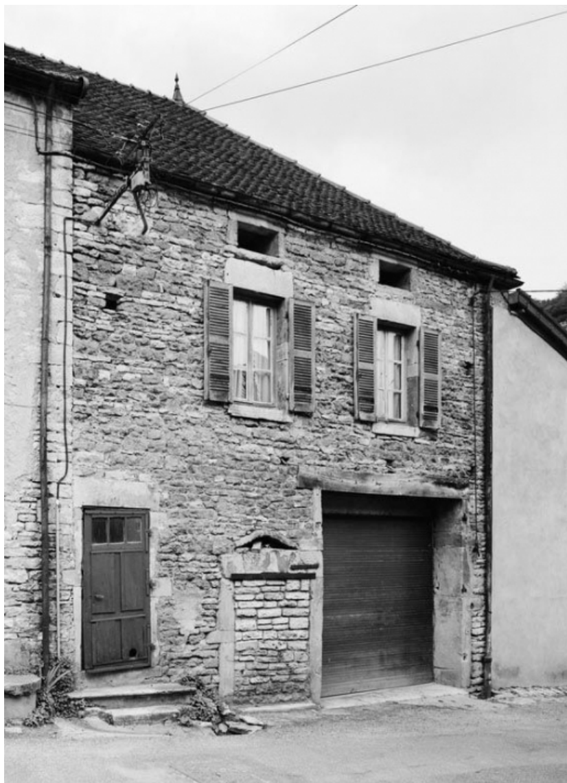
Façade de la maison sise parcelle 1593, section D7 du cadastre de 1940. 21, Saint-Romain
