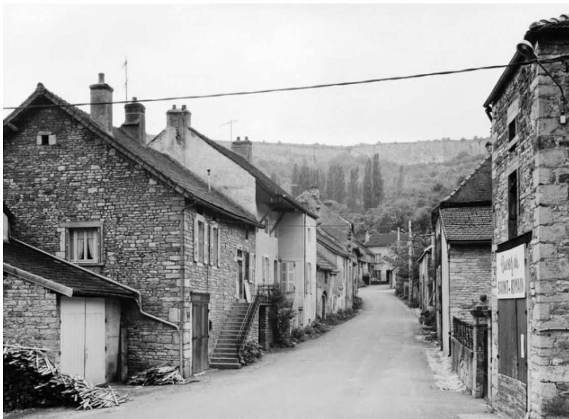
Vue d'ensemble de la maison sise rue de Pierre Ronde. 21, Saint-Romain
