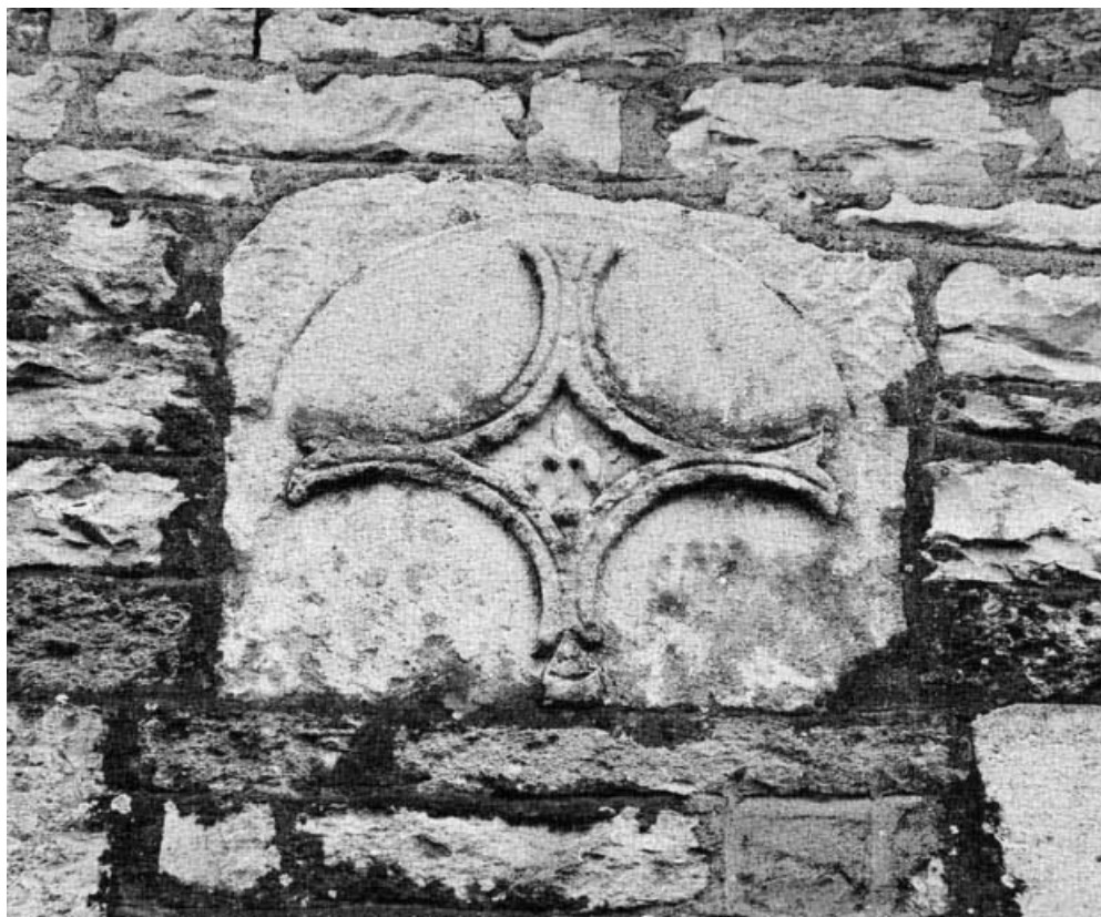
Détail de la croix sculptée en remploi dans la façade.
