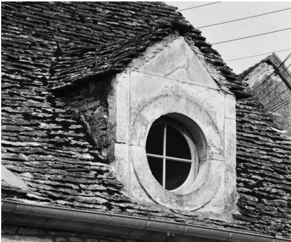
Détail de la lucarne droite, de trois quarts.
