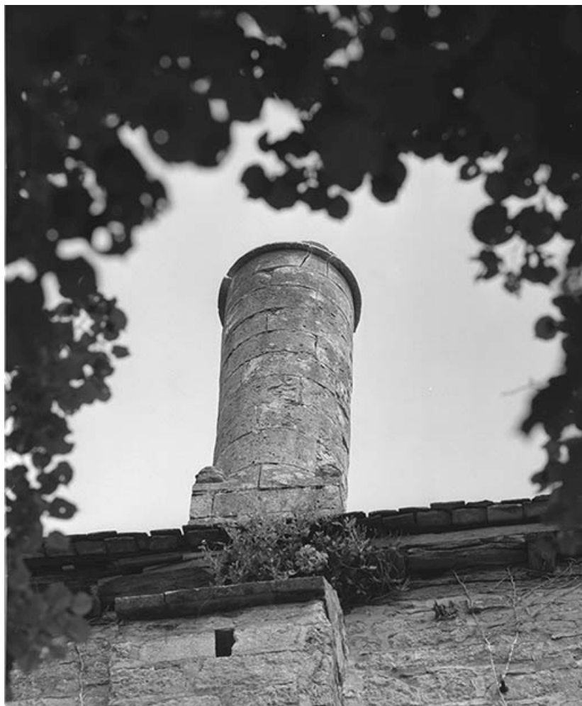
Souche de cheminée sur la tour (versant droit).
