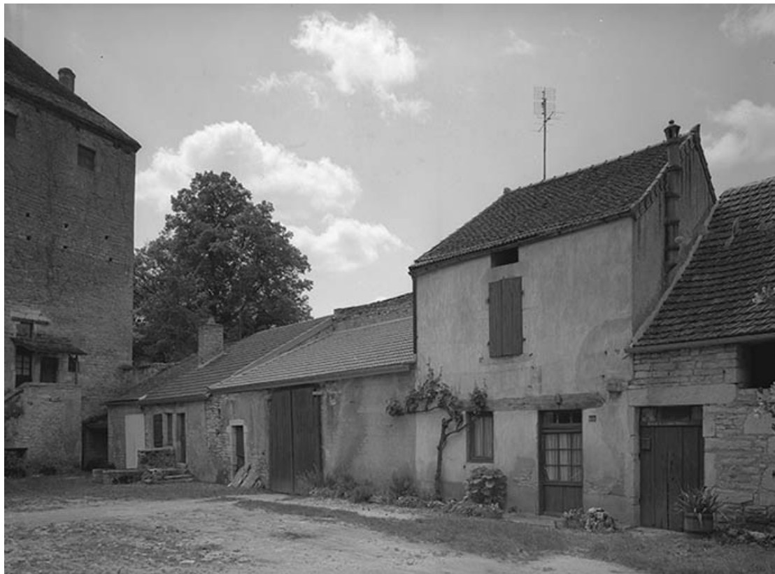
Corps de bâtiment bordant la cour à droite.
