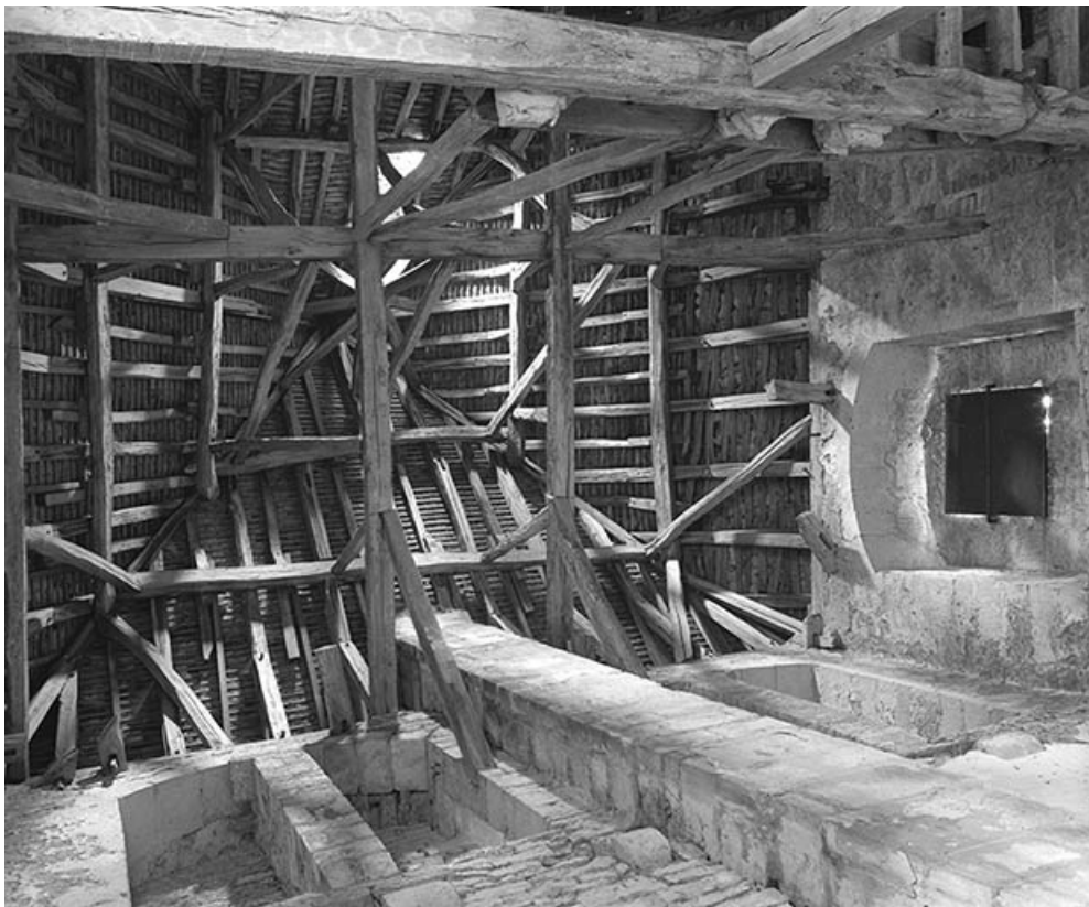
Baies de l'étage supérieur et charpente de la tour.
