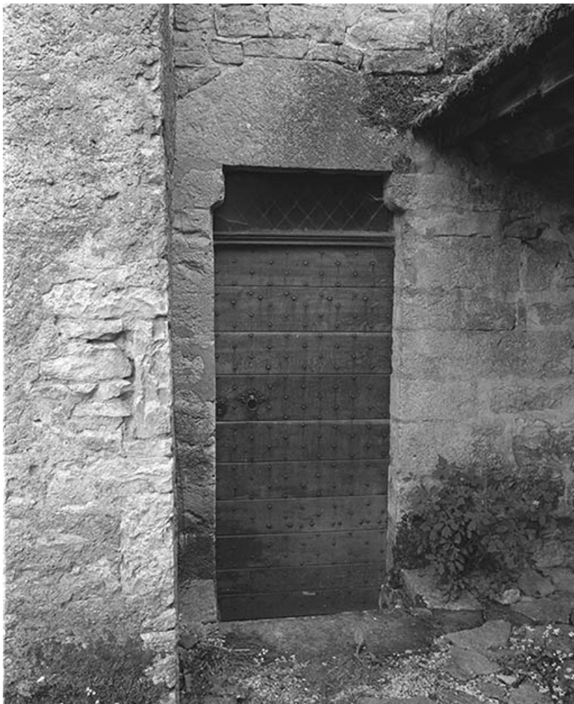
Face antérieure de la tour : porte d'entrée de la salle basse.
