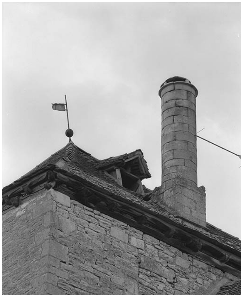
Souche de cheminée sur la tour (versant gauche).
