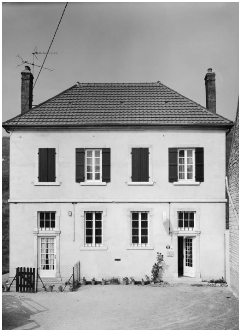
Vue générale. 21, Saint-Aubin
