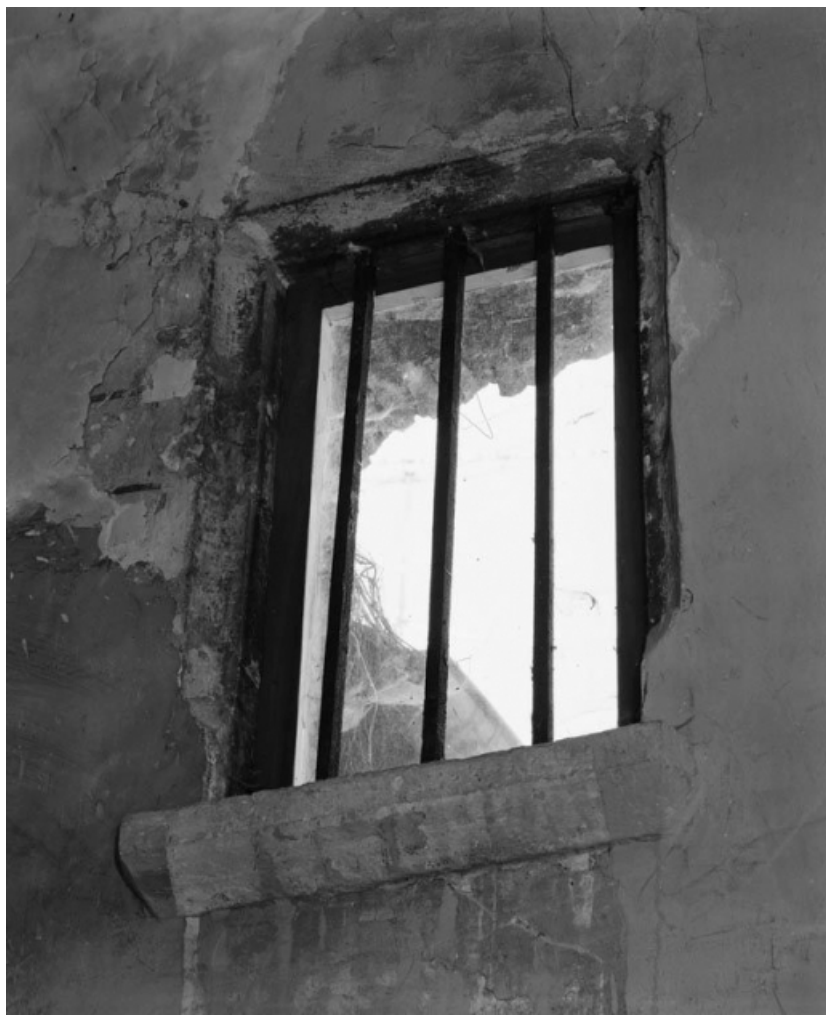
Nef : fenêtre du mur gauche.
