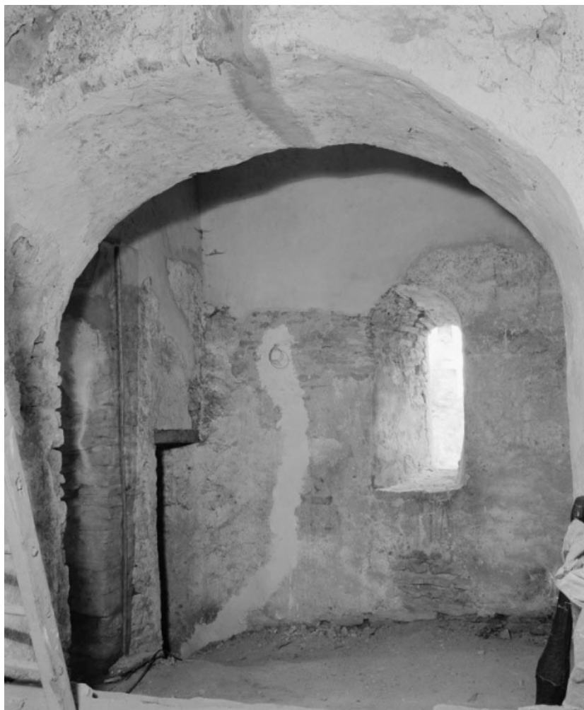
Massif postérieur, 1er étage : partie latérale gauche, depuis la tribune. 21, Saint-Aubin
