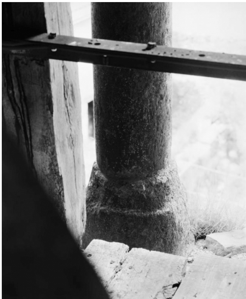
Clocher, 2 e étage : colonnette gauche, détail de la base. 21, Saint-Aubin
