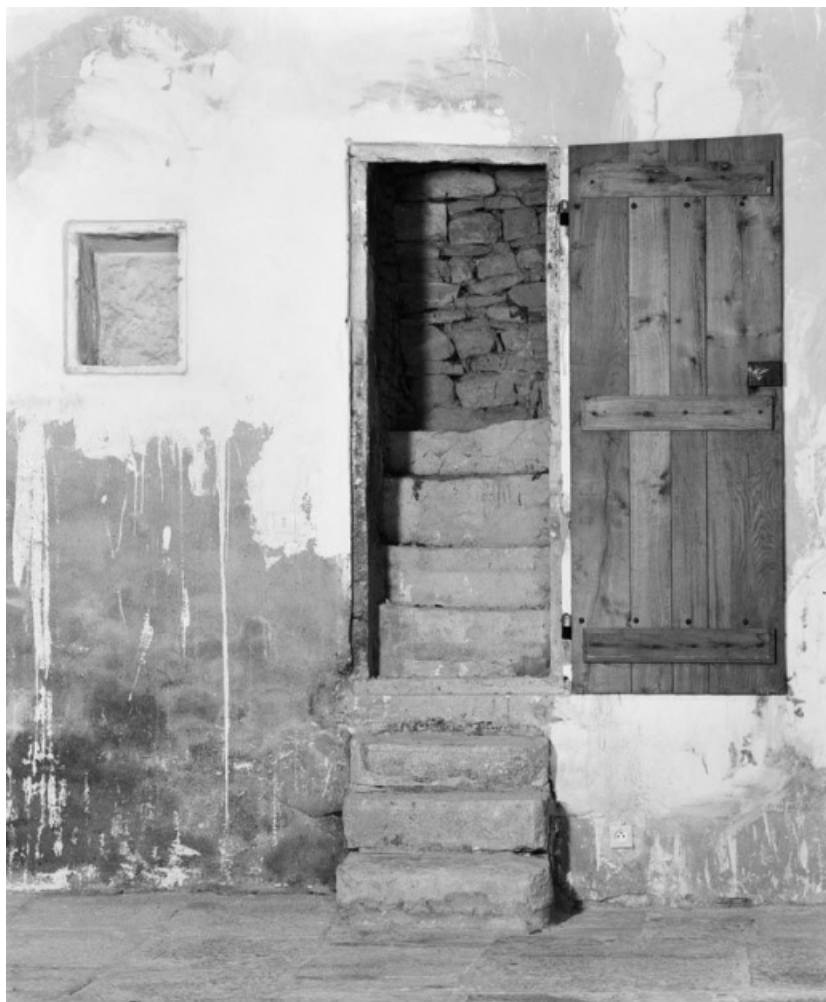
Nef : porte de l'escalier desservant l'étage du massif postérieur (mur gauche), 21, Saint-Aubin
