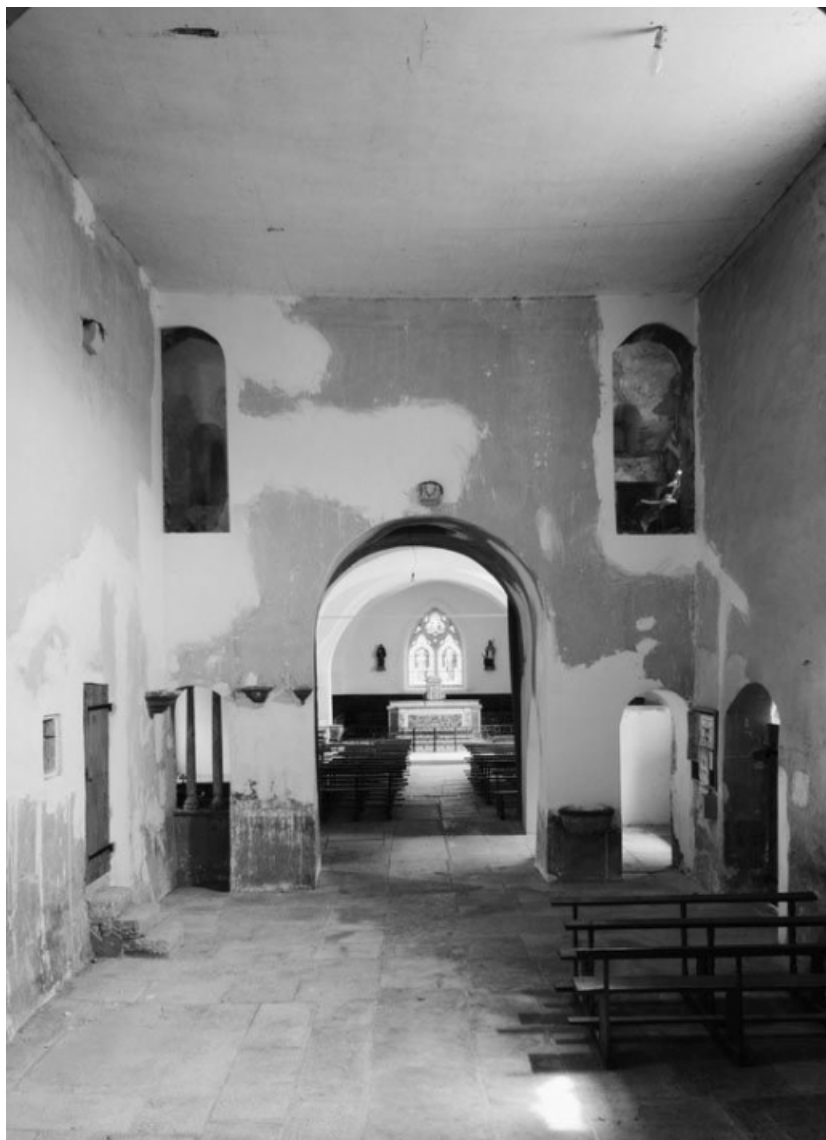
La nef depuis l'entrée.
