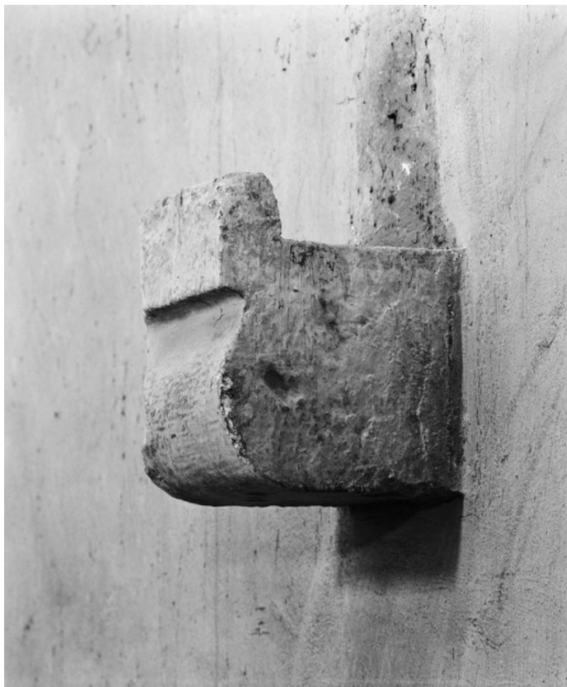
Nef : corbeau du mur droit.
