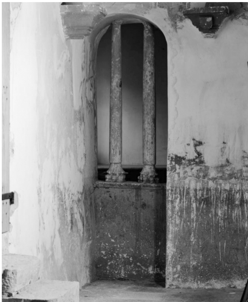
Massif postérieur : arcade de la chapelle gauche. 21, Saint-Aubin
