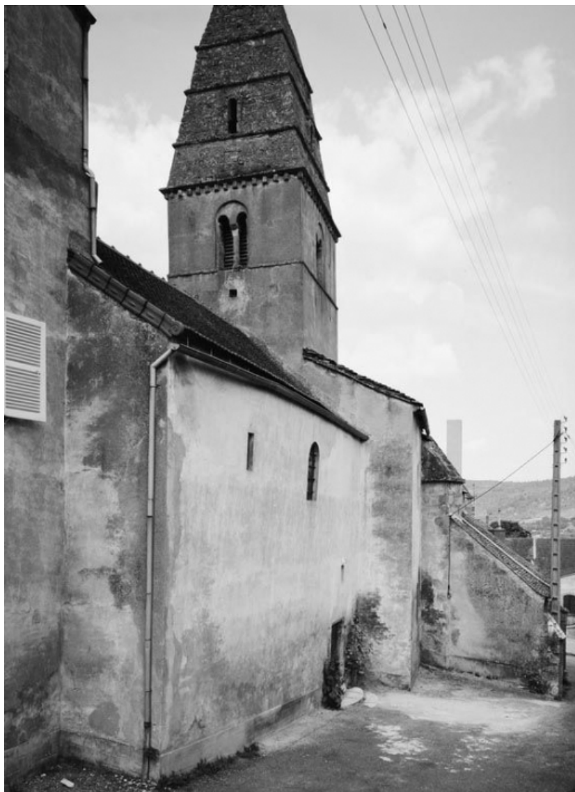
Élévation droite de la nef. 21, Saint-Aubin
