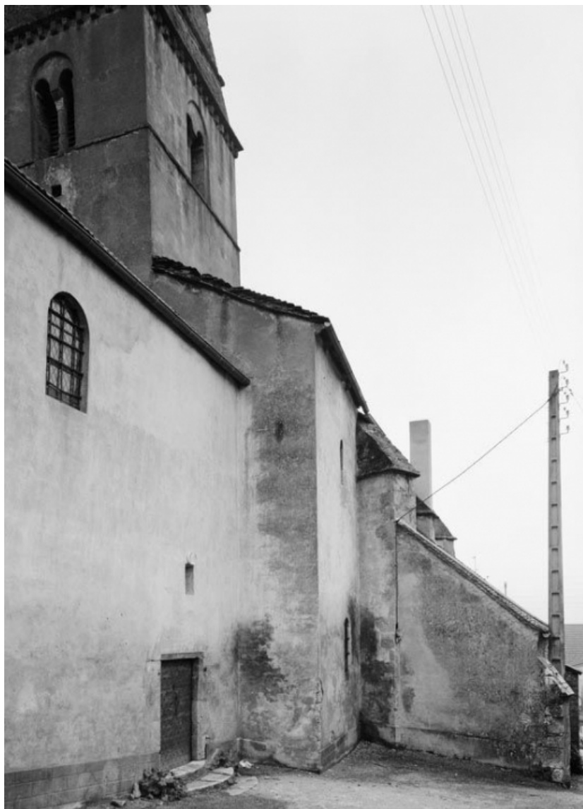
Élévation droite de la nef et du massif postérieur.
