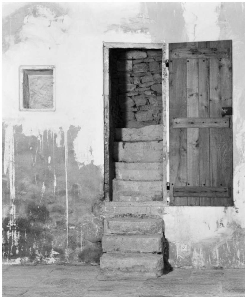
Nef : porte de l'escalier desservant l'étage du massif postérieur (mur gauche), 21, Saint-Aubin
