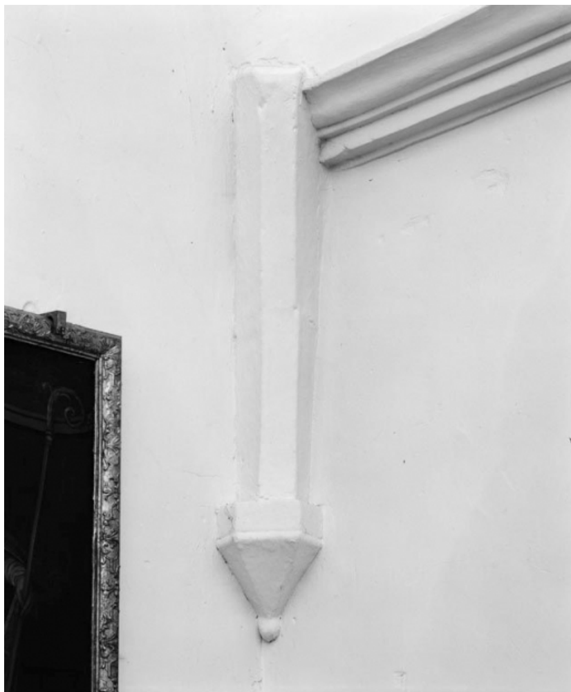
Choeur, partie antérieure : culot antérieur gauche. 21, Saint-Aubin
