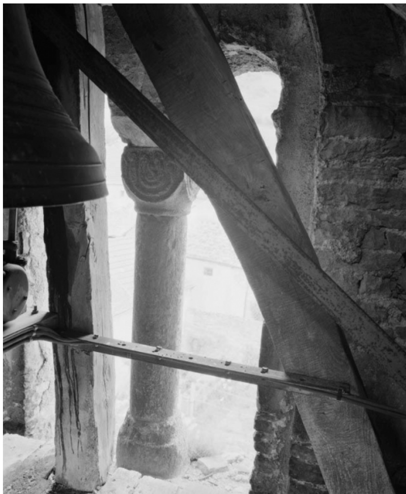
Clocher, 2 e étage : colonnette gauche. 21, Saint-Aubin
