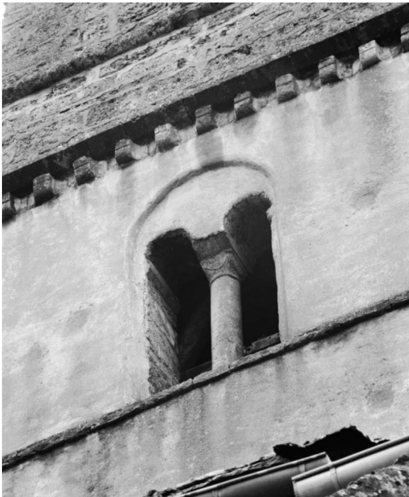
Clocher : baies de la face droite. 21, Saint-Aubin
