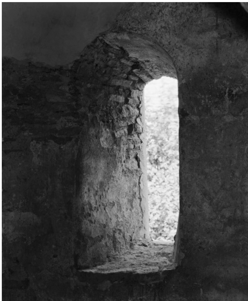
Massif postérieur, 1er étage : fenêtre latérale de la partie gauche. 21, Saint-Aubin
