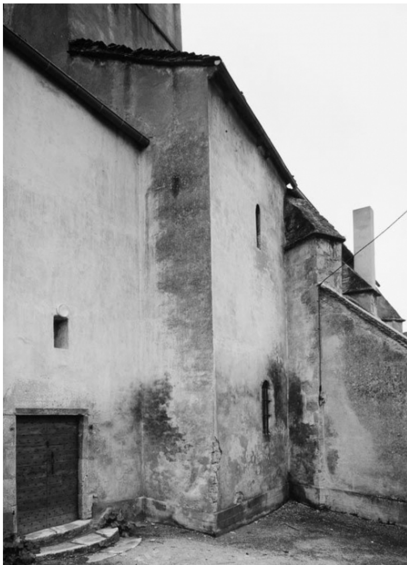
Élévation droite du massif postérieur. 21, Saint-Aubin
