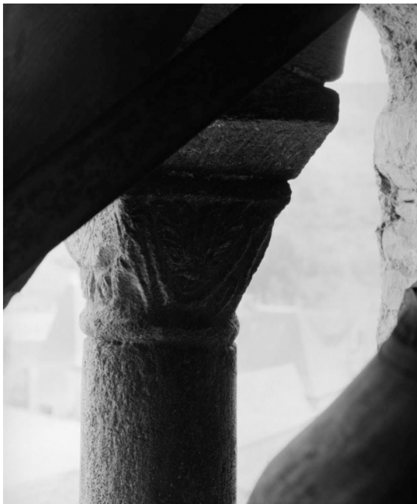
Clocher, 2è étage : colonnette droite, chapiteau, face interne. 21, Saint-Aubin
