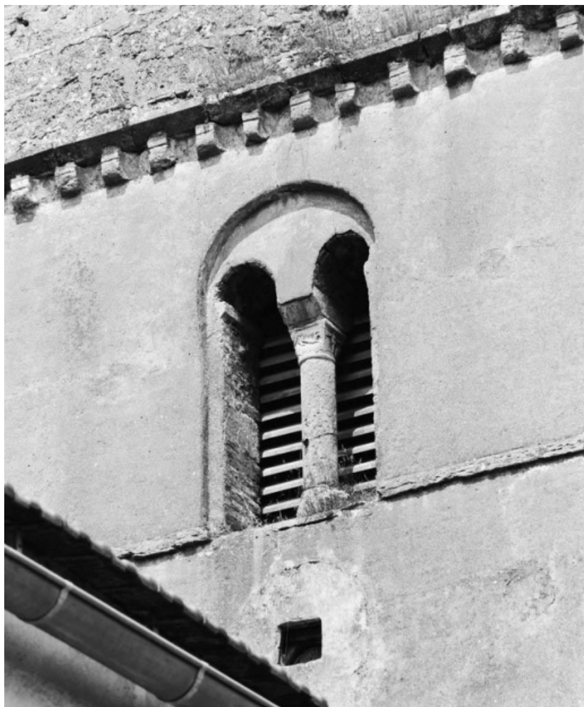
Clocher : baies de la face antérieure. 21, Saint-Aubin
