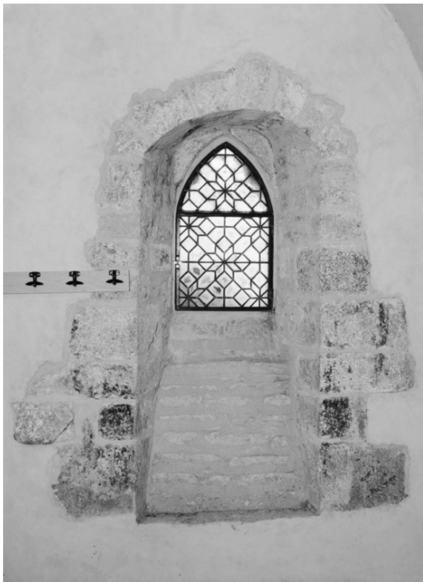
Fenêtre de la chapelle du choeur.
