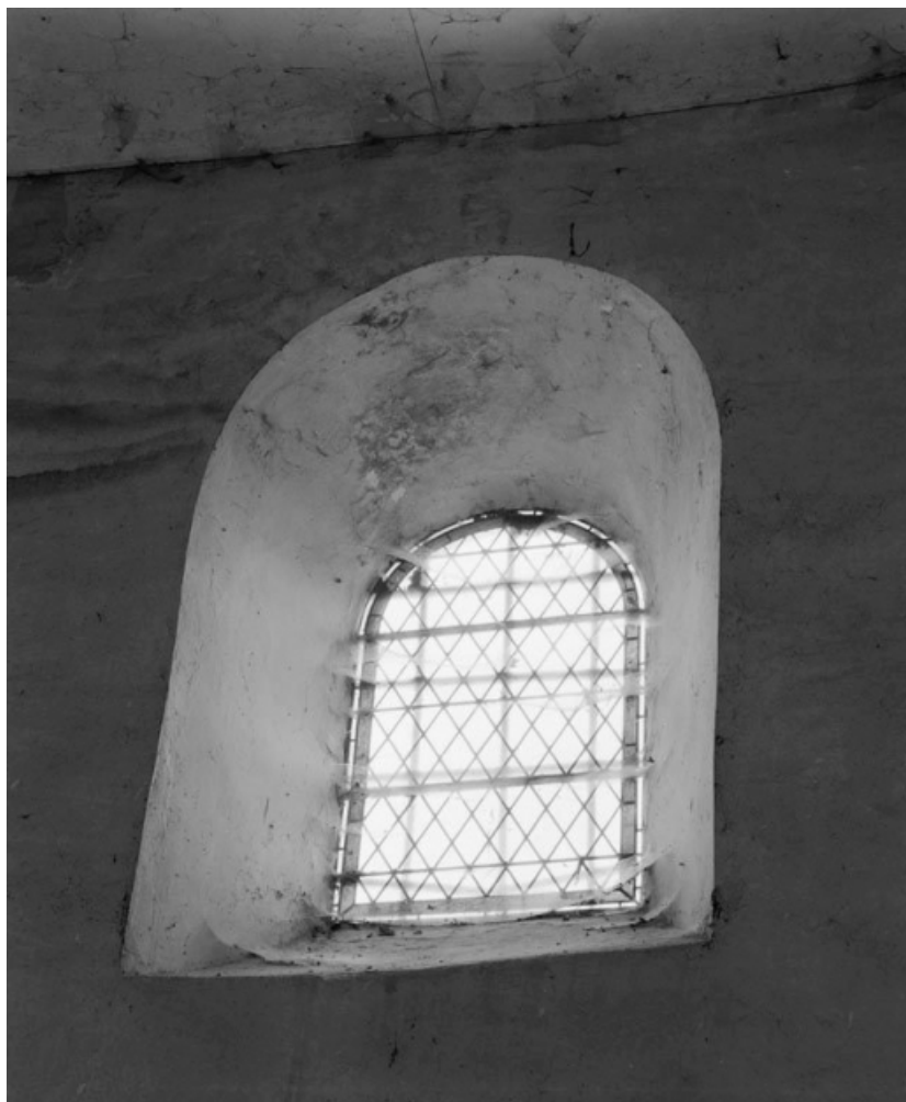
2ème fenêtre du mur droit de la nef. 21, Saint-Aubin
