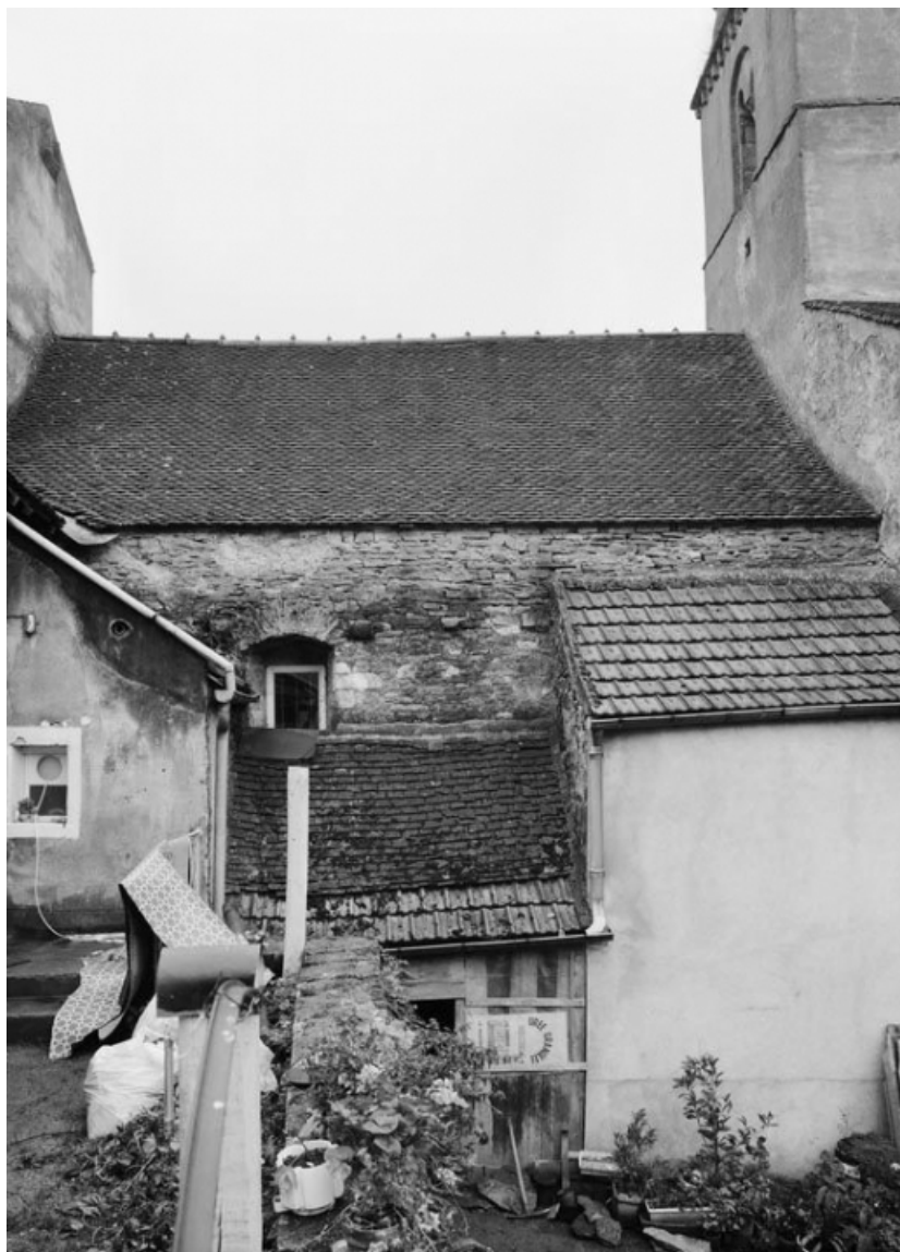
Élévation gauche de la nef. 21, Saint-Aubin
