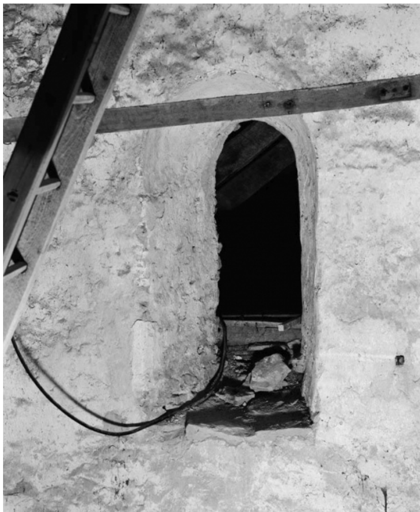
Massif postérieur, 1er étage : fenêtre de la tribune. 21, Saint-Aubin
