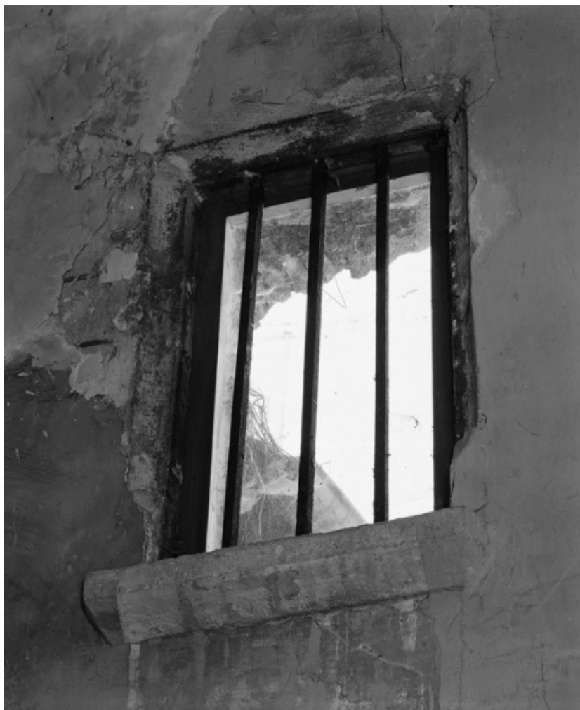
Nef : fenêtre du mur gauche.
