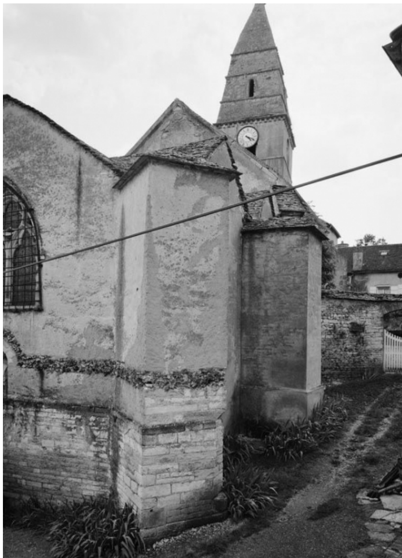
Élévation gauche du choeur et du chevet. 21, Saint-Aubin
