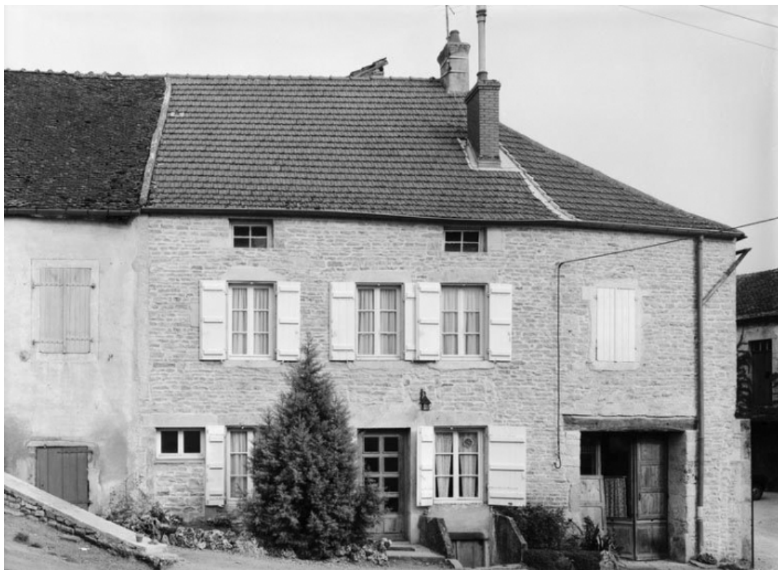
Vue d'ensemble de la maison, sise parcelle 52, section D1 sur le cadastre de 1959. 21, Saint-Aubin
