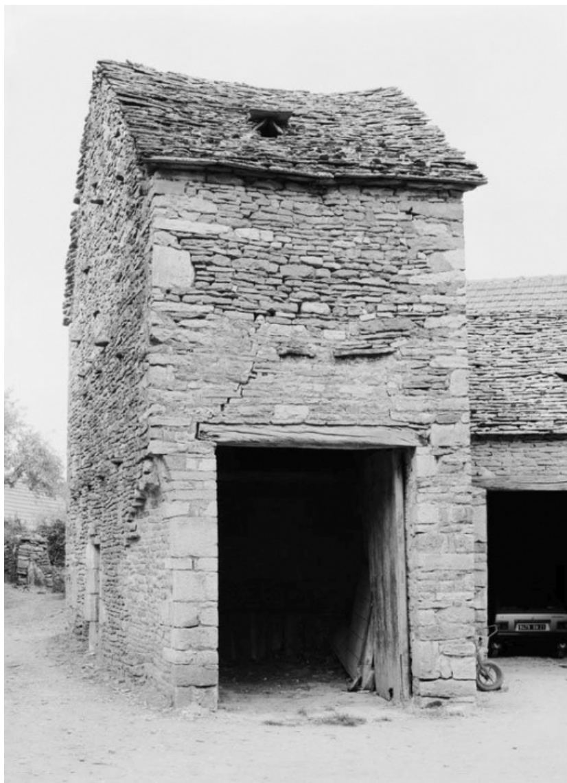
Remise sise parcelle 89, section D1 sur le cadastre de 1959. 21, Saint-Aubin
