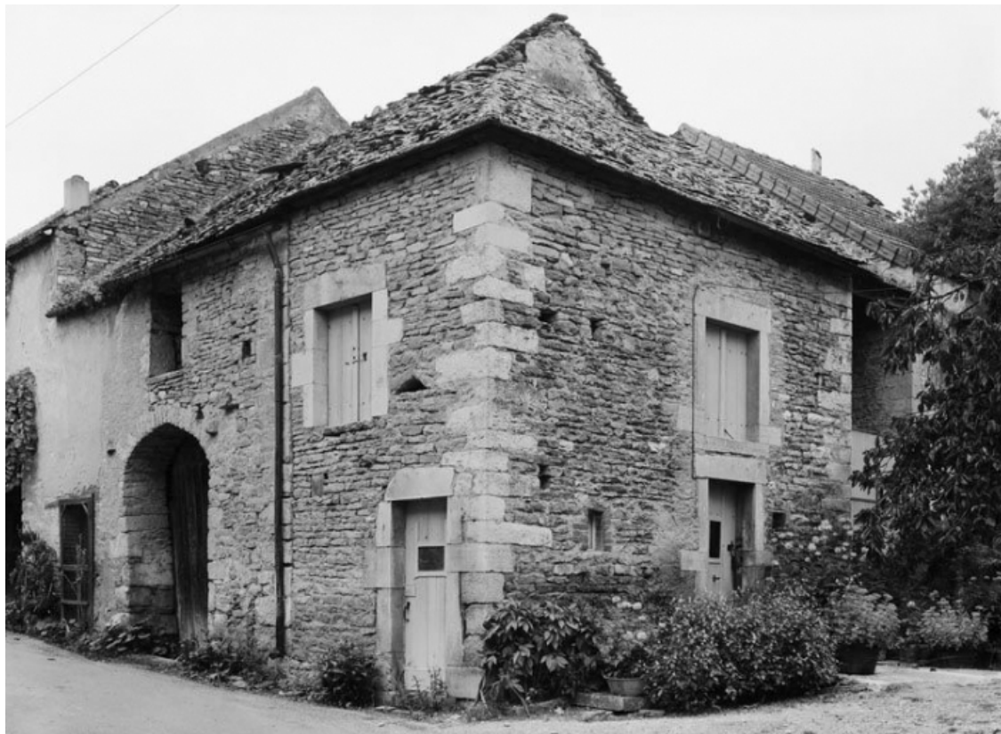
Vue d'ensemble de la maison sise parcelle 17, section D1 sur le cadastre de 1959. 21, Saint-Aubin
