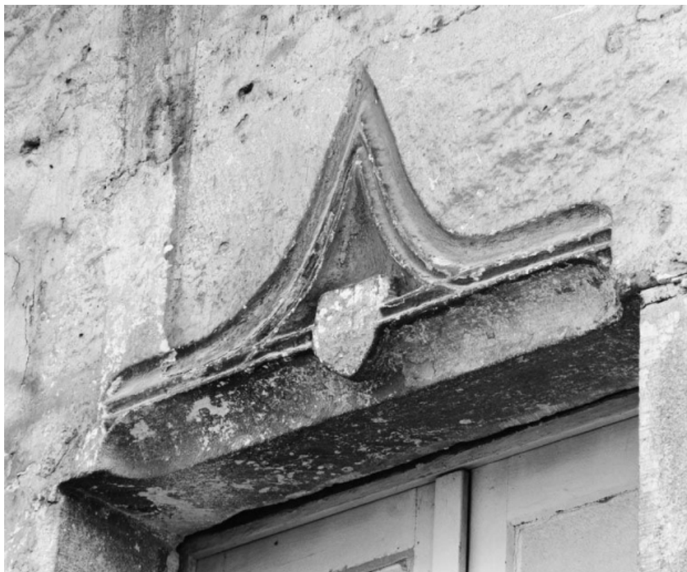
Détail du linteau en remploi sur la maison sise parcelle 111, section D1 sur le cadastre de 1959. 21, Saint-Aubin
