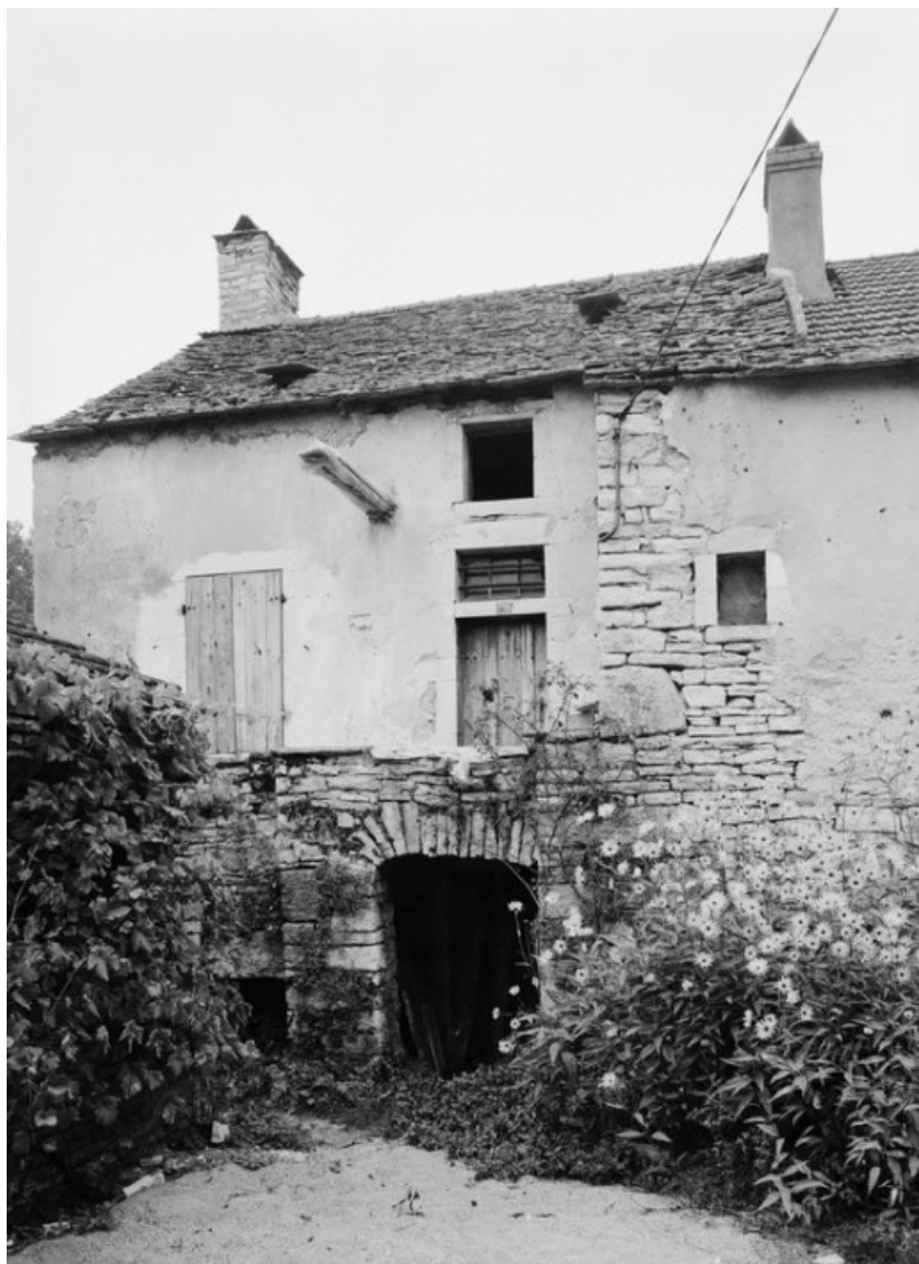
Vue d'ensemble de la maison sise parcelle 123, section A1 sur le cadastre de 1959. 21, Saint-Aubin
