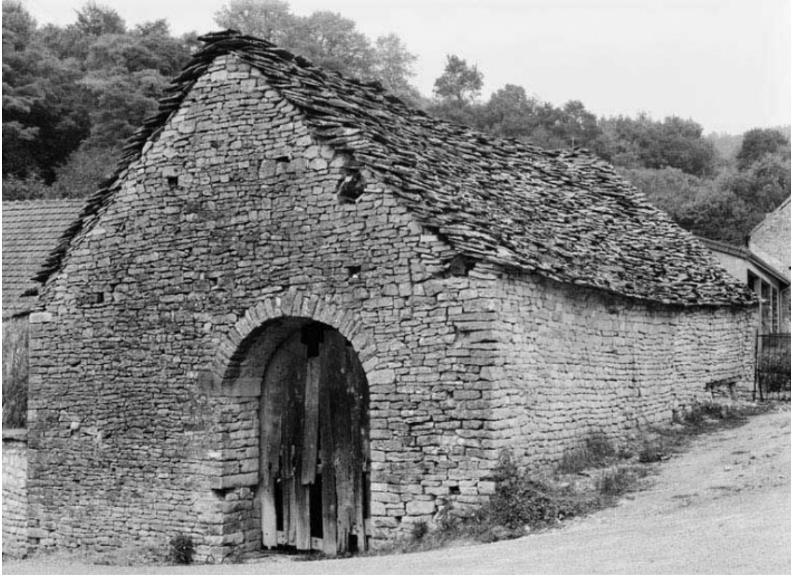
Cuverie de la maison sise parcelle 48, section A1 sur le cadastre de 1959. 21, Saint-Aubin
