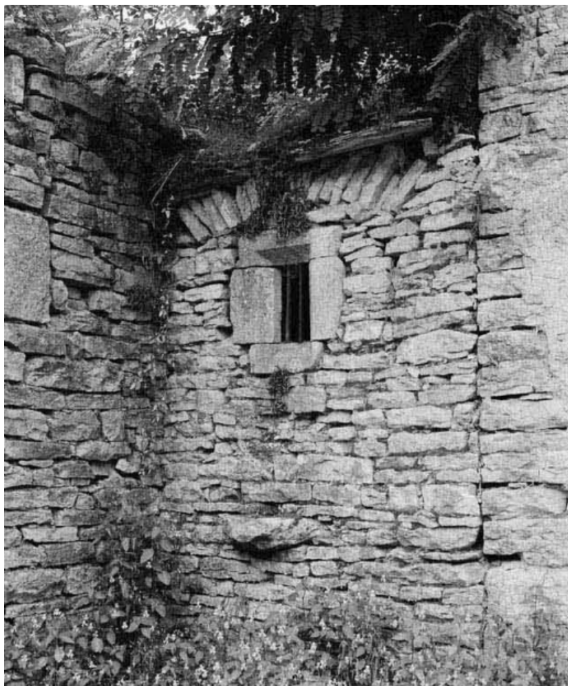
Souillarde de la maison sise parcelle 87, section A1 sur le cadastre de 1959. 21, Saint-Aubin
