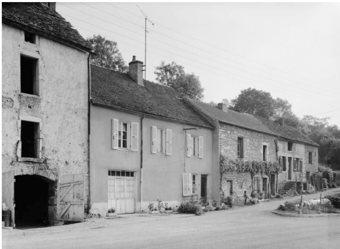
Alignement de maisons, parcelles 1152 à 1154, section A7 sur le cadastre de 1959. 21, Saint-Aubin
