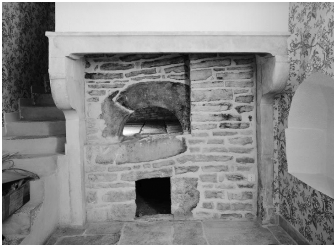
Cheminée avec four à pain dans la maison sise parcelle 35, section A1 sur le cadastre de 1959. 21, Saint-Aubin
