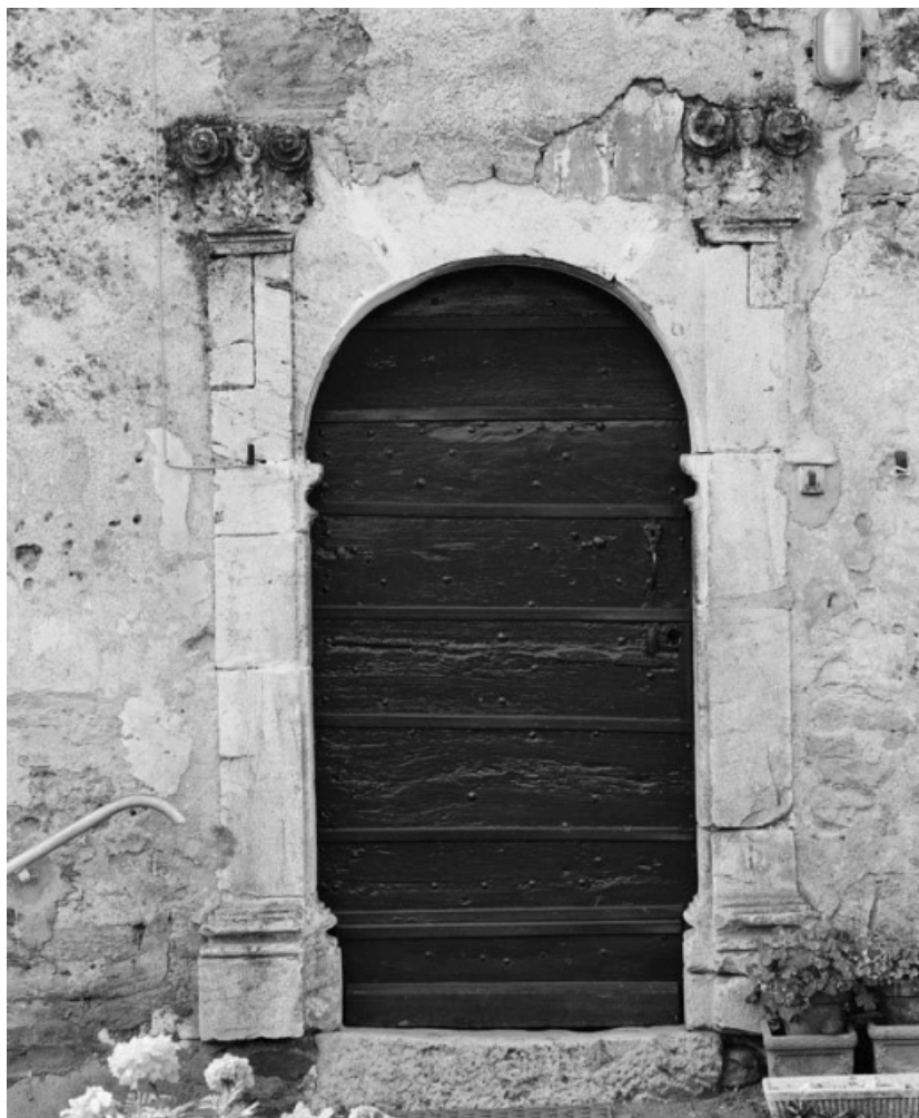
Détail de la porte du logis de la maison sise parcelle 22, section D1 sur le cadastre de 1959. 21, Saint-Aubin
