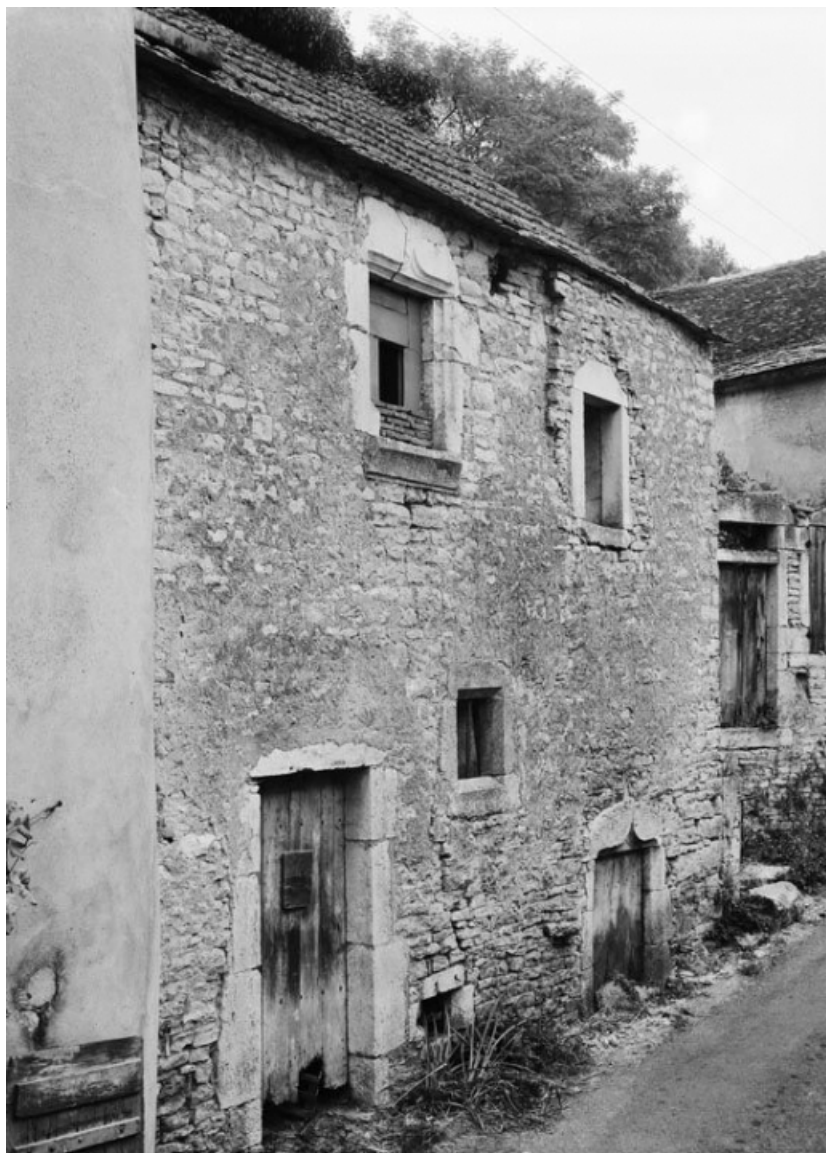
Vue d'ensemble de la maison sise parcelle 83, section A1 sur le cadastre de 1959. 21, Saint-Aubin
