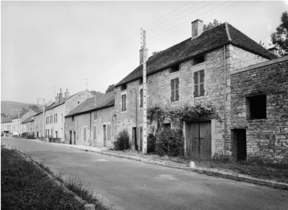
Alignement de maisons, parcelles 1157 à 1160, section A7 sur le cadastre de 1959. 21, Saint-Aubin
