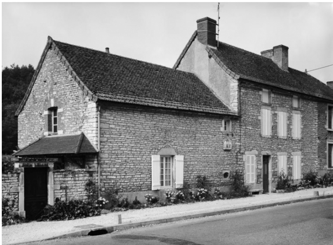
Vue de la maison sise parcelle 155, section B1 sur le cadastre de 1959. 21, Saint-Aubin
