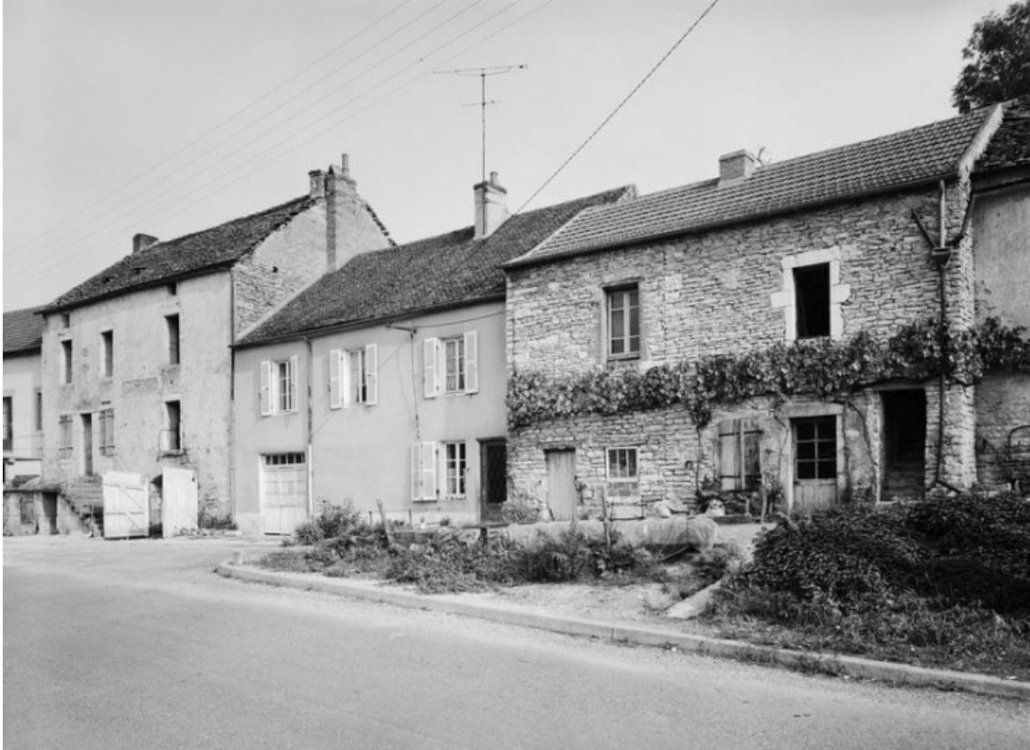
Alignement de maisons, parcelles 1151 à 1153, section A7 sur le cadastre de 1959. 21, Saint-Aubin
