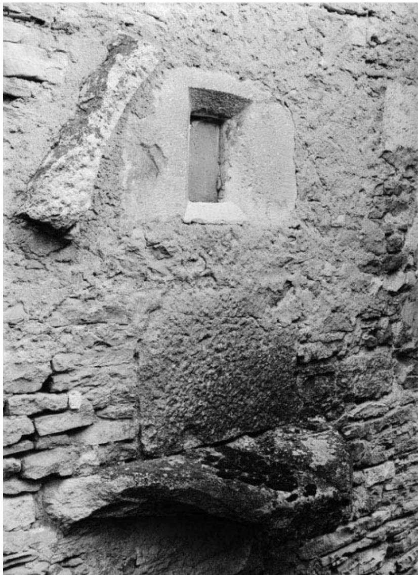
Jour et pierre d'écoulement sur la maison, sise parcelle 59, section D1 sur le cadastre de 1959. 21, Saint-Aubin
