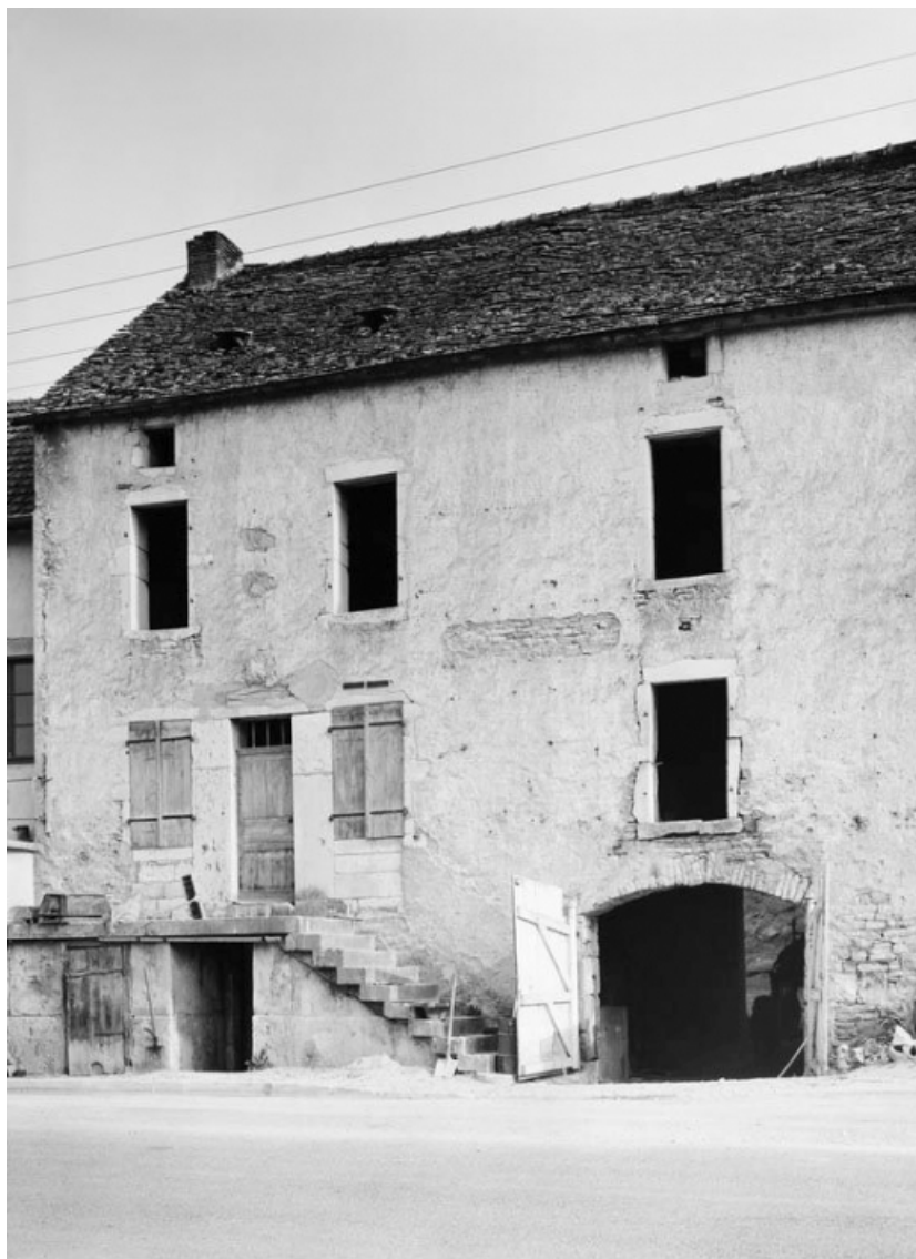
Vue d'ensemble de la maison sise parcelle 1152a, section A7 sur le cadastre de 1959. 21, Saint-Aubin
