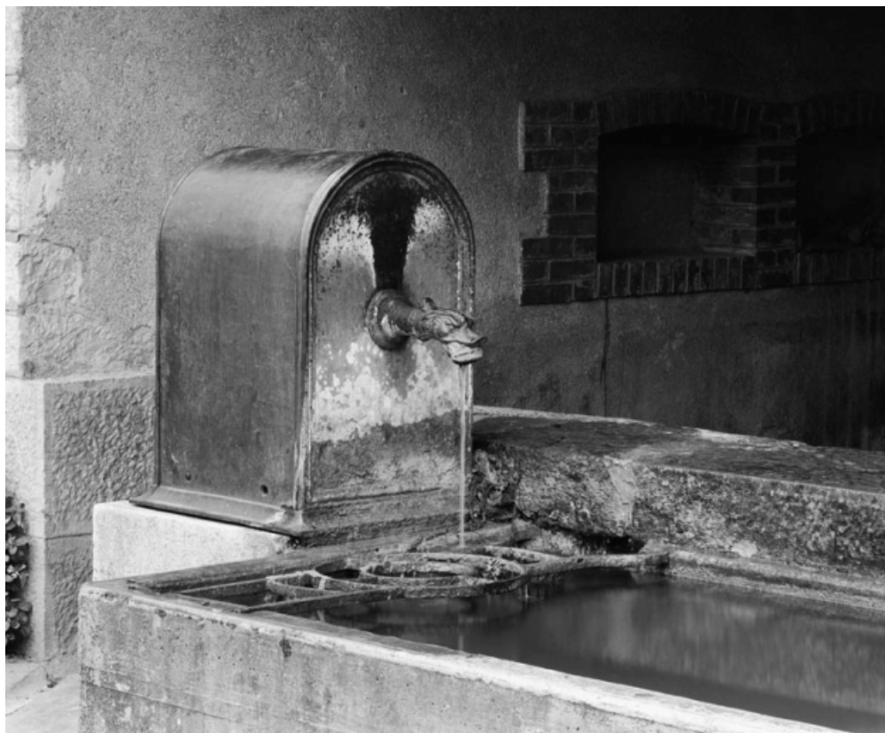
Détail de la borne-fontaine.
