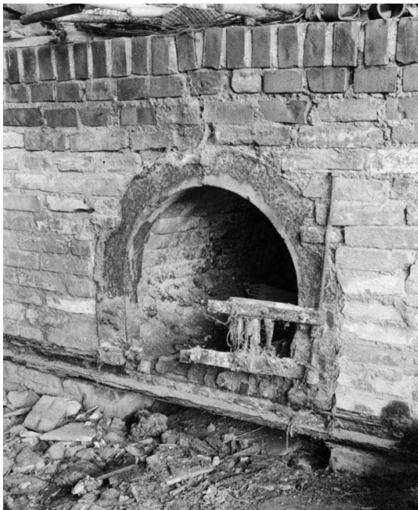
Détail du four : bouche d'enfournement du bois.
