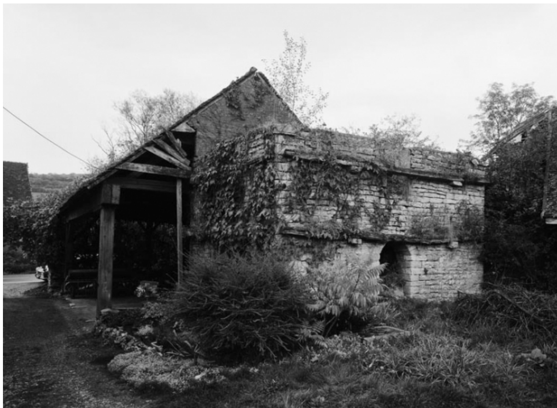
Bâtiment du four et four : élévation postérieure.
