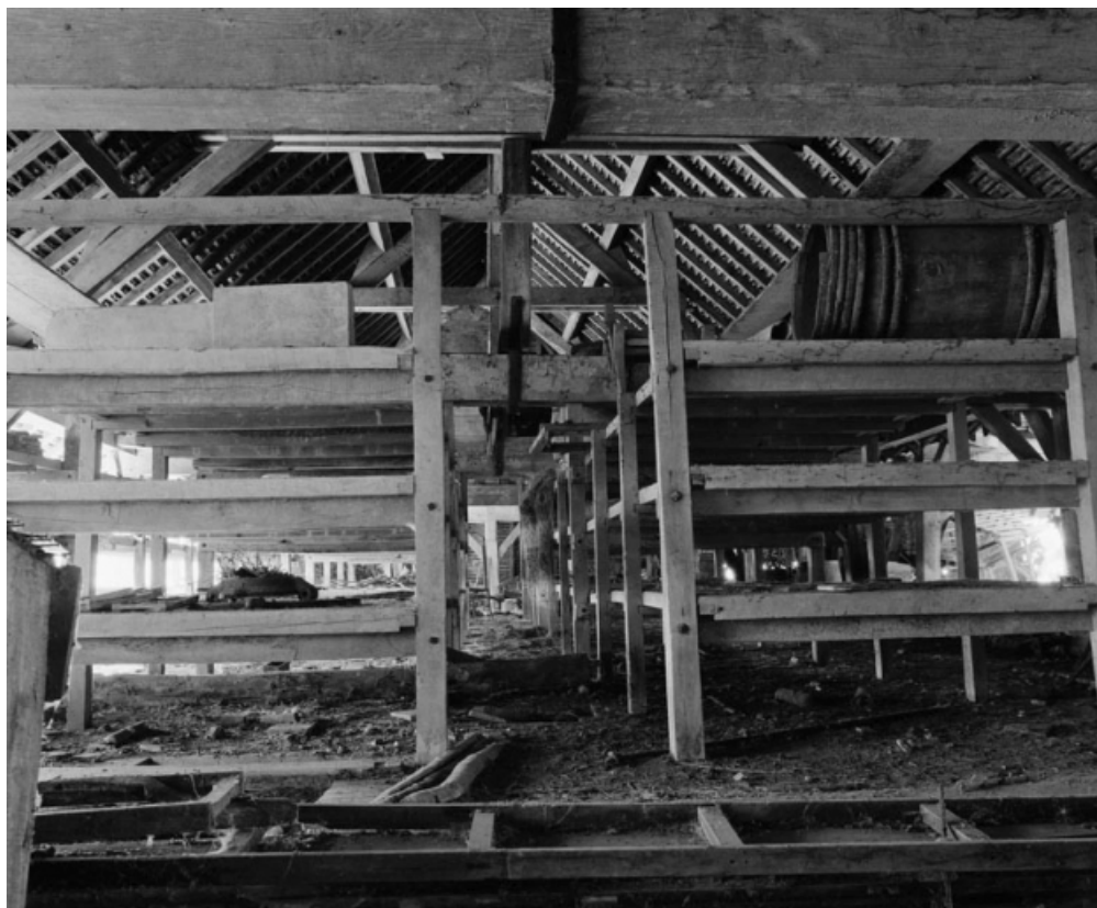
Vue des séchoirs, depuis l'extrémité est.
