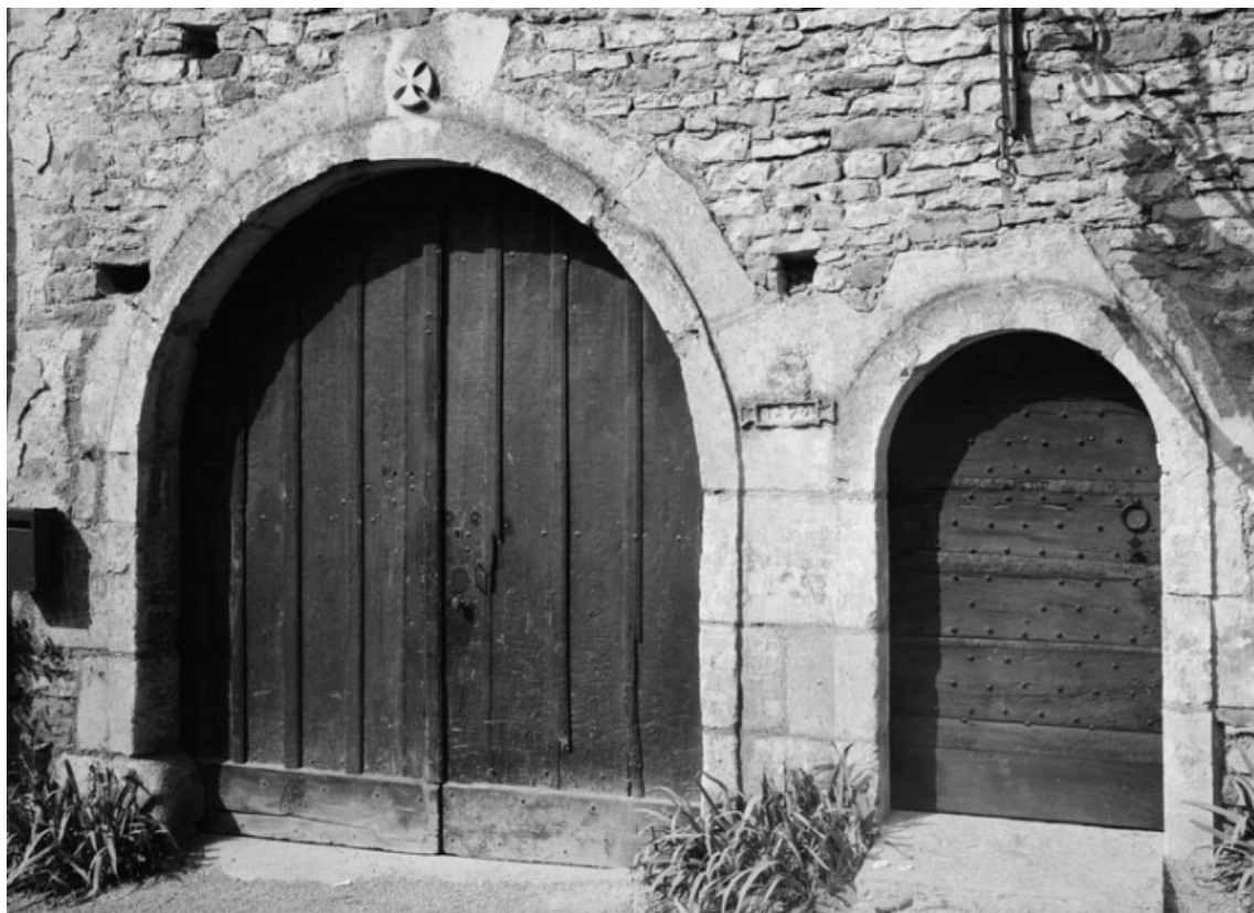
Détail des portes.
