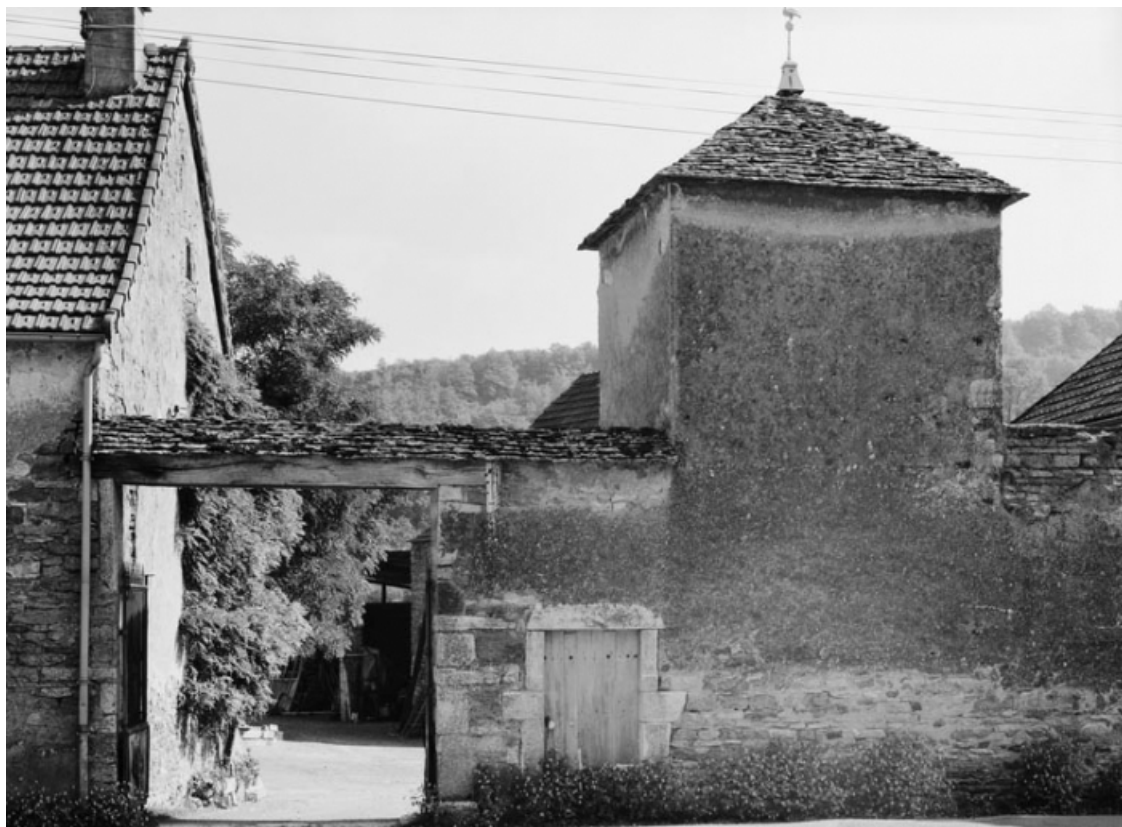
Porte charretière et colombier sis parcelle 307a, section B1 du cadastre de 1951. 21, La Rochepot
