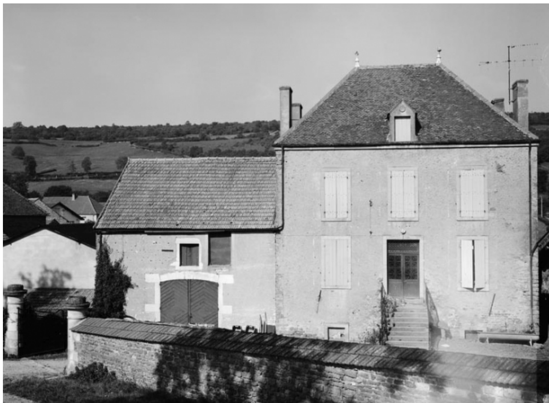
Vue d'ensemble de la maison sise parcelle 334, section B1 du cadastre de 1951. 21, La Rochepot
