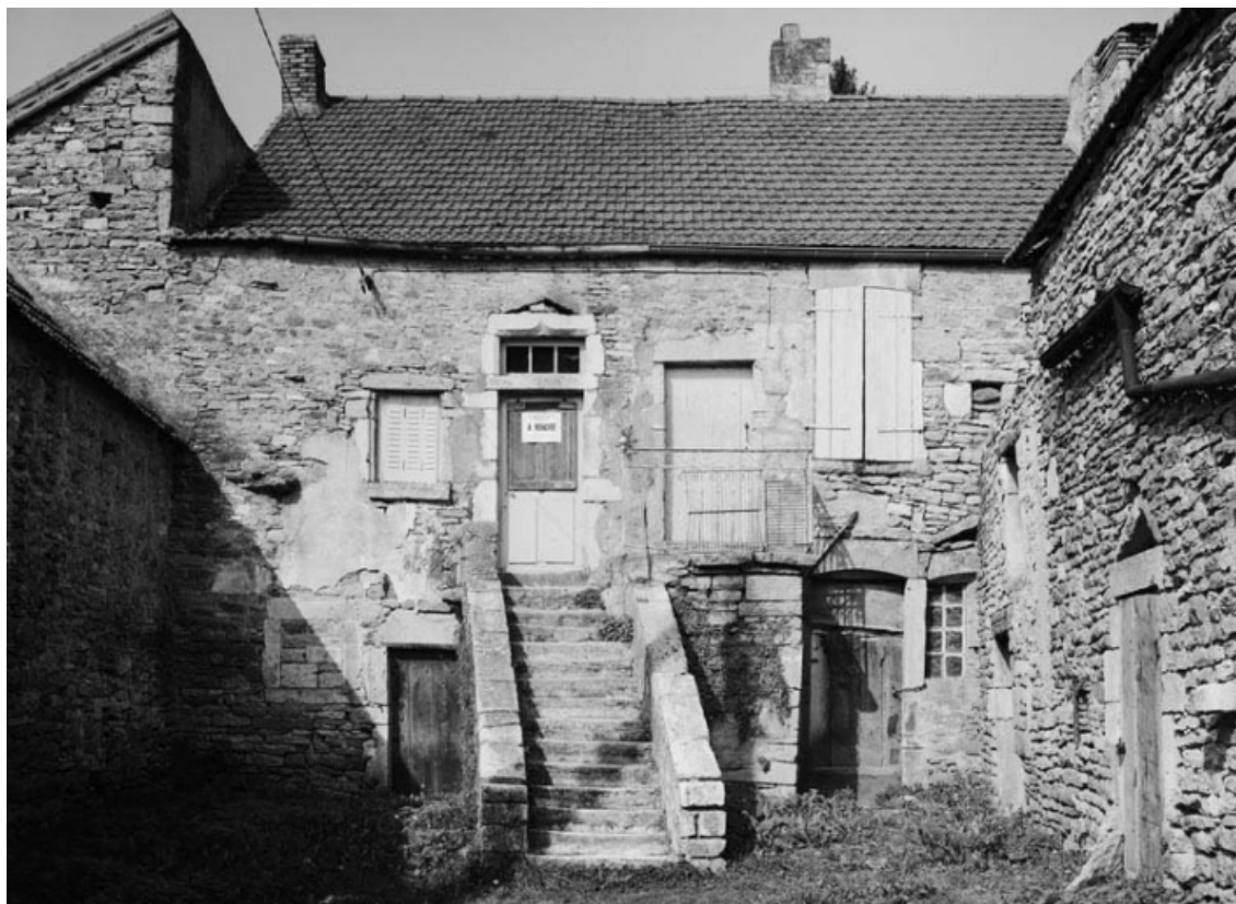
Vue générale de la maison sise parcelles 75 et 77, section B1 du cadastre de 1951. 21, La Rochepot
