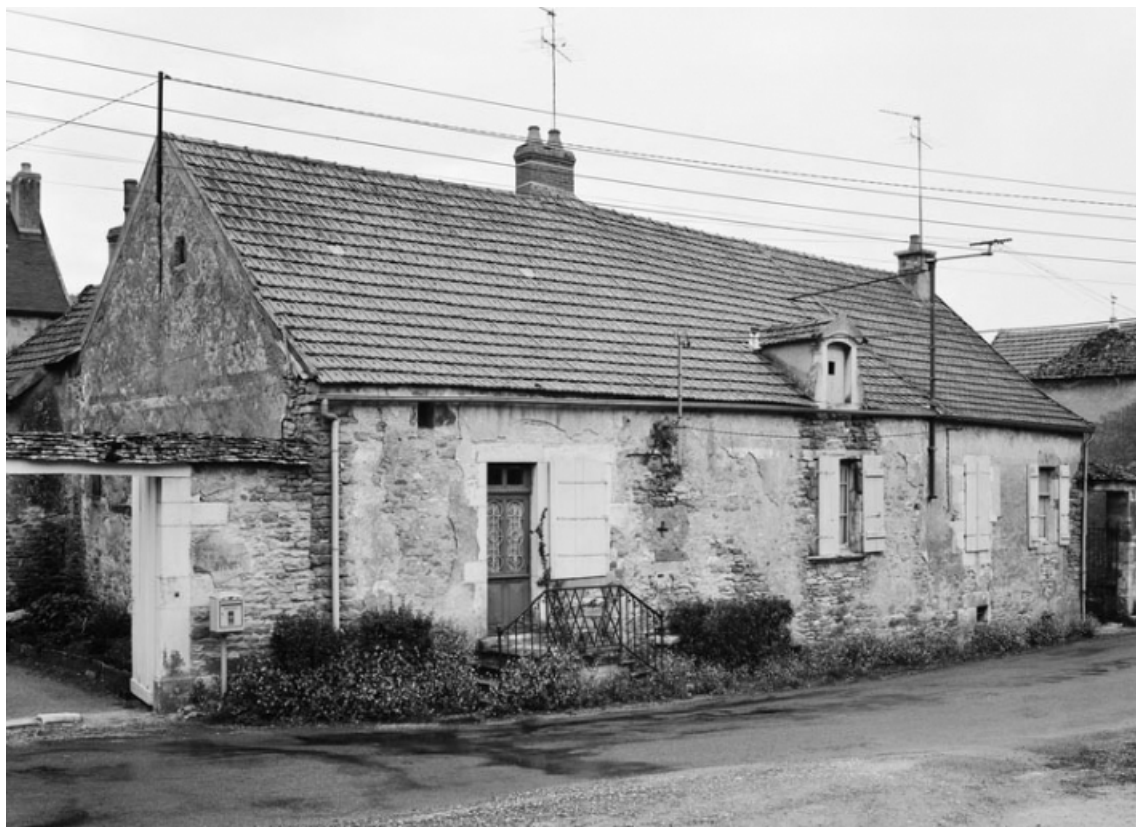
Vue d'ensemble de la maison sise parcelle 306a, section B1 du cadastre de 1951. 21, La Rochepot
