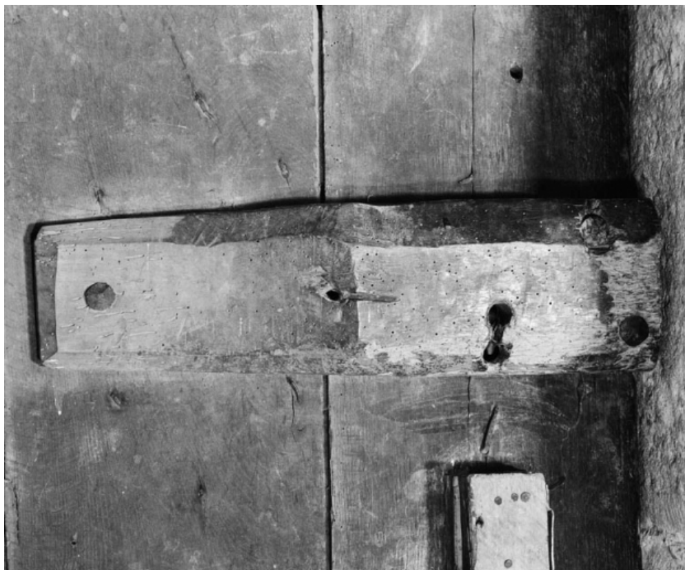
Détail de la serrure en bois de la maison sise parcelle 157, section B1 du cadastre de 1951. 21, La Rochepot
