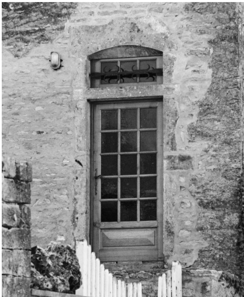
Porte d'entrée de la maison sise parcelle 337, section B1 du cadastre de 1951. 21, La Rochepot
