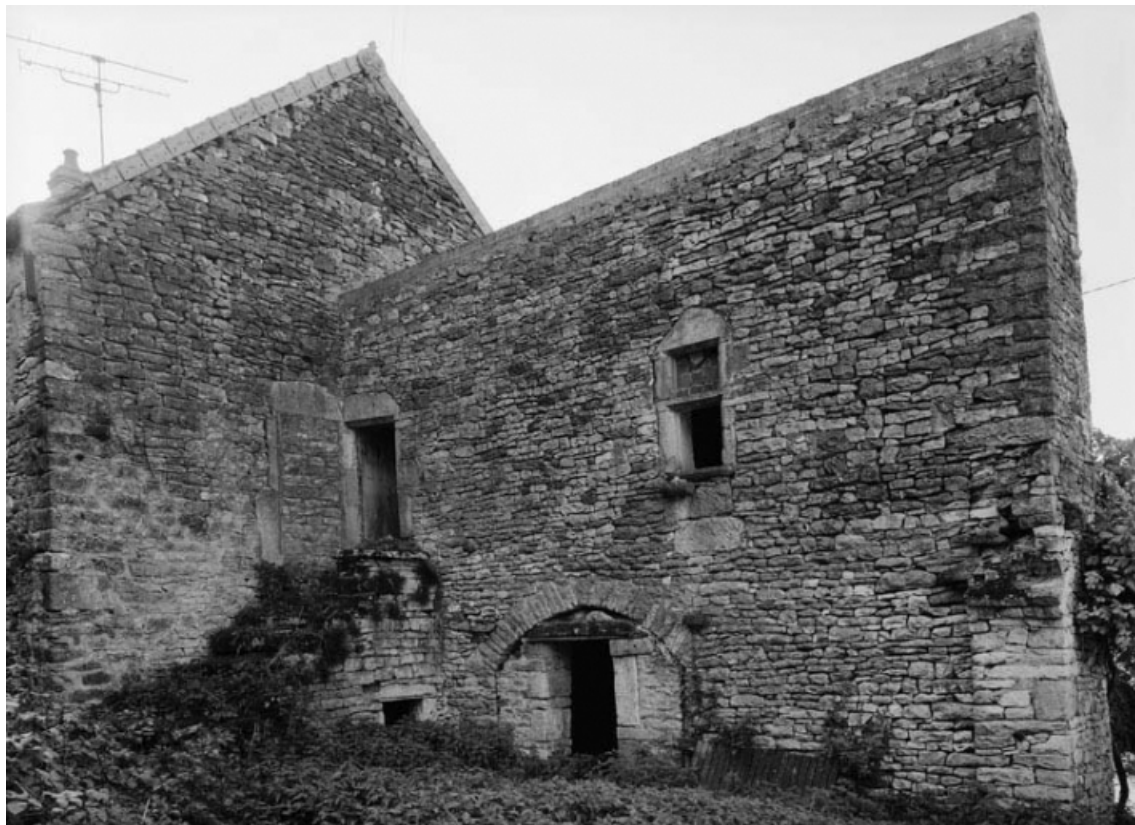
Vue générale de la maison sise parcelle 114, section B1 du cadastre de 1951. 21, La Rochepot
