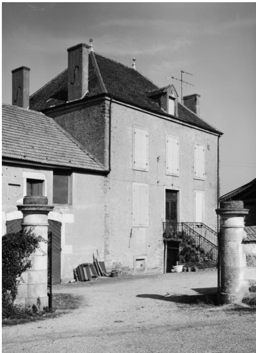
Vue d'ensemble de la maison sise parcelle 334, section B1 du cadastre de 1951. 21, La Rochepot
