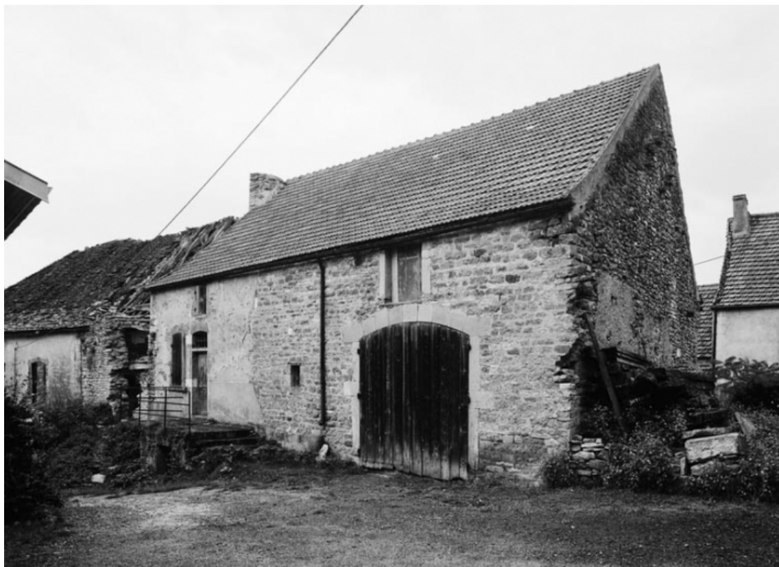
Vue d'ensemble de la maison sise parcelle 188, section B1 du cadastre de 1951. 21, La Rochepot
