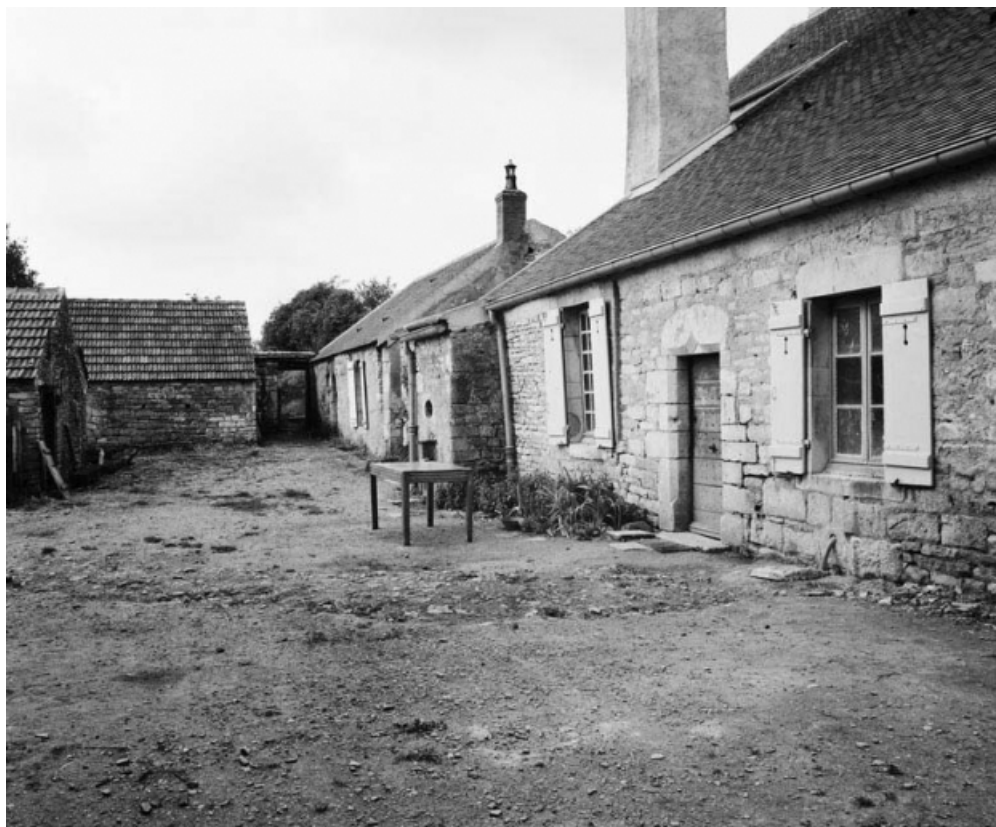
Vue d'ensemble des bâtiments actuels.
