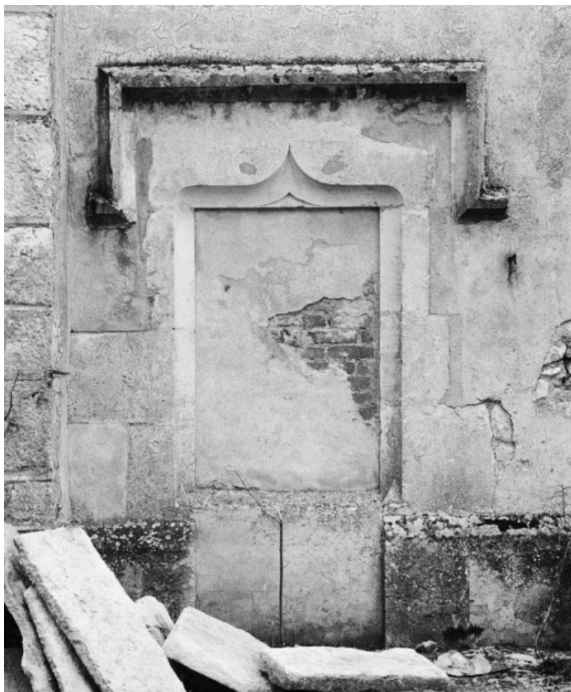
Porte murée de l'élévation droite de la chapelle Saint-Denis.
