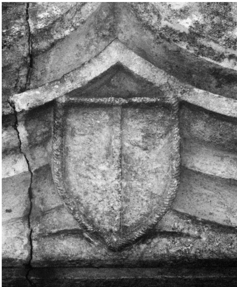
Détail du blason de la porte de la façade antérieure de la chapelle Saint-Denis. 21, Puligny-Montrachet, lieudit : Blagny
