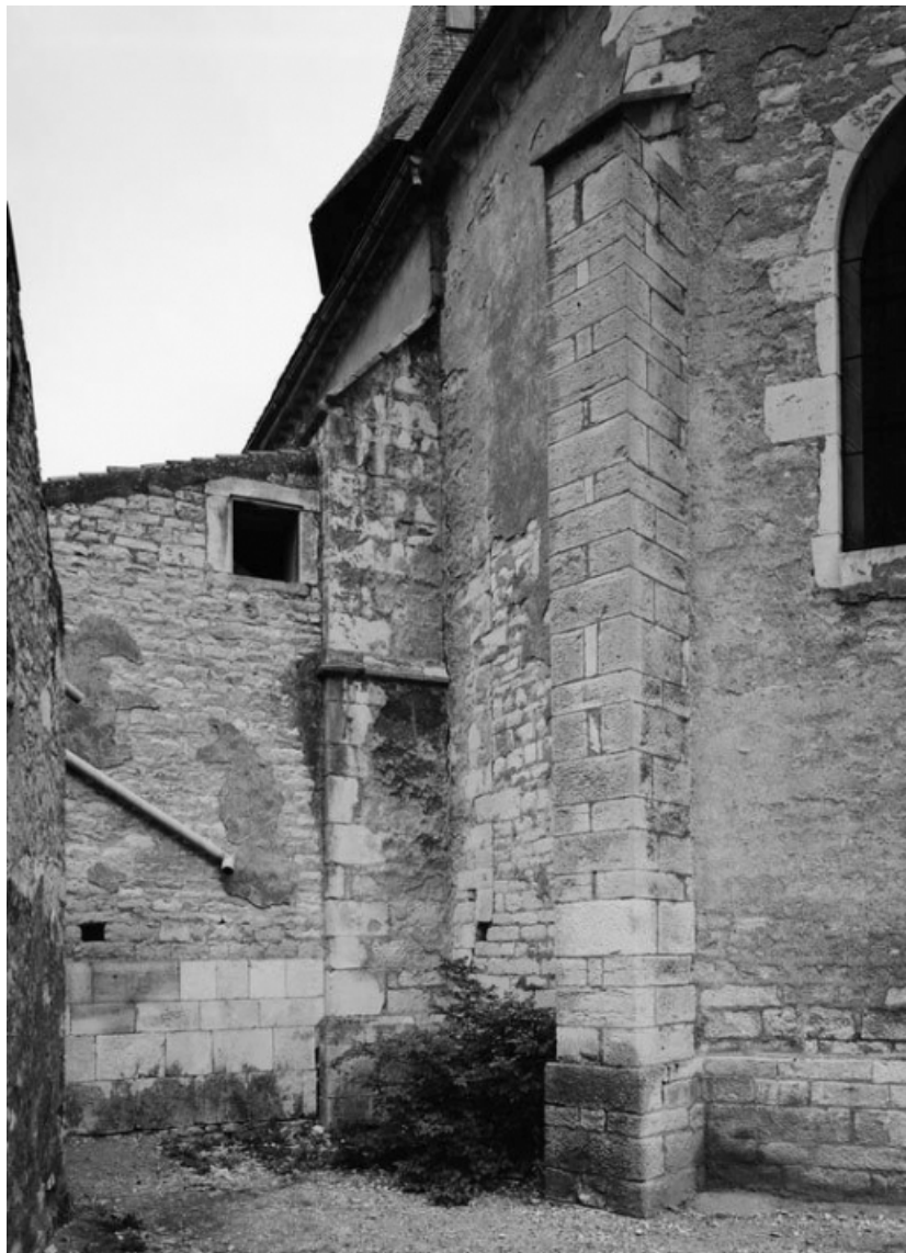
Mur droit du choeur et mur psotérieur de la chapelle droite.
