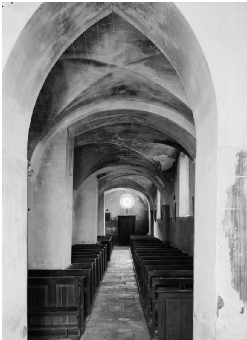
Bas-côté gauche, vue depuis la chapelle. 21, Puligny-Montrachet
