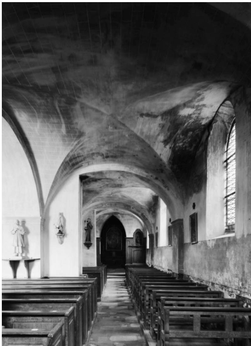
Bas-côté droit, vue depuis l'entrée.
