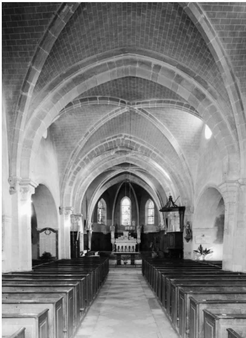
Vue d'ensemble de l'intérieur, depuis l'entrée. 21, Puligny-Montrachet
