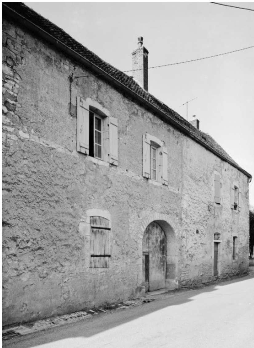
Vue d'ensemble des maisons sises parcelles 334 et 335, section AO du cadastre de 1963. 21, Puligny-Montrachet
