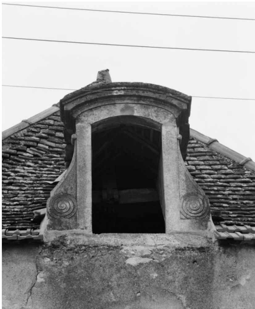
Détail de la lucarne de la maison sise parcelle 230, section AO du cadastre de 1963. 21, Puligny-Montrachet
