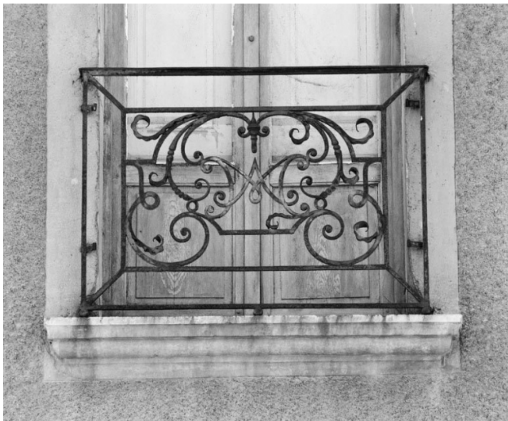
Détail de la grille en fer forgé, avec initiales entrelacées, sur une fenêtre de la maison sise parcelle 124, section AO du cadastre de 1963.
