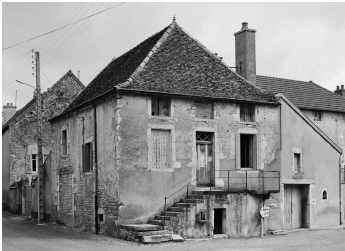
Vue d'ensemble de de la maison sise parcelle 231(b), section AO du cadastre de 1963. 21, Puligny-Montrachet
