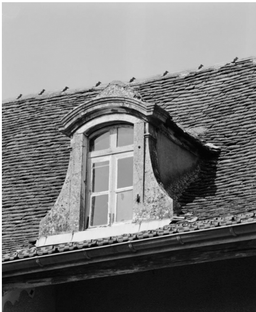
Détail de la lucarne de la maison sise parcelle 168, section AO du cadastre de 1963. 21, Puligny-Montrachet
