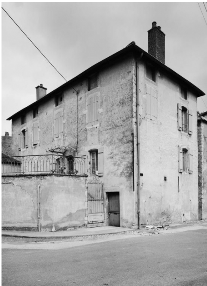
Vue d'ensemble de de la maison sise parcelle 231(a), section AO du cadastre de 1963. 21, Puligny-Montrachet
