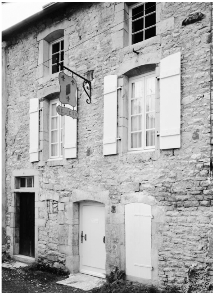
Façade de la maison sise parcelle 200, section AO du cadastre de 1963. 21, Puligny-Montrachet
