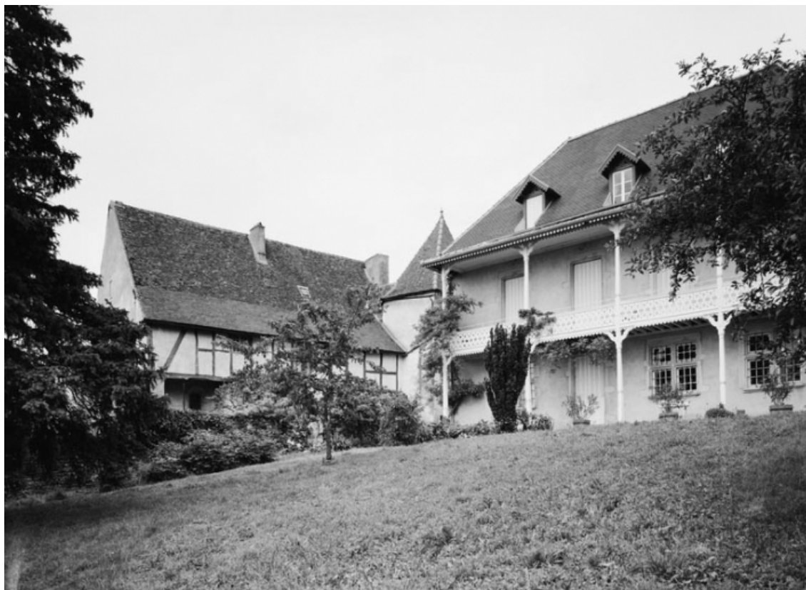
Logis et bâtiment de la chapelle.
