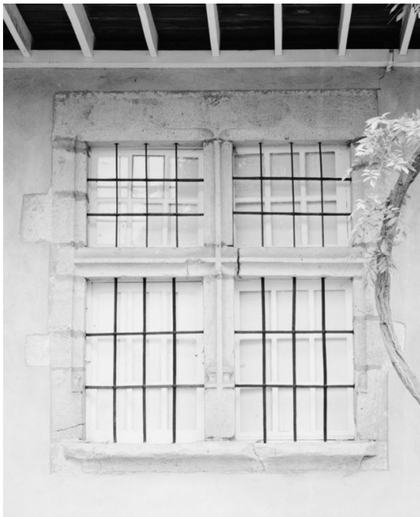
Détail de la fenêtre gauche de l'étage de soubassement du logis.
