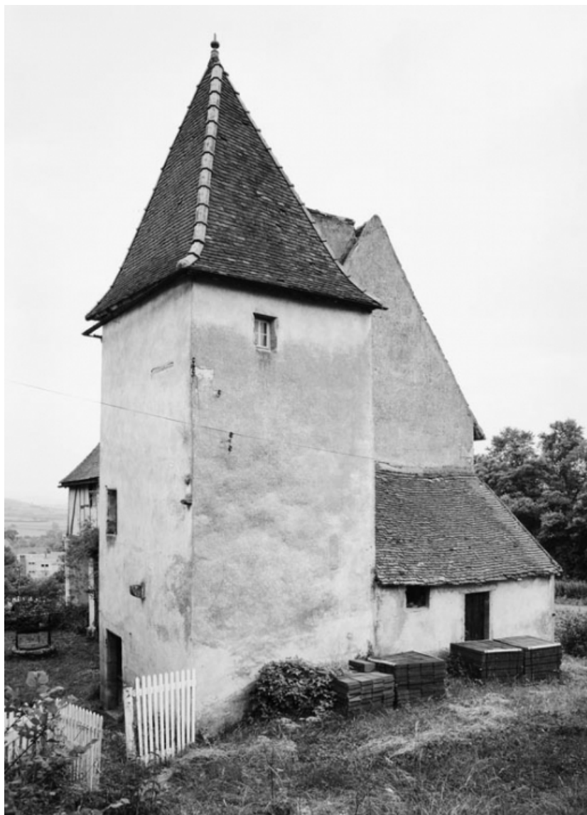
Tour du bâtiment de la chapelle.
