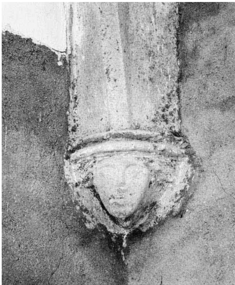
Culot postérieur droit de la nef de la chapelle.
