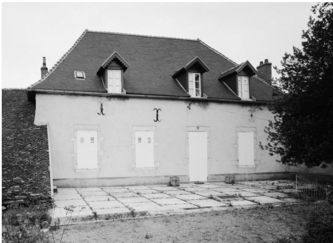
Façade postérieure du logis.
