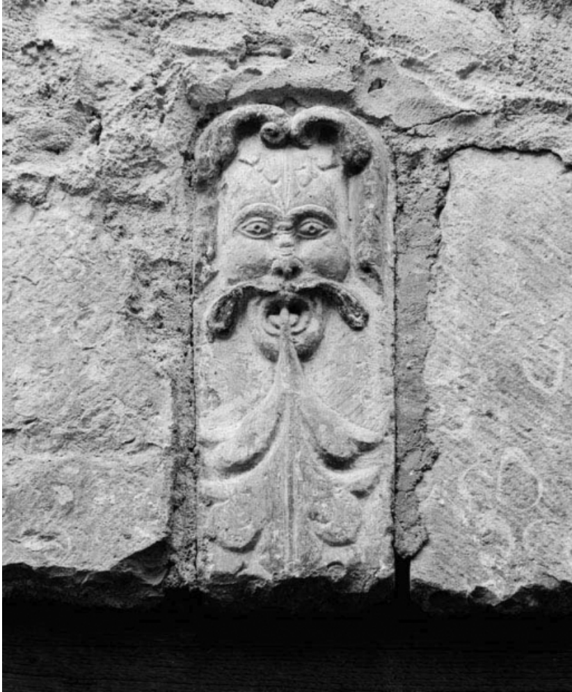
Détail de la clef de la plate-bande de la porte.
