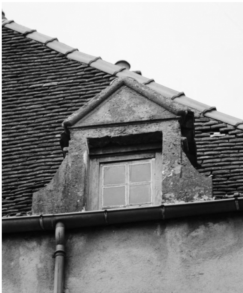
Détail d'une lucarne du versant droit du toit.
