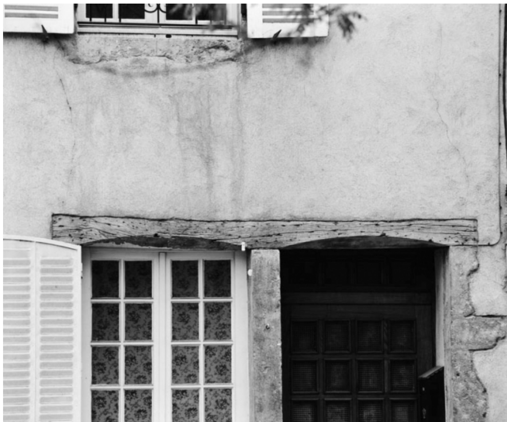
Détail du linteau de la porte et de la fenêtre gauche.
