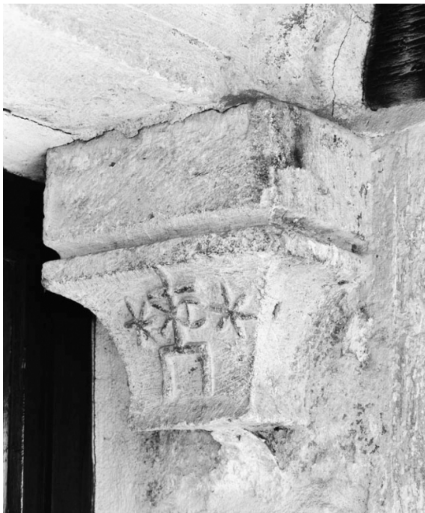
Détail du culot droit de la fenêtre à droite de la porte.
