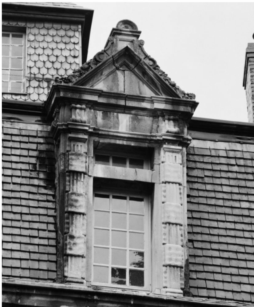
Détail d'une lucarne.
