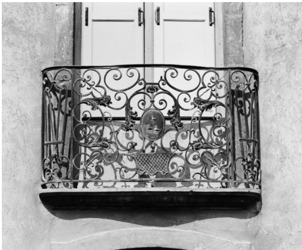
Détail de la grille du balcon.
