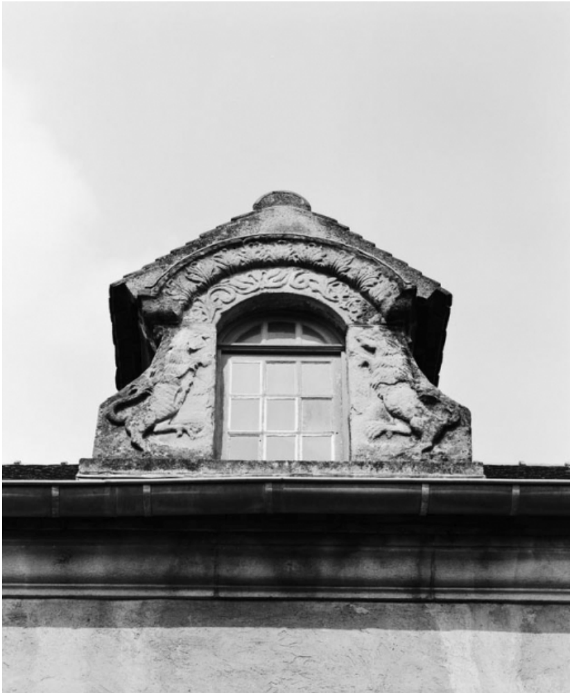
Détail de la lucarne centrale.
